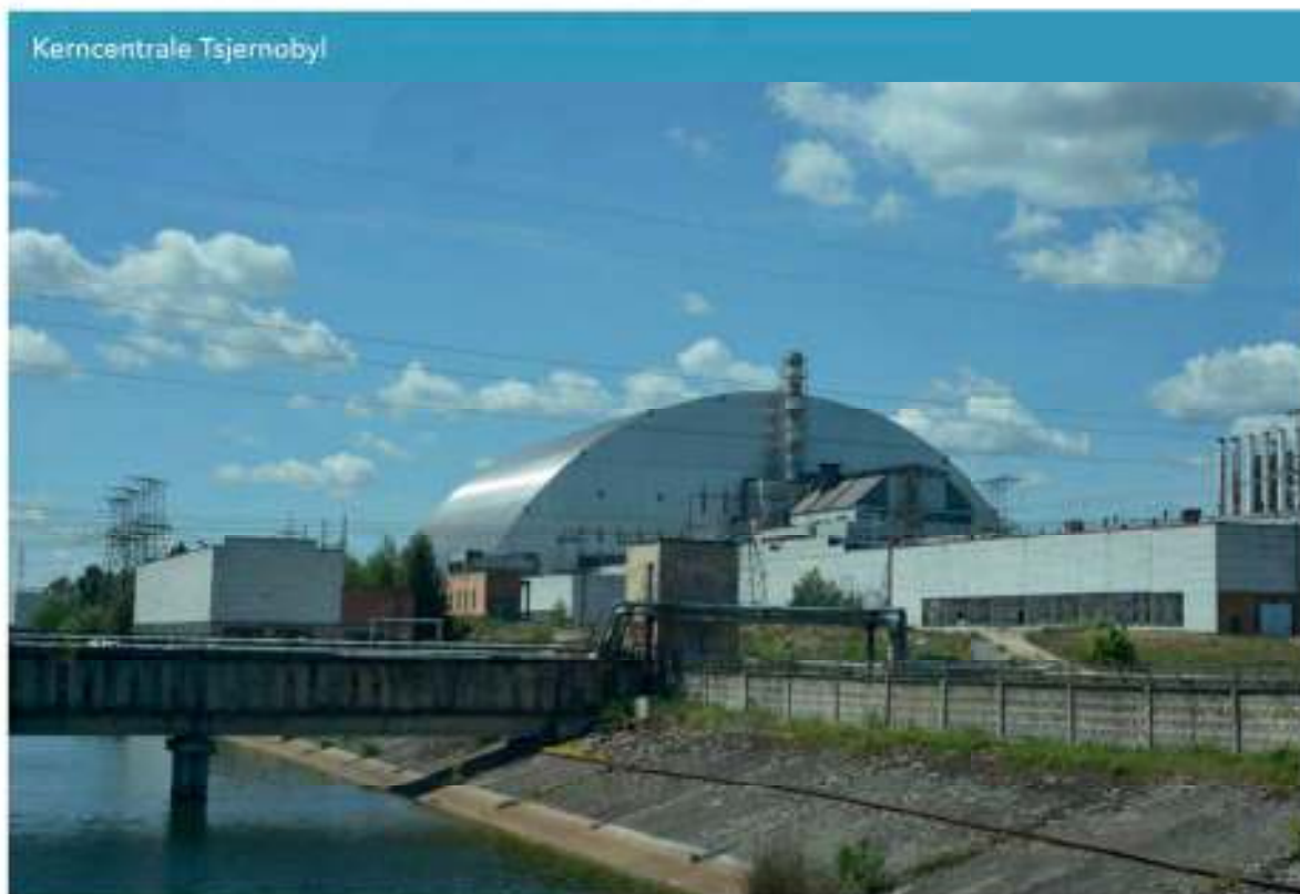
Figuur 3: Kerncentrale Tsjernobyl in 2017, waarbij de boogvormige overkapping is te zien die is geplaatst over de verwoeste reactor van de kerncentrale. (Bron: Onderzoeksraad voor Veiligheid)
