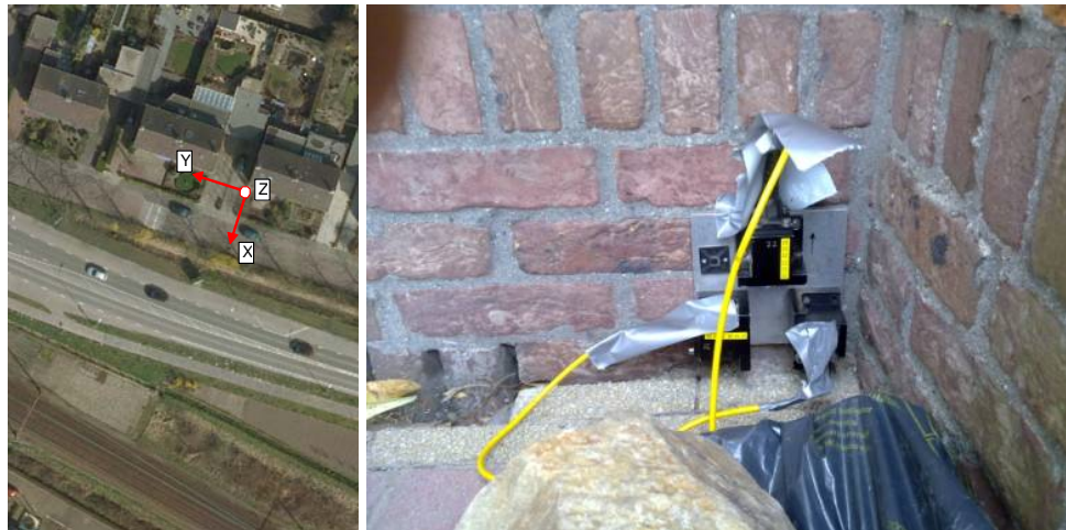
Figuur 11: Referentiepanel aan de Koningin Wilhelminastraat 5 (oost). Links: positie en richting van de versnellingsopnemers. Rechts: Versnellingsopnemers ter plekke van de fundering.
