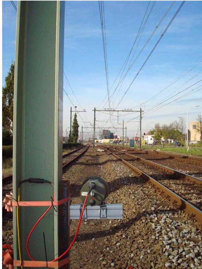
Figuur 7: Radar ten behoeve van meting van de treinsnelheden.
