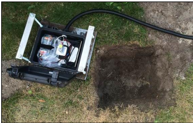
Figuur 2.2: Aanbrengen trillingsmeter in de bodem
