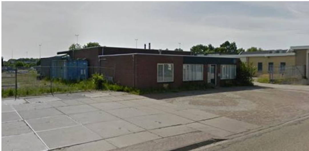
Foto 7 Linker vooraanzicht bedrijfspand (bron: Google Earth dec. 2017)
