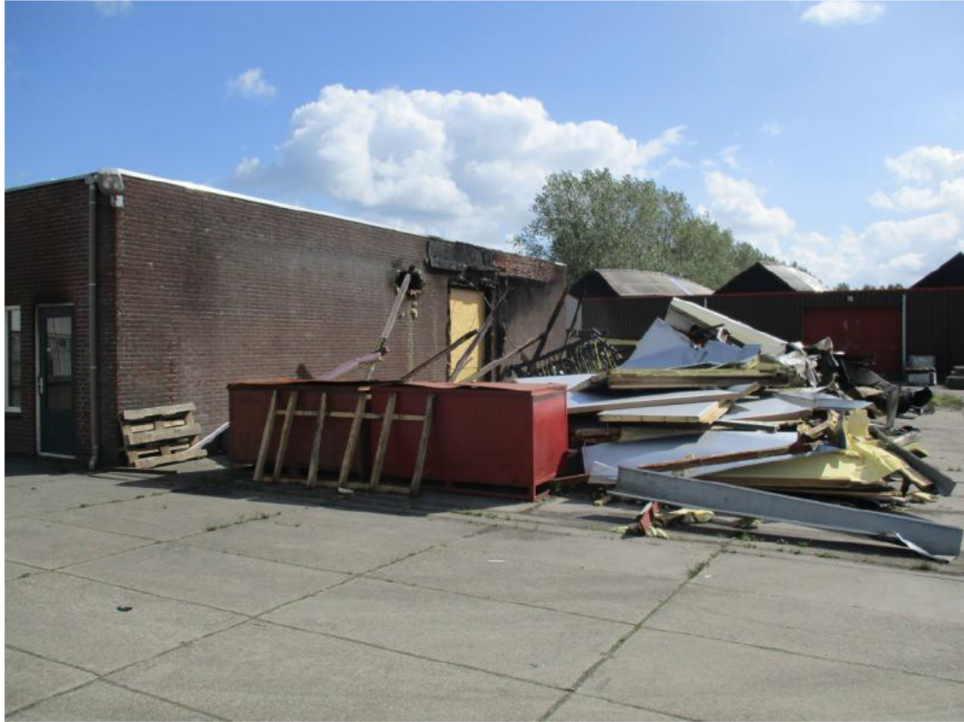
Foto 9 Achterzijde van het bedrijfspand met de afgebrande portabel units
