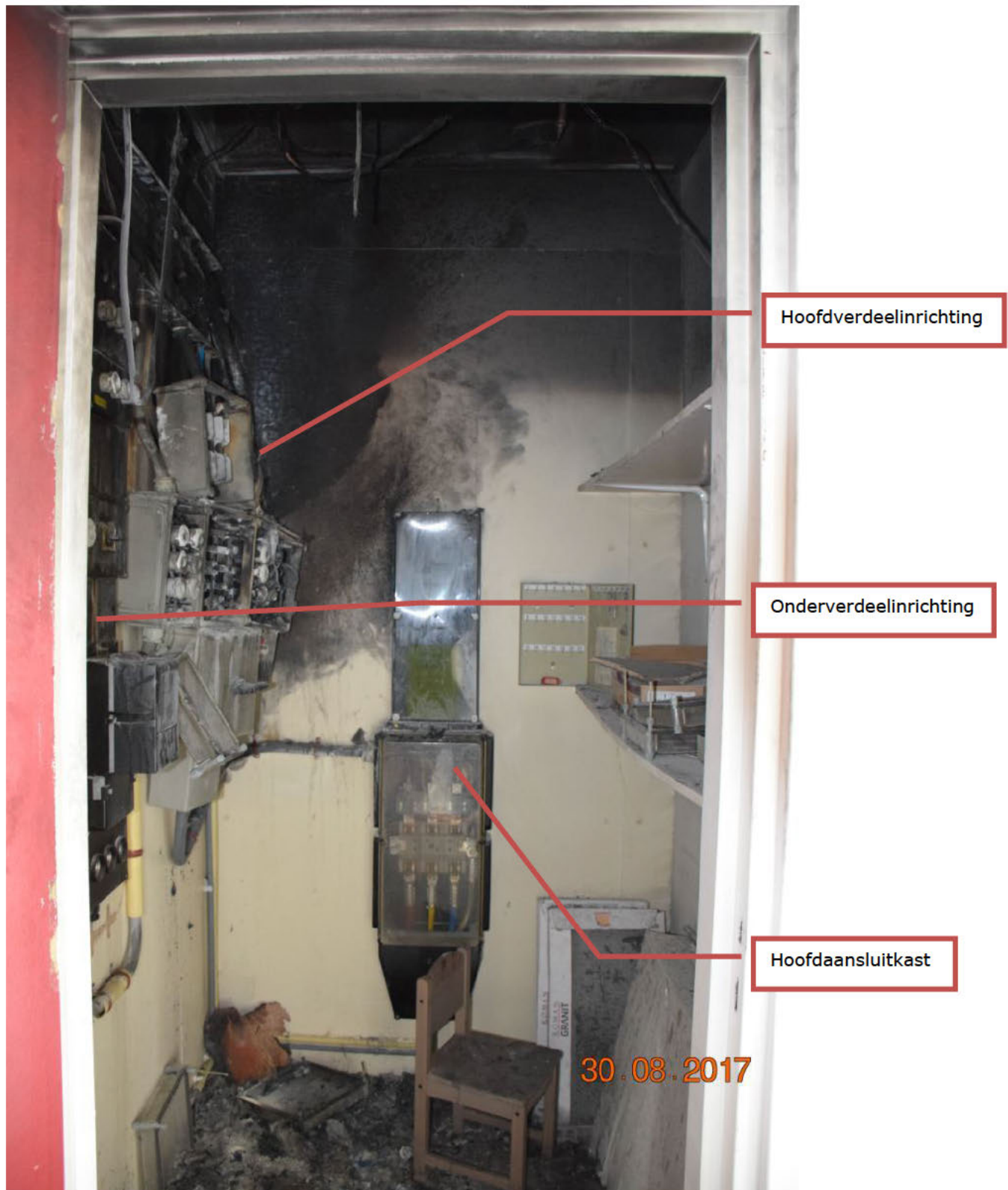
Foto 2 Binnenzijde meterkastruimte, ongevalslocatie
