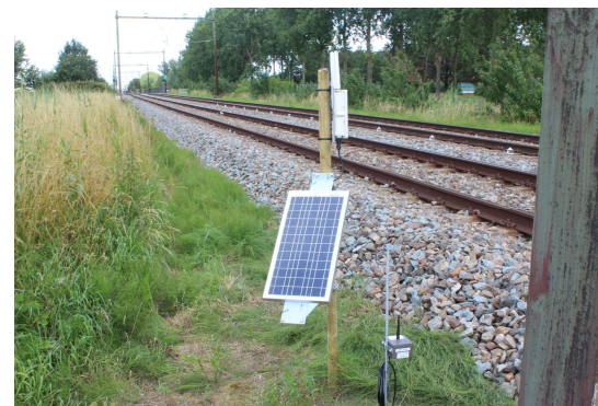
meetapparatuur die afwijkingen in de spoorligging checkt
