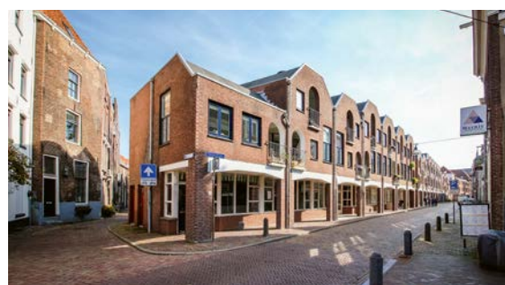
Stadsvernieuwingsproject Onder de Bogen in Zwolle van Aldo van Eyck. Foto Ruben Ferwerda
