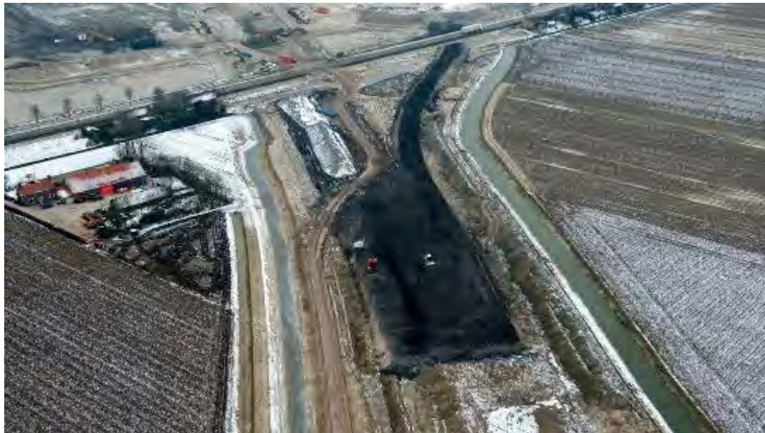
Figuur 4.10 Foto locatie 10: Aanleg A4 12 februari 2013, bron: Rijkswaterstaat
