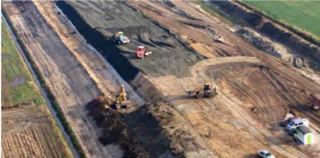
Figuur 27 Zandbaan tussen de Leijgraaf en viaduct Hoogstraat (bron: beeldbank RWS, ID269471, 20 november 2002, Joop van Houdt)
