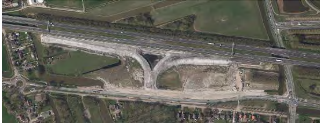
Figuur 4.22 Luchtfoto werkzaamheden aanleg afrit 7, 2016 (bron: Globespotter)
