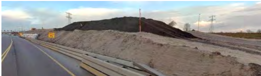
Figuur 4.21 Foto werkzaamheden N302 km 31.1, 13 januari 2016 (bron: globespotter)
