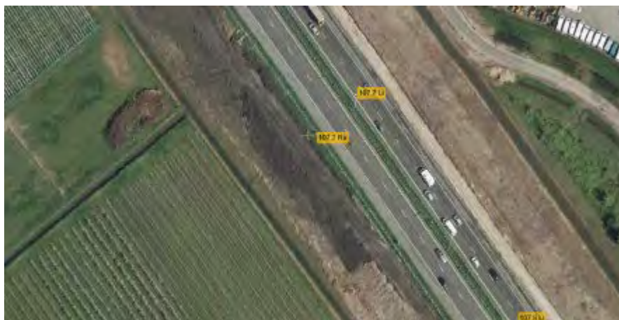
Figuur 4.1 Luchtfoto 2009 (bron: Globespotter), verbreding A2, km 107.7
