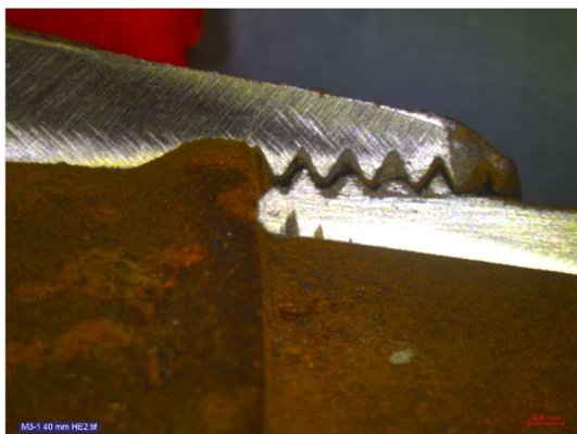
Figuur 26 M3-1 detail schroefdraad na doorzagen en opschuren.
