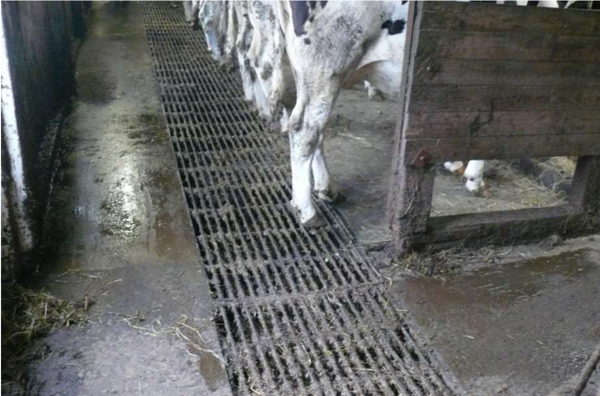
Grupstal, Door te korte standplaatsen staan runderen op de ijzeren spijlen boven de grup.
