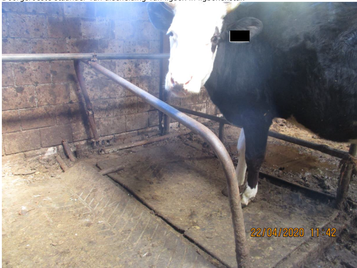
Doorgeroeste staander van afscheiding van ligbox in ligboxenstal:
