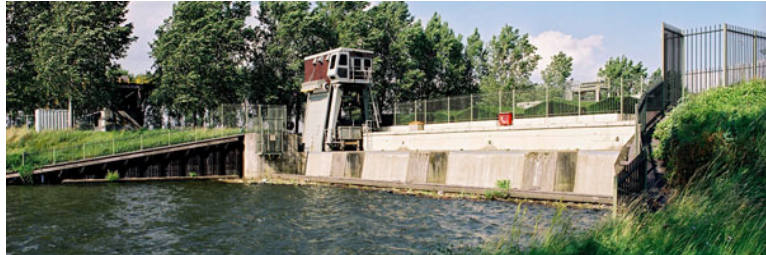
Figuur 3: de grote waterkrachtcentrale bij Linne waarin 4 Kaplanturbines
