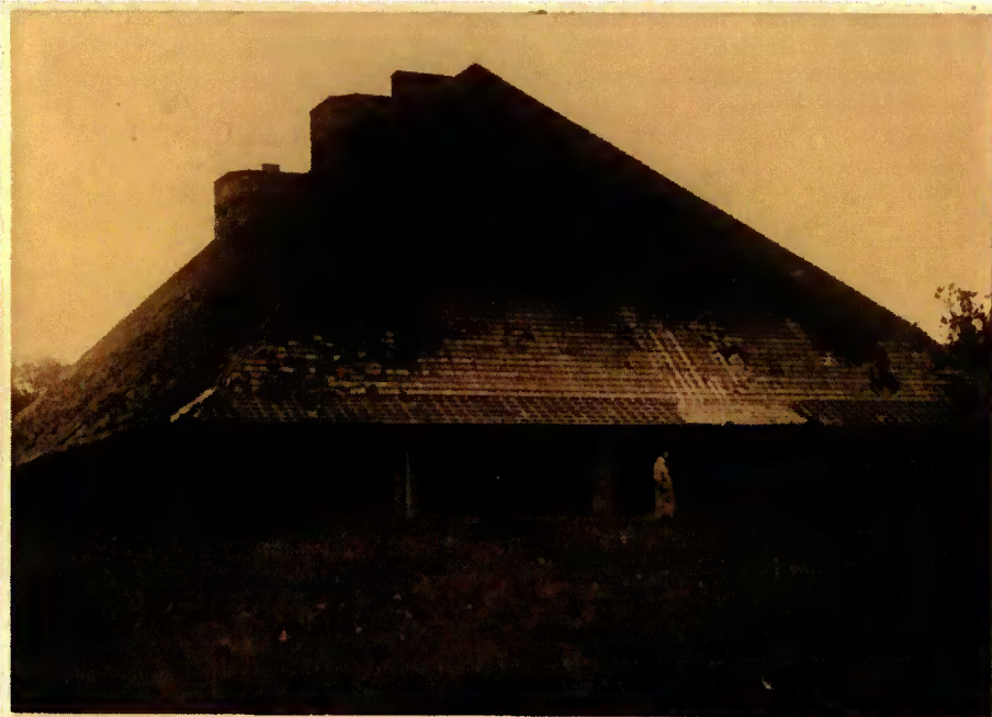
58. Foto van vlak na WOII, zicht op de noordwestzijde van de bunker. Op het dak is het grootste gedeelte van de dakpannen van het romaanse type nog aanwezig. Het gemêleerde karakter is goed herkenbaar. Ook is de camouflageschildering op de observatiepost en schoorsteen goed herkenbaar. (Herkomst: Beeldbank Haags Gemeentearchief. identif.nr. 0.80955).
