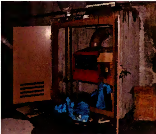
o De stoffilters en ventilatoren in de kasten 99A en 99B;
