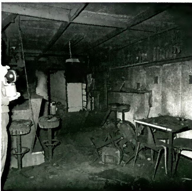
94. Schietbaan na de brand (ruimte 162C, kijkend vanuit de noordwesthoek van de rondgang, richting het oosten) op de eerste verdieping. Foto mei 1991. Op deze afbeelding is te zien dat hier een verlaagd plafond hing en tussenwanden stonden. Ook is hier een tweede bar te zien op de eerste verdieping. Op de achtergrond is de klimtrap te zien die naar de zolderverdieping leidt en staat het luik open die daar nu ook nog zit. (Herkomst: beeldbank NIMH, objectnummer 2001_91-2-02-1815-C8)
