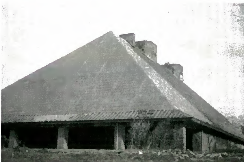
67. Het gebouw gezien vanuit het westen. Het open karakter van de gevels verhult de massieve constructie van de bunker zelf. Foto 1947 (Herkomst: Beeldbank NIMH, objectnummer 2001_7-47-01).
