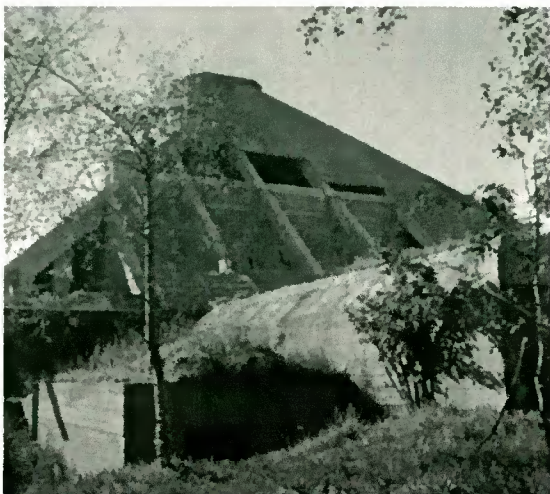
73. Het oostelijke bunkerdak met op de voorgrond de keukenbunker. Bij het dak van de hoofdbunker ontbreekt een groot gedeelte van de bimsplaten. Dit is het gevolg van de bominslag aan het einde van de Tweede Wereldoorlog. Op deze afbeelding is goed te zien hoe de bunker als een rechthoekig blok onder het schuine schilddak ligt. Foto 1947. (Herkomst: beeldbank NIMH, objectnummer 2001_N0000119-04)
