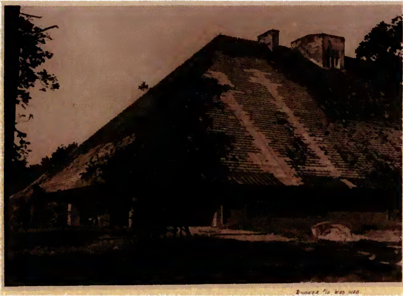
64. De bunker in 1945 gezien vanuit het zuiden. Rechts is de inrit naar de ingang van de bunker zichtbaar. Links, in het grasveld, is de loopgraaf te herkennen. (Herkomst: Beeldbank Haags Gemeentearchief. identif.nr. 6.15721).
