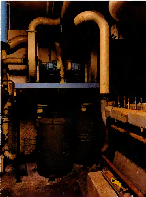
o De stoffilters en ventilatoren in de kasten 99A en 99B;
