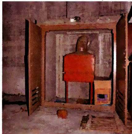
o De stoffilters en ventilatoren in de kasten 99A en 99B;
