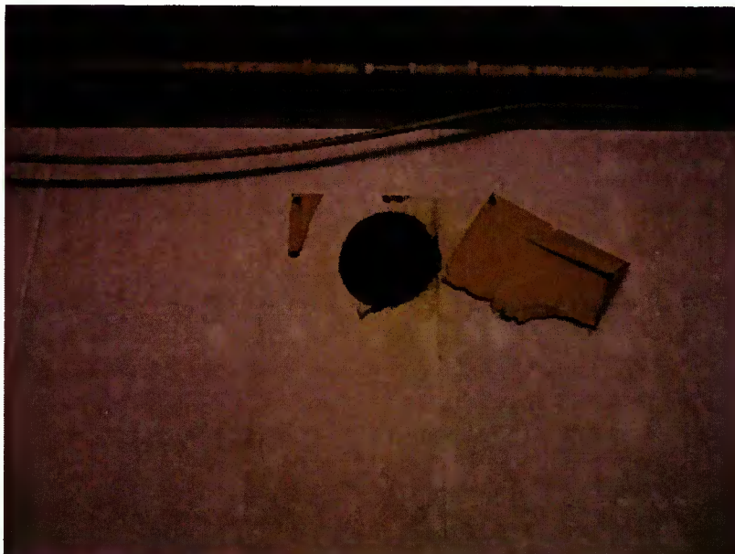
114. In ruimte 131 zit in de bunkerschil een rubberen koker, waardoor een kabel liep richting de oostelijke toren voor een antenne. Dit gat in de bunkerschil, inclusief de rubberen koker, is in de Koude Oorlog aangelegd.
