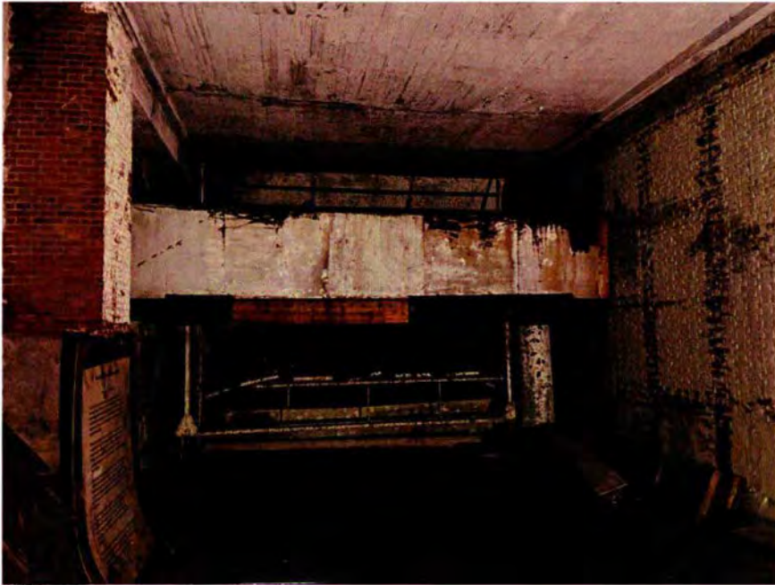
436. Ruimte 093B, gezien in oostelijke richting. Midden in beeld de stalen kogelvanger.
