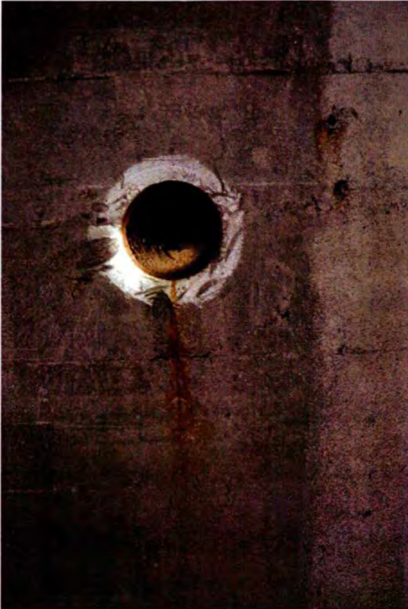
618. Ruimte 162C. Detail van een van de uitmondingen van de overdrukventielen, die in de bunker zijn aangebracht. De leidingen hebben geen recht verloop, maar bevatten een verspringing, zodat de verbinding niet recht is. De afvoer stamt uit de bouwtijd van de bunker.
