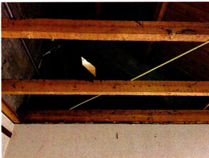
592. Ruimte 160, in noordelijke richting. Bovenin is de opening in het dak te zien waar voorheen een schoorsteen liep vanuit de garage (ruimte 094). Deze schoorsteen is verwijderd bij werkzaamheden in 2019. Verder is een betonnen spant van de dakconstructie te zien.
