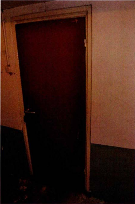
585. Ruimte 158. De deur in de noordwand heeft aan de onderzijde een rooster voor de luchtafvoer. Het deurkozijn stamt uit de bouwtijd, de deur uit de KO-periode (1948).
