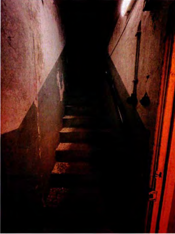
558. Ruimte 148, trap richting zolder. Gezien naar het oosten.
