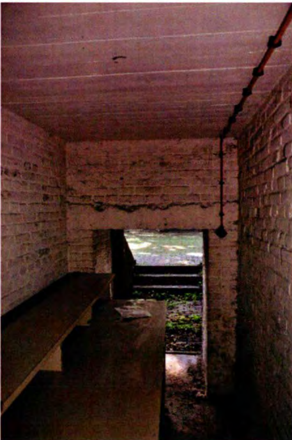
415. Het meest oostelijke deel van gang 096, gezien in zuidelijke richting, met een van de twee toegangen tot dit bouwdeel. De huidige toegangsdeur zal ten tijde van de KO zijn geplaatst. Bij de opening is te zien dat die aan de westzijde (rechts) naderhand met een halve steen is versmald. Eenzelfde situatie is aangetroffen bij de toegang aan de westzijde.
