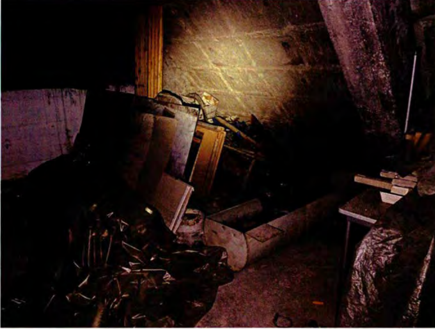
614. Ruimte 162C, gezien richting het zuiden. Hier hebben rommel en restanten van de voormalige schietbanen in ruimte 162C zich opgehoopt, zoals tafels en bekleding.
