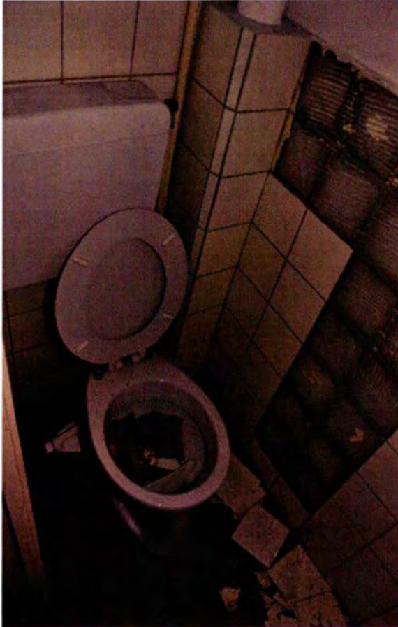
514. Het interieur van wc-ruimte 138B. De closetpot is waarschijnlijk in 1988 geplaatst. Het tegelwerk is vermoedelijk ouder.
