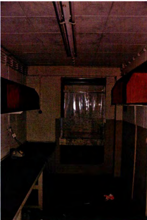
541. Ruimte 142, gezien in westelijke richting. Rechts, in de hoek is de rechthoekige leiding van de luchtbehandeling zichtbaar, die hier in de KO is geplaatst (circa 1964).
