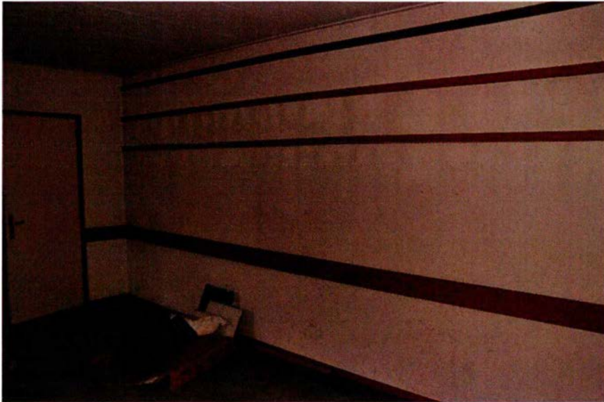
595. Ruimte 160, gezien naar het zuidwesten.
