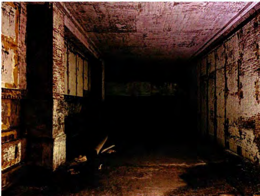
435. Ruimte 093B. Overzicht van de ruimte in oostelijke richting. Oorspronkelijk was de wand aan de linkerzijde (de noordwand) open. In 1969 is de galerij met een muur dichtgezet. Tevens is toen de vloer
