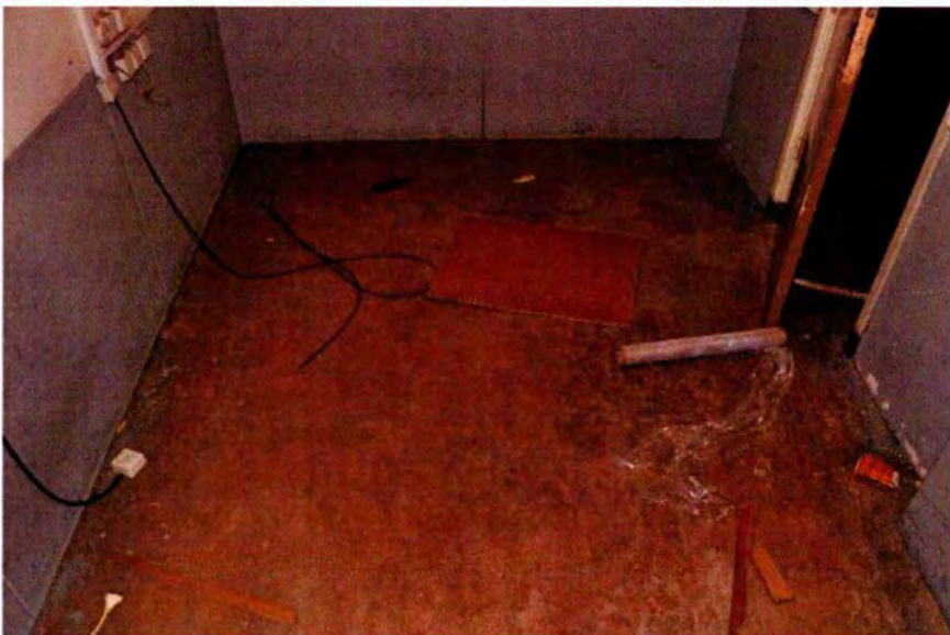
493. De magnesienvloer in ruimte 132. Deze vloer is vermoedelijk bij de verbouwing van circa 1948 aangebracht.
