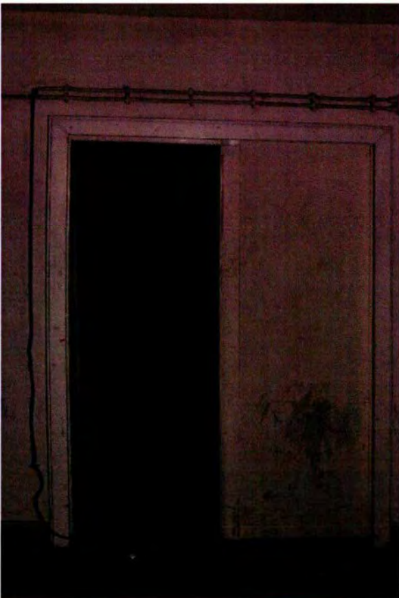
554. Ruimte 146. De toegangsdeur is als schuifdeur uitgevoerd; dit in tegenstelling tot bijna alle andere deuren, die aan scharnieren zijn afgehangen. Vermoedelijk was er onvoldoende ruimte om de deuren open te laten draaien.
