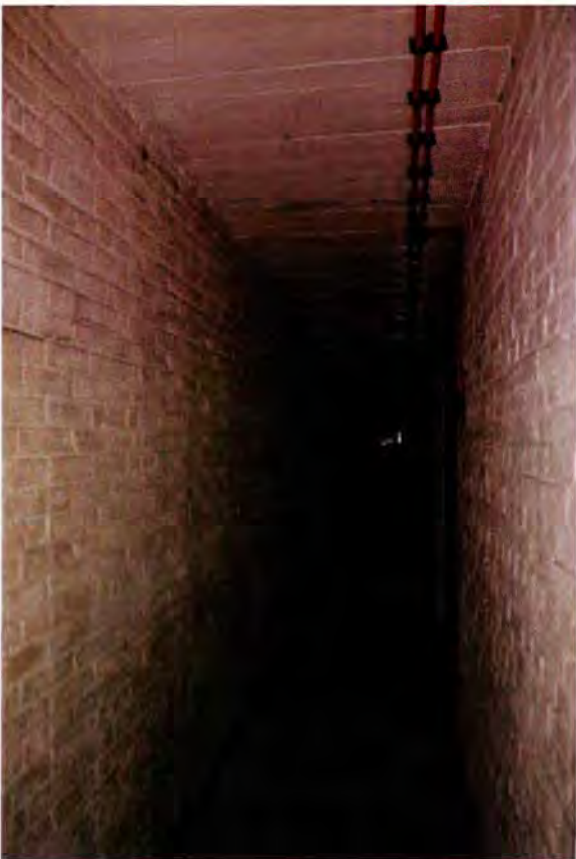
413. Ruimte 096. Het noordelijke deel van de gang gezien in oostelijke richting. Op de achtergrond zijn bij de vloer de kabels zichtbaar die hier in 1986/1987 zijn gelegd ten behoeve van het verbindingscentrum in de ruimten 028 en 030B. Aan de linkerzijde de in halfsteens verband opgetrokken beklamping van de hoofdbunkergevel. Bij de bouw van de bunker was hier een spouwmuur als beklamping opgetrokken. Deze is ter plaatse van de gang bij de verbouwing gesloopt en vervangen door een in halfsteens verband opgetrokken klamp. Aan de rechterzijde is de stalen deur uit de KO zichtbaar die ruimte 002B ontsluit.
