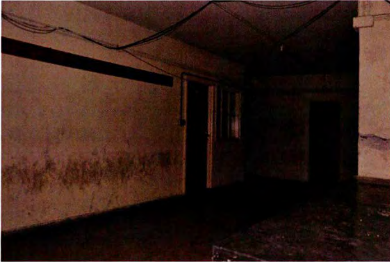
473. Het oostelijke deel van de ruimte 101A. De foto is genomen vanaf de trap aan de oostzijde van de verdieping. Het venster midden op de foto behoort bij de oorspronkelijke opzet. Mogelijk was de wacht in het achterliggende vertrek ondergebracht. De deur rechts, met bijbehorende wand is in de KO (1948) tot stand gekomen. Oorspronkelijk was hier een grote gangnis.
