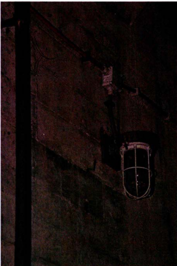
609. Ruimte 162B. Tegen de noordwand zijn op regelmatige afstand lampen aangebracht. In de KO-periode, waarschijnlijk tijdens de herstel- en verbouwwerkzaamheden rond 1948, is een deel van de bekabeling vervangen. Mogelijk zijn ook de armaturen zelf vervangen. Naast de aansluiting van de huidige armaturen op de betonwand is de aftekening van een oudere verlichting zichtbaar.
