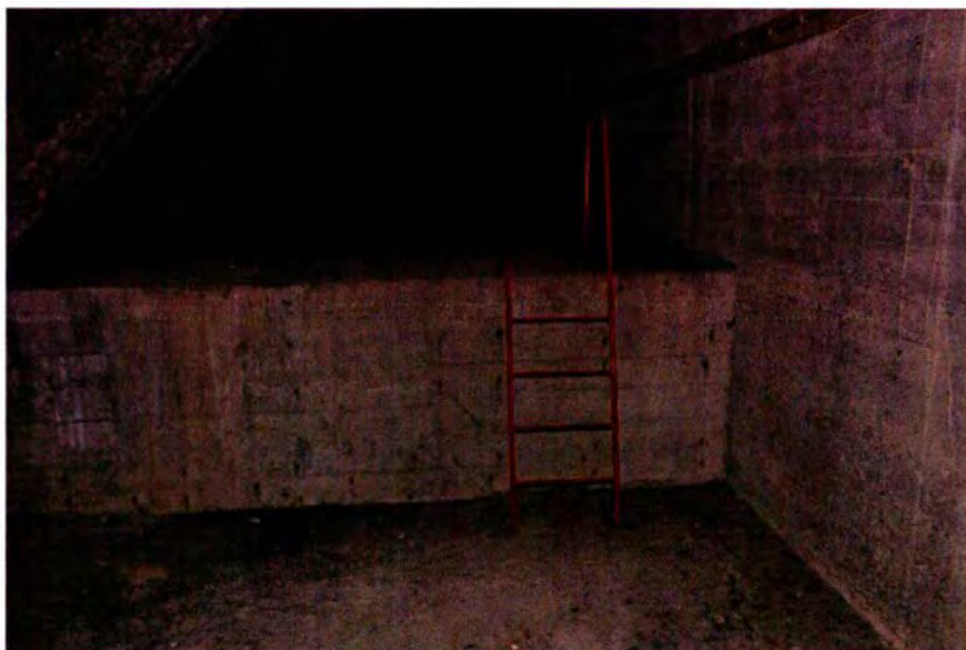
607. Ruimte 162B. Het verhoogde deel van de vloer ter plaatse van de zuidelijke toegang tot de bunker. De ijzeren trap dateert uit de bouwtijd van de bunker.
