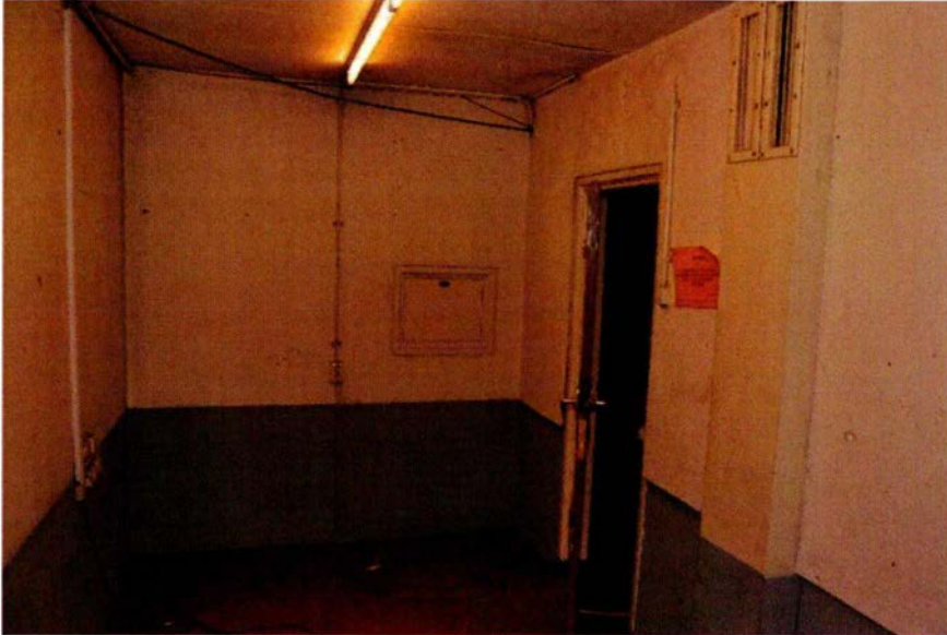
492. Ruimte 132, gezien in oostelijke richting, met in de oostwand een doorgeefluik voor berichten naar ruimte 133. Rechts naast de toegangsdeur is de dubbele luchtaanvoer uit circa 1964 zichtbaar.
