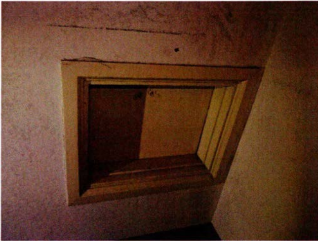
505. Ruimte 136, gezien in oostelijke richting. Het doorgeefluik naar ruimte 137 voor het berichtenverkeer (1964).
