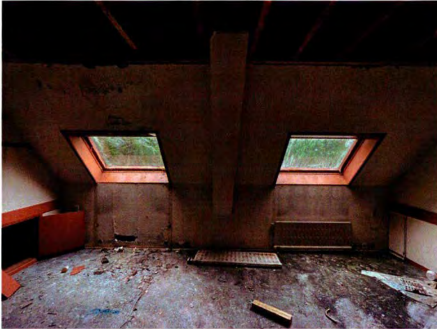
593. Ruimte 160. De oostwand met twee dakramen (1988). Bovenin is de verwijderde zoldering zichtbaar. Links het luik dat toegang geeft tot ruimte 162D.
