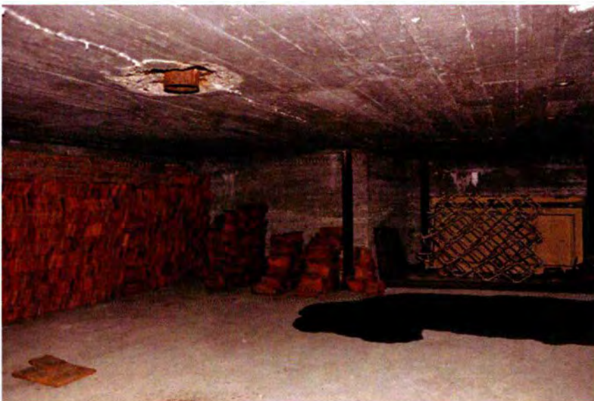
449. Ruimte 80. Gezicht op de westwand, met links de zuidwand. In het midden is een naar voren springend deel van de betonwand zichtbaar. Deze is het gevolg van de haakse plaatsing van de ingang naar ruimte 097. Geheel rechts en in het midden zijn drie van de ventilatiepijpen te zien die horen bij de onderliggende ruimten.
