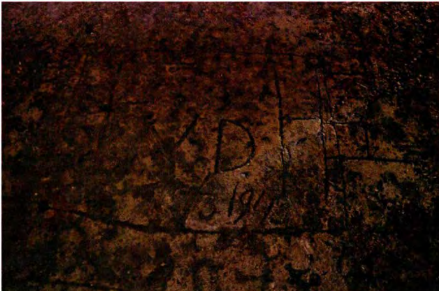
459. Ruimte 80A. Een van de twee inscripties die in de verse beton van de zijwand zijn gekerfd. Te zien zijn de initialen van de maker (F v D) en de datum van voltooiing (15-3-1943).
