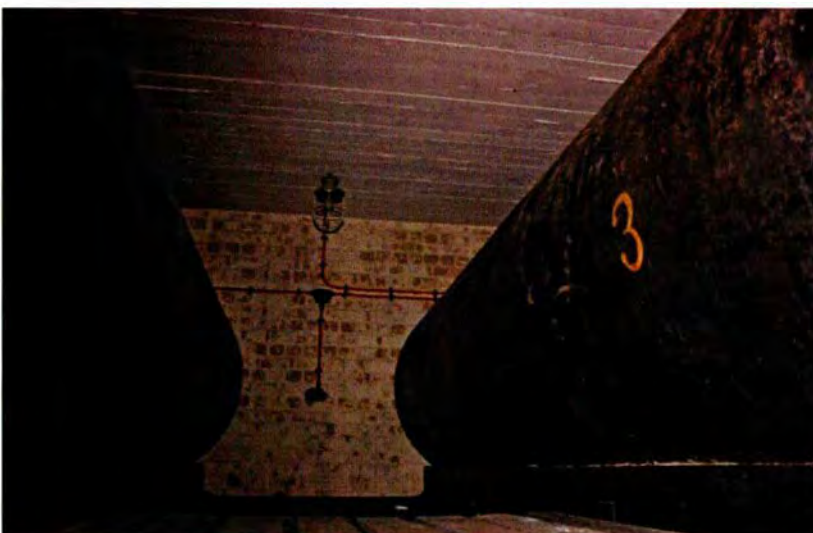
424. Ruimte 097. Detail van de twee bovenste tanks, met daarop geschilderd de cijfers 2 en 3. Te zien is dat de westwand van het vertrek met baksteen is opgetrokken. De wand is als klamp tegen het beton van de zuidelijke ingangspartij van de hoofdbunker geplaatst. De wand zal zijn opgetrokken om het gewapend betonnen dak te dragen.
