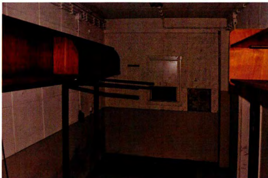
543. Ruimte 143, gezien naar het westen. In de westwand is een doorgeefluik voor berichten opgenomen, richting ruimte 144 (1948). In tegenstelling tot de hiervoor besproken doorgeefluiken is hier een verticaal bewegende schuif aanwezig. Rechts is een klein deel van de toegangsdeur in de noordwand zichtbaar.
