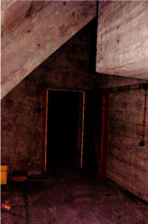
643. Ruimte 201. Zicht op de stalen gasdeur in de westwand. De deur en de gepleisterde baksteenmuur zullen nog uit de bouwtijd van de bunker dateren.
