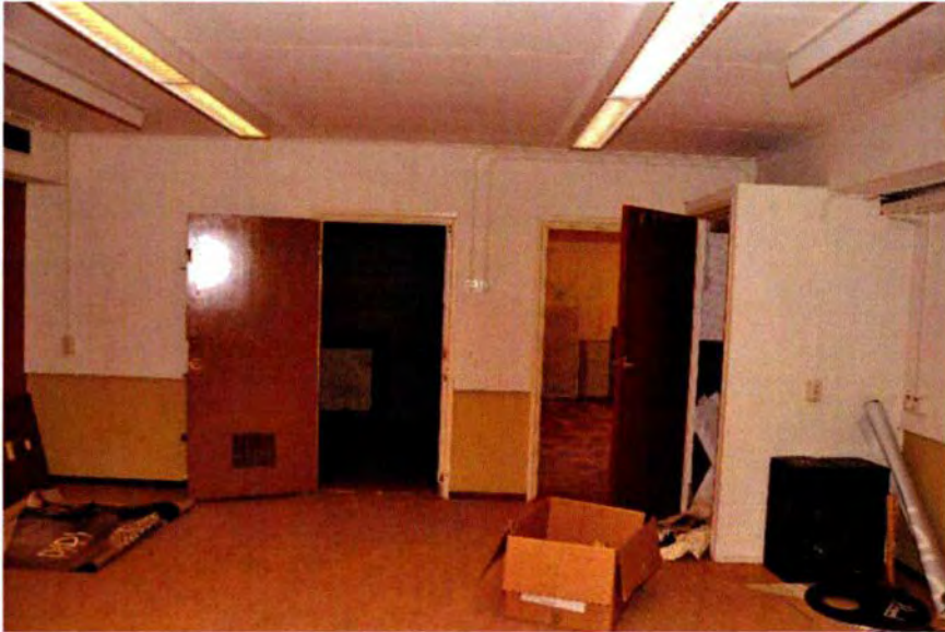
516. Ruimte 139. De oostwand met in het midden de toegangsdeur, waarvan het kozijn uit de bouwtijd dateert. Door de deuropening is het oostelijke trappenhuis zichtbaar. Het rechter deurkozijn is ook oorspronkelijk. De deur geeft toegang tot wat op de tekeningen na WOII als radiatoruimte staat vermeld (ruimte 139A). In de rechterhoek staat een vaste kast (ruimte 139B) uit de KO-periode (circa 1964).
