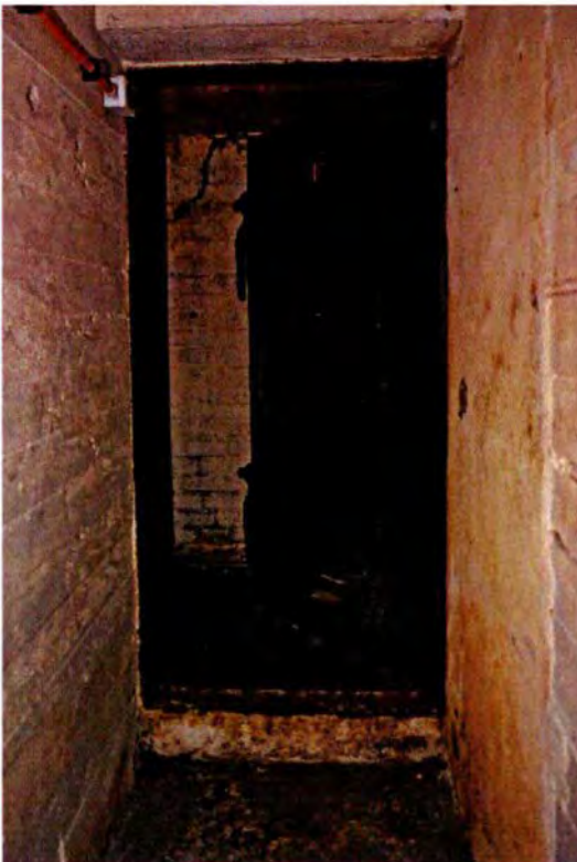
419. De toegang tot ruimte 097, gezien van binnenuit. De toegang wordt door een stalen deur afgesloten. Deze deur zal nog uit de WOII-periode dateren. Links is op de betonmuur de aftekening van de bekisting zichtbaar. Aan de rechterzijde is te zien dat het buitenste deel van de dagkant is gepleisterd. Geheel rechts is de grens te zien van het pleisterwerk en het zichtbare betonwerk. De aftekening van bekistingshout laat ook kraaldelen zien. Men heeft bij de bouw dus gebruik gemaakt van sloopmateriaal.
