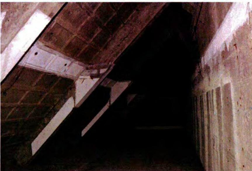
617. Ruimte 162C, gezien naar het noorden. De witte aftekeningen op de spanten en de bimsbetonnen platen houden verband met de schietbaan die hier ondergebracht was. De witte delen waren de toen zichtbare delen van de balken, dakplaten en de bunkermuur. De rest was afgedekt met een wandbekleding en een ingehangen plafond. Op foto's van het NIMH (zie ook deel 1) is te zien hoe daarmee een afgesloten ruimte met enige geluidsisolatie was gevormd. Na de brand in ruimte 093B in 1991 is de schietbaan ontmanteld en is ook deze ruimte geheel gestript. De gaten in de bimsbetonplaten dienen voor de ventilatie.
