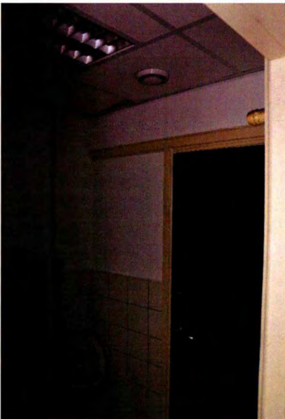
513. De scheidingswand tussen de vertrekken 138A en 138B. De bovenzijde van het deurkozijn is een doorlopende houten profiellijst. Onder deze lijst is de wand als baksteenmuur uitgevoerd, erboven als stijl en regelwerk met een bepleistering. Oorspronkelijk (1942) zal de wand niet verder hebben doorgelopen dan de houten lijst. In de KO-periode heeft men de tussenruimte dichtgezet.
