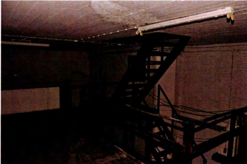
463. Ruimte 93G in zuidoostelijke richting, met de houten trap die de verbinding vormt tussen de verschillende lagen van de zijruimten. Achter de trap is de noordwesthoek van de bunker zichtbaar. De aansluitende wanden links en rechts horen bij de dichtzetting van de galerij onder het overstekende bunkerdak.
