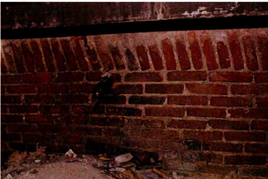
461. Ruimte 80A. Detail van het metselwerk van de noordwand ter plaatse van het luik dat toegang geeft tot de ruimte. Hier is in de muur een buis met een kraantje geplaatst. Waartoe dit kraantje heeft gediend is niet bekend.
