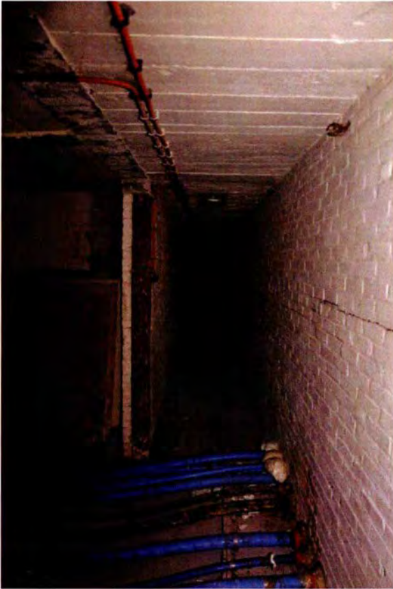
414. De gang 096, gezien in westelijke richting. Op de voorgrond de in 1986/1987 aangelegde kabels voor het communicatiecentrum in de bunker. Rechts de in halfsteens verband uitgevoerde beklamping van de bunkerwand.
