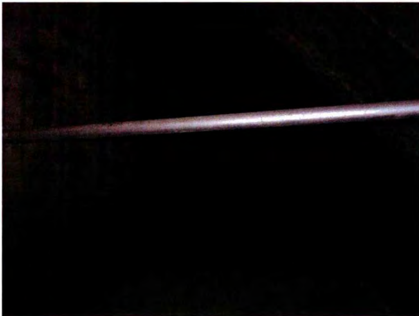
635. Ruimte 162D, gezien naar het westen. De door het beeld loopt een buis van een overdrukventiel.
