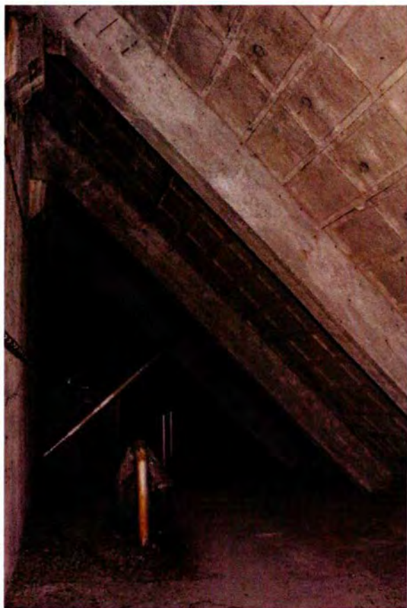
606. Ruimte 162B, gezien naar het oosten. De beide diagonale pijpen zijn de luchtafvoerpijpen van de dieselmotoren in de machinekamer (ruimte 020). Tussen deze pijpen is bij de modernisering van de luchtbehandelingsinstallatie (1964) een betonnen kast voor de aanvoer van verse lucht geplaatst (99A). De pijp op de voorgrond is de ontluftung van de ruimte waar een water- of olieopslag was gesitueerd (ruimte 097).
