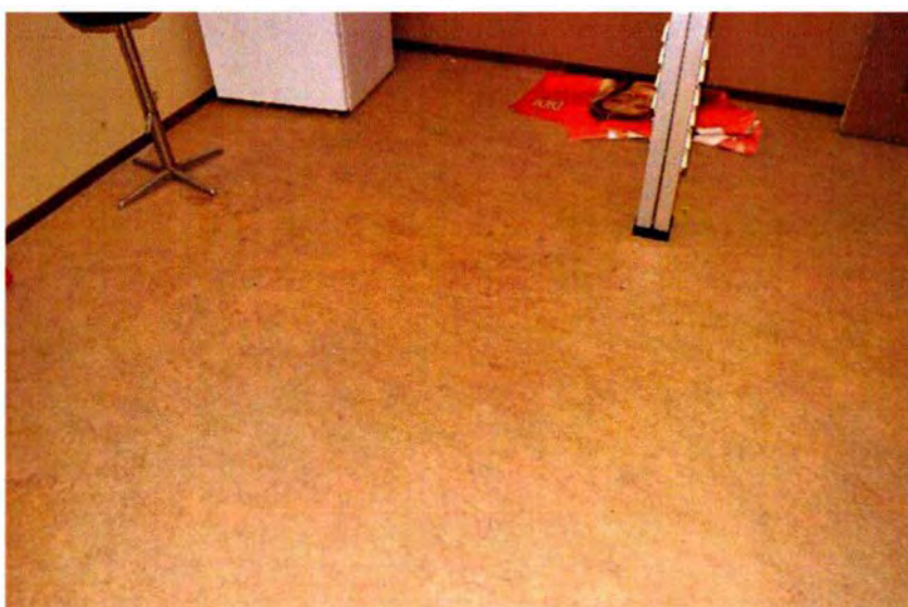
520. Ruimte 139. De vloer met linoleum, waar in de WOII-periode nog parket lag.
