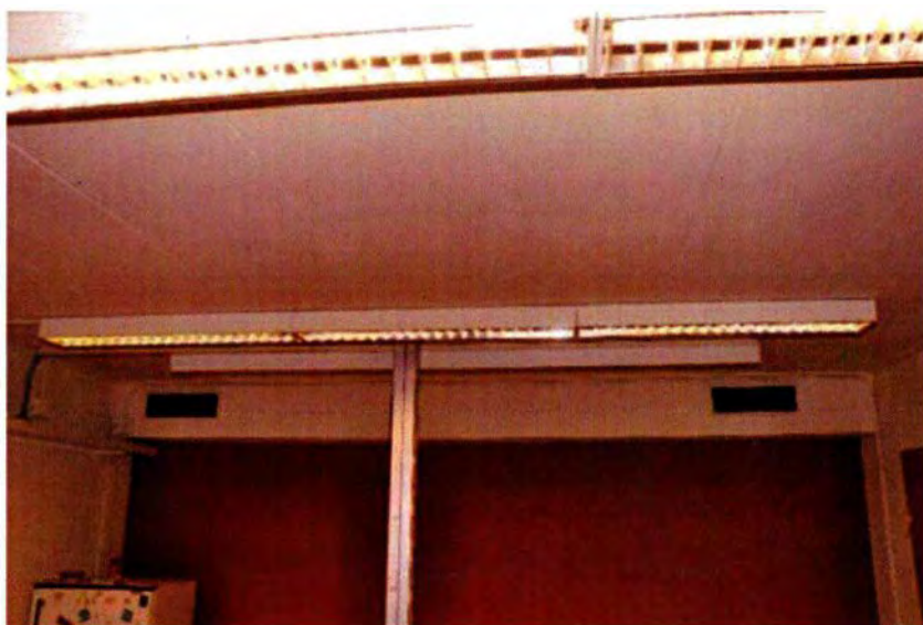
519. Het plafond van ruimte 139. De in gewapend beton uitgevoerde bovenzijde van de bunker is afgewerkt met zachtboardplaten. De verlichting wordt verzorgd door lichtbakken met tl-buizen. Alles aangebracht in de KO (circa 1964).
