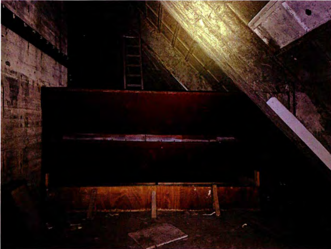
616. Ruimte 162C, richting het zuiden. Zich op de metalen kogelvanger (circa 1976). Deze werd gevuld met zand om de naar beneden geketste kogels op te vangen. Op de kogelvanger is te zien dat deze drie doelen had. Links boven is nog een houten plank te zien die onderdeel was van het plafond van deze schietbaan.
