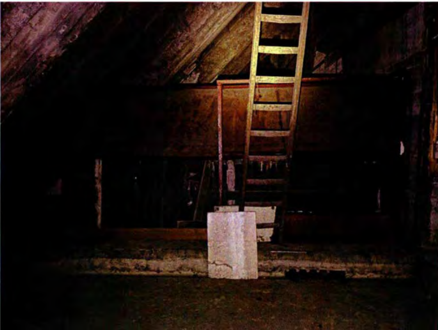
615. Ruimte 162C, gezien richting het noorden. Zicht op de achterkant van de kogelvanger die hier is geplaatst tijdens de KO (circa 1976) voor de achtergelegen schietbaan. Op de voorgrond nog enkele zachtboard platen die voorheen op de wanden waren bevestigd voor geluidsisolatie. Na de brand in de schietbaan in 1991 is de gehele wandbekleding van de schietbanen verwijderd.
