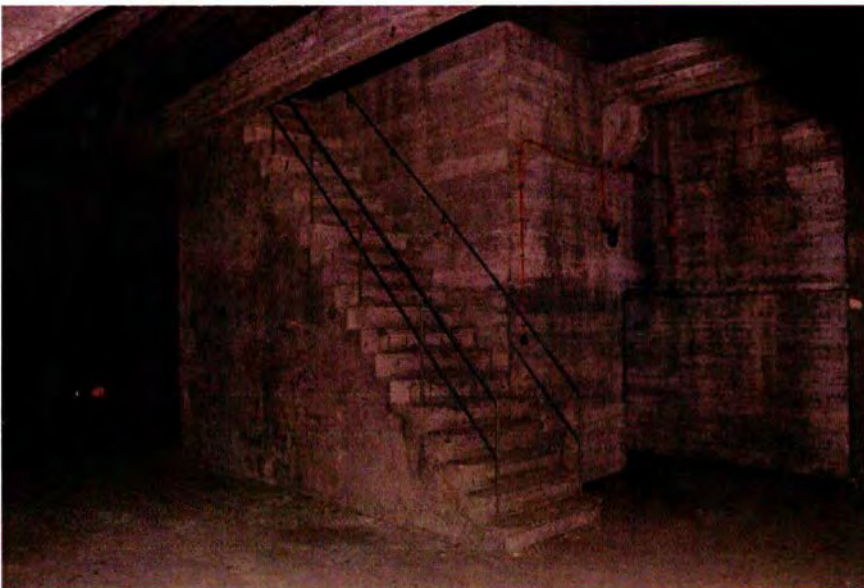
653. Ruimte 202, gezien in noordoostelijke richting. Op de voorgrond de betonnen trap met ijzeren leuning die naar de observatieposten leidt. De gehele hier zichtbare constructie dateert uit de bouwtijd van de bunker en is in het werk gestort.
