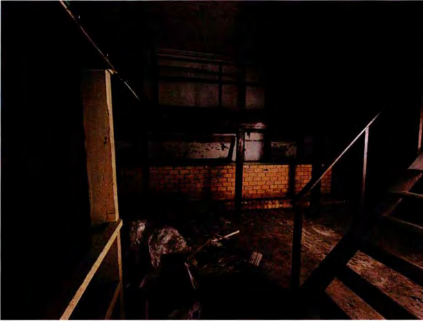
430. Ruimte 093A, gezien richting het noorden vanuit de entree deur vanuit ruimte 093. De houten tussenverdieping is omstreeks 1971 aangebracht. Daaronder de stenen bar. Na de brand in de schietbaan in 1991 is de gehele schietbaan gestript en leeggehaald, inclusief de barruimte.
