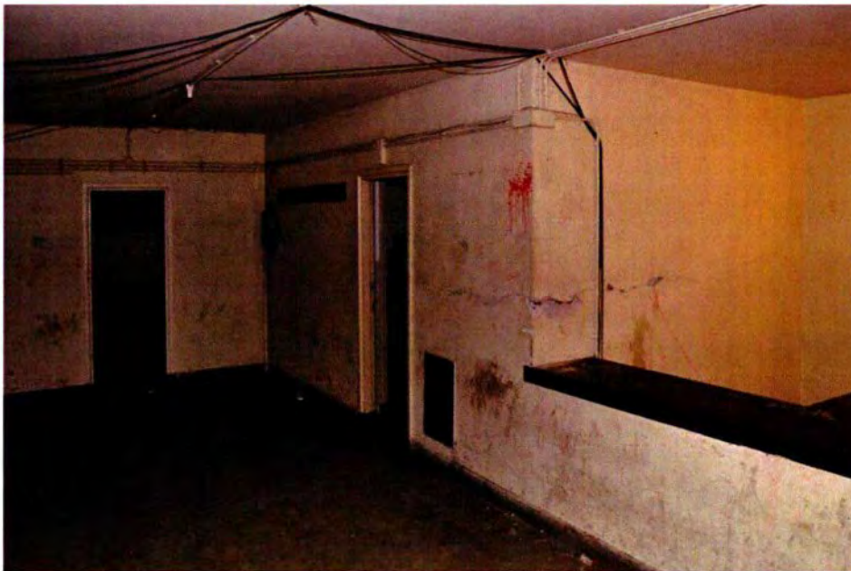
474. Het noordoostelijke deel van de gangruimte 101A, met links de wand met deur waarmee in de KO (1948) de oorspronkelijke gangnis is dichtgezet. De deur rechts geeft toegang tot de wasruimte voor de heren (ruimte 138).
