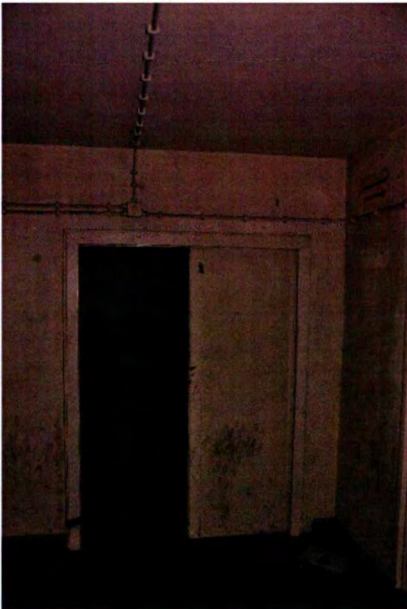
547. De toegang tot ruimte 144, gezien vanuit de gang. De deur is als schuifdeur uitgevoerd. Vermoedelijk was er niet voldoende ruimte om de deuren open te laten draaien. Dit in tegenstelling tot bijna alle andere deuren, die aan scharnieren zijn afgehangen.
