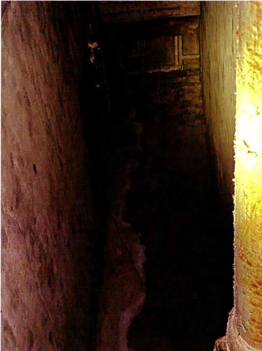
648. Ruimte 201, de noordoosthoek naar boven gezien. Hier zit een gat voor de luchtuitlaat. Deze leidt naar de tussenruimte boven ruimte 401, waarna de vieze lucht via de ventilatieroosters in de oostelijke toren de bunker kan verlaten.
