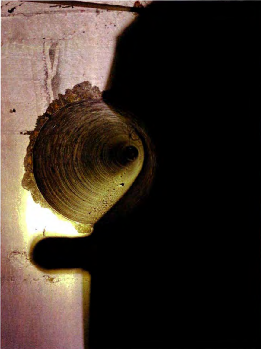
626. Ruimte 162C, in zuidelijke richting. Zicht op de noordmuur van de bunker. Een detail van het gat in de bunkerschil ten behoeve van een kabel.
