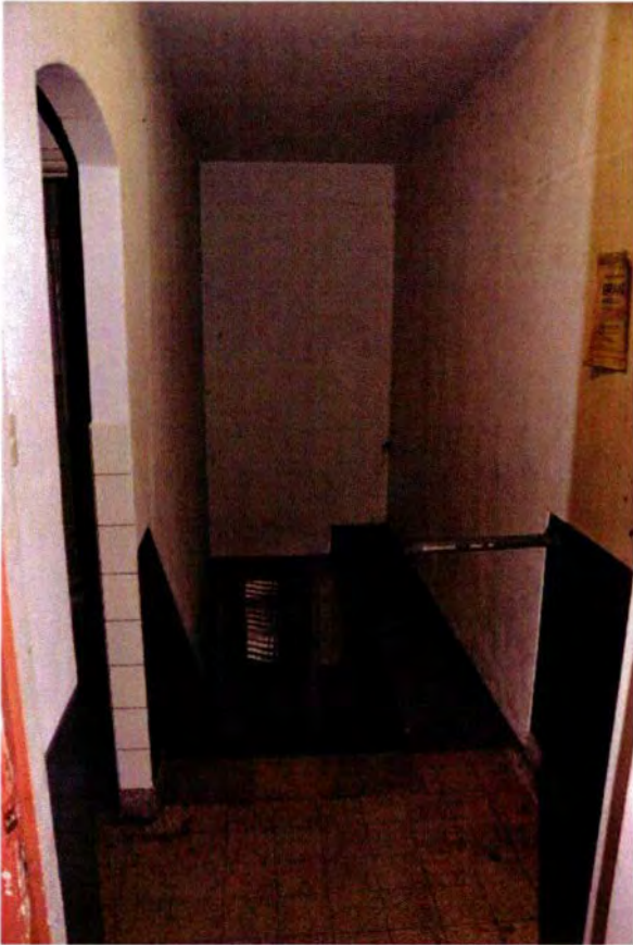
601. Ruimte 162, gezien naar het zuiden, vanuit de deuropening naar ruimte 161. Het geheel is bij een verbouwing in 1967 tot stand gekomen.
