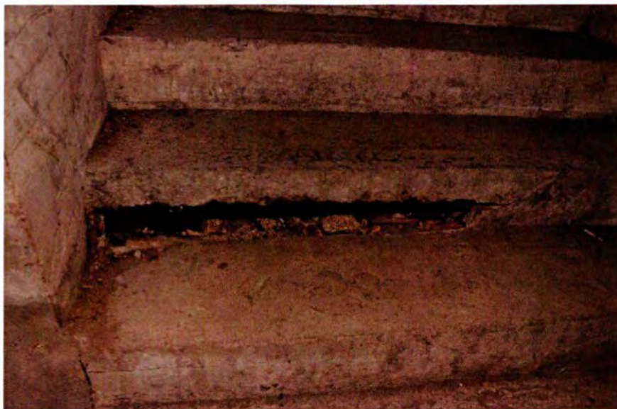
660. Ruimte 202. Detail van de betonnen trap naar het verhoogde deel van het vlakke bunkerdak. De treden van de trap zijn relatief dun uitgevoerd. Achter de treden is het halfvergane bekistinghout nog aanwezig.
