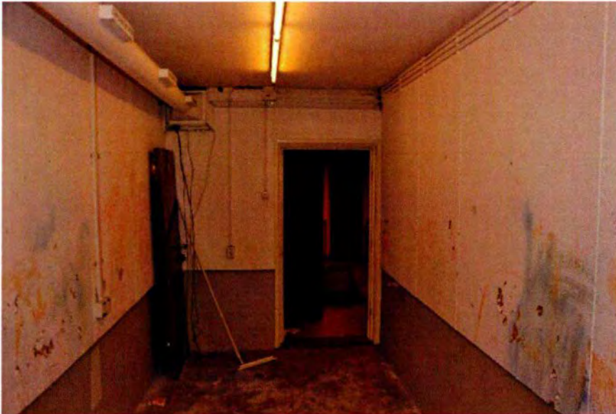
522. Ruimte 139A, gezien naar het westen. De deuropening en het kozijn behoren tot de oorspronkelijke opzet (1942). De deur zelf is waarschijnlijk na WOII (1948) geplaatst. Ook hier is de oorspronkelijke houten onderdorpel nog aanwezig. Linksboven is de luchtverversingsinstallatie zichtbaar. Mogelijk stamt dit deel van de installatie nog uit de bouwtijd van de bunker.
