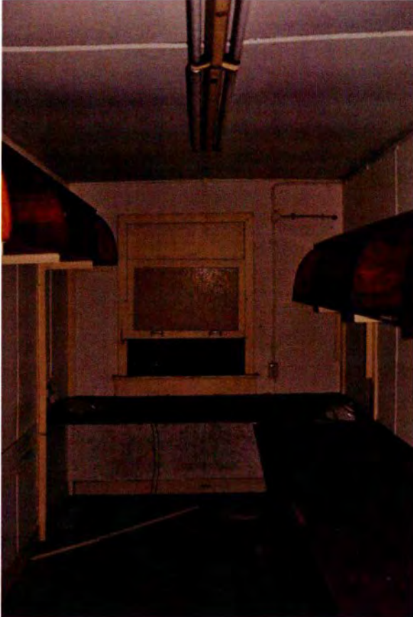
560. Ruimte 149, gezien naar het westen, met de werktafels en kasten van multiplex uit 1964. In de westwand is een schuifvenster opgenomen, dat diende als loket. Dit venster stamt uit de KO-periode (1948). De afwerking is vergelijkbaar met de overige vertrekken.
