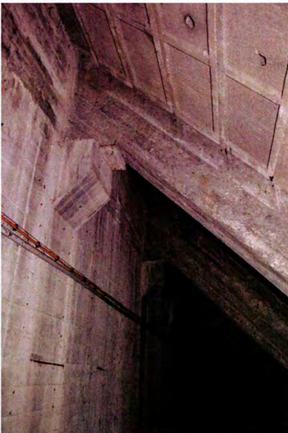
633. Ruimte 162D. De aansluiting van de betonnen spantbenen op de - tegen de bunker aangegoten - consoles. Hier is ook goed de in tweede instantie aangebrachte verhoging (1,5 m) van het vlakke bunkerdak zichtbaar.
