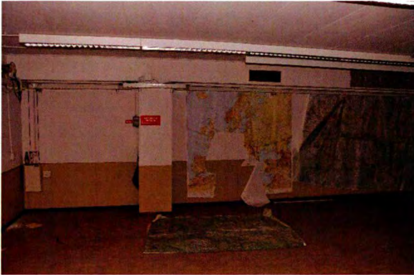
527. Het oostelijke deel van de zuidwand van ruimte 140. Langs de bovenzijde loopt het kanaal van de luchtverversingsinstallatie (1964). De voorsprong in het metselwerk is een verticaal onderdeel van de installatie. In deze ruimte bevinden zich rondom ook meerdere rijen rails voor landkaarten.
