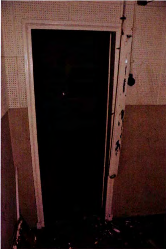
553. Ruimte 146. De oostwand met de toegang, waarvan het kozijn met de afwerklijst nog uit de bouwtijd dateert. De deur is na WOII (1948) gewijzigd in een schuifdeur (zie de volgende afbeelding).
