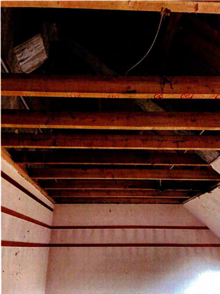
591. Ruimte 160, in noordelijke richting. Door verwijdering van de zoldering is daarachter ruimte 162D te zien. Hier ging de luchtkoker vanuit de garage (ruimte 094) door het plafond naar het dak. Links boven is de betonnen oostmuur van de bunker te zien.
