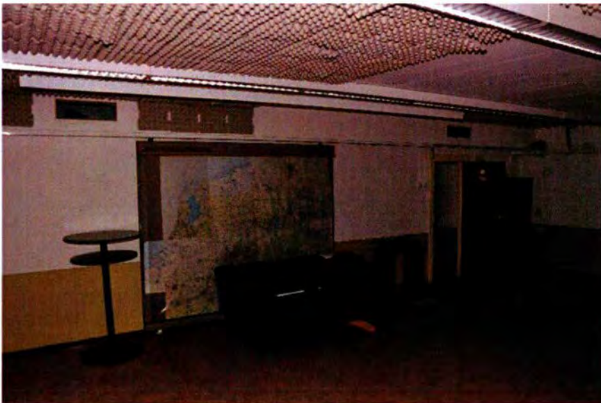
524. Ruimte 140. Het oostelijke deel van de noordwand met kaartenrails en luchttoevoerkanaal. Rechts de toegang tot het vertrek vanuit ruimte 156, dat oorspronkelijk diende als voorportaal tot het appartement in het zuidoostelijke deel van de verdieping.
