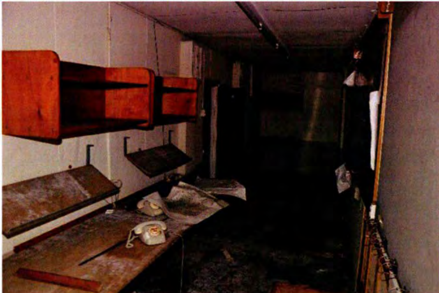
565. Ruimte 151, gezien naar het oosten. Het vaste meubilair is omstreeks 1964 geplaatst. Aan de haken rechts werden documenten opgehangen.
