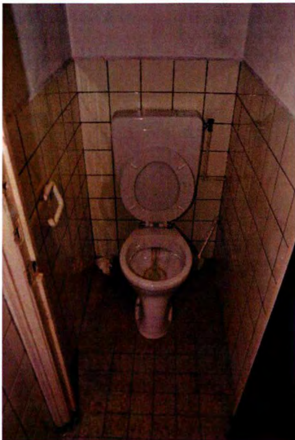
481. Het interieur van ruimte 127B is identiek aan dat van ruimte 127A. Het sanitair is in 1988 geplaatst.
