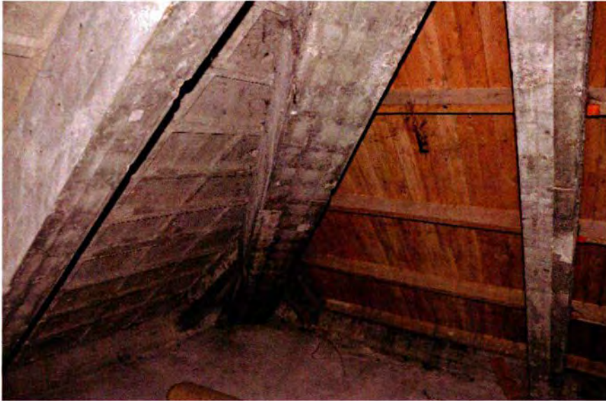
632. Ruimte 162D. De noordoosthoek met de aansluiting van het dak op de vloer. Links is het oorspronkelijke dakbeschoot bestaande uit bimsbetonplaten nog aanwezig, rechts van de hoekkeper de herstelling van direct na WOII (1948) met houten gordingen en houten dakbeschoot.
