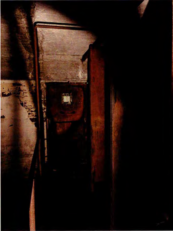
439. Ruimte 093B. De eerste verdieping van de schietgalerij, gezien in noordelijke richting. Zicht op de binnenkant van de nooduitgang. De roetresten zijn het resultaat van de brand begin 1991.
