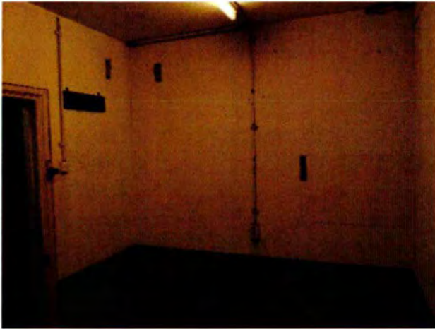
486. Ruimte 129, gezien in westelijke richting. Rechts een doorgeefluik naar ruimte 128, daterend uit de KO (1948).
