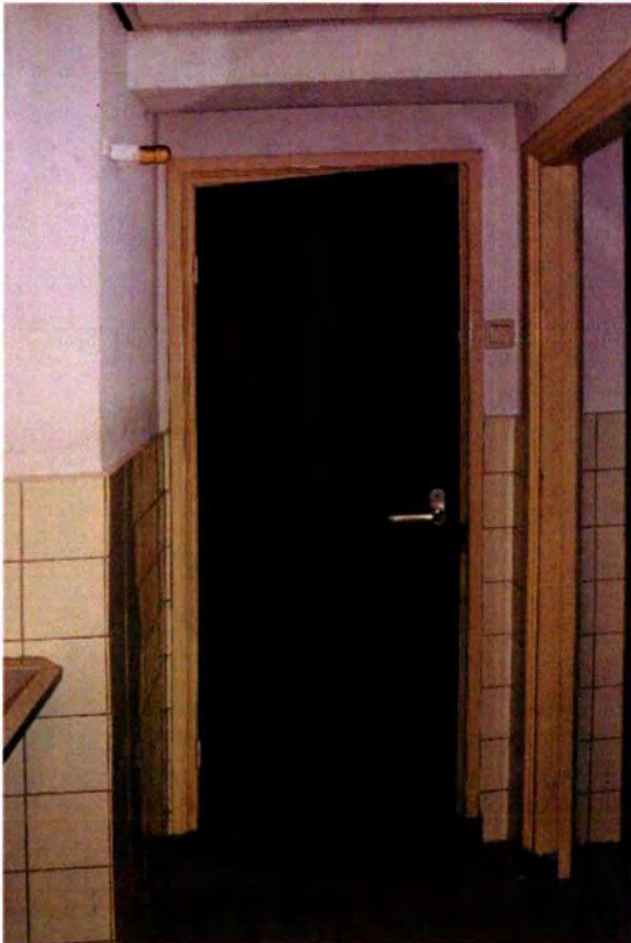
511. Ruimte 138. De westwand met de toegangsdeur. Het kozijn (evenals het kozijn rechts) dateert nog uit de bouwtijd. De deur is waarschijnlijk bij herstelwerkzaamheden in de KO (1988) geplaatst. Links op de foto is een leidingkoker zichtbaar.
