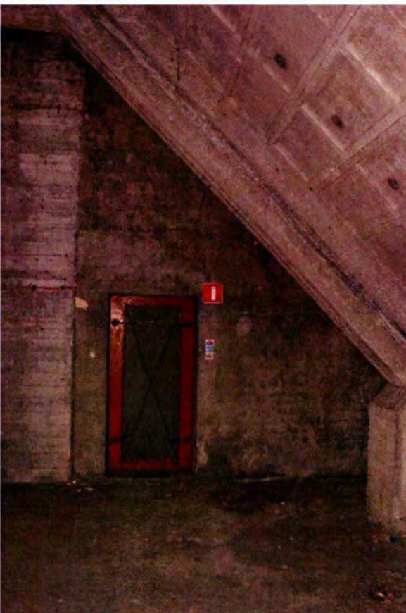
655. Ruimte 202. De gepleisterde bakstenen oostwand van het vertrek, met de gesloten gasdeur naar ruimte 201. De gasdeur dateert nog uit de bouwtijd van de bunker. Zie hiervoor ook de beschrijving van ruimte 201.
