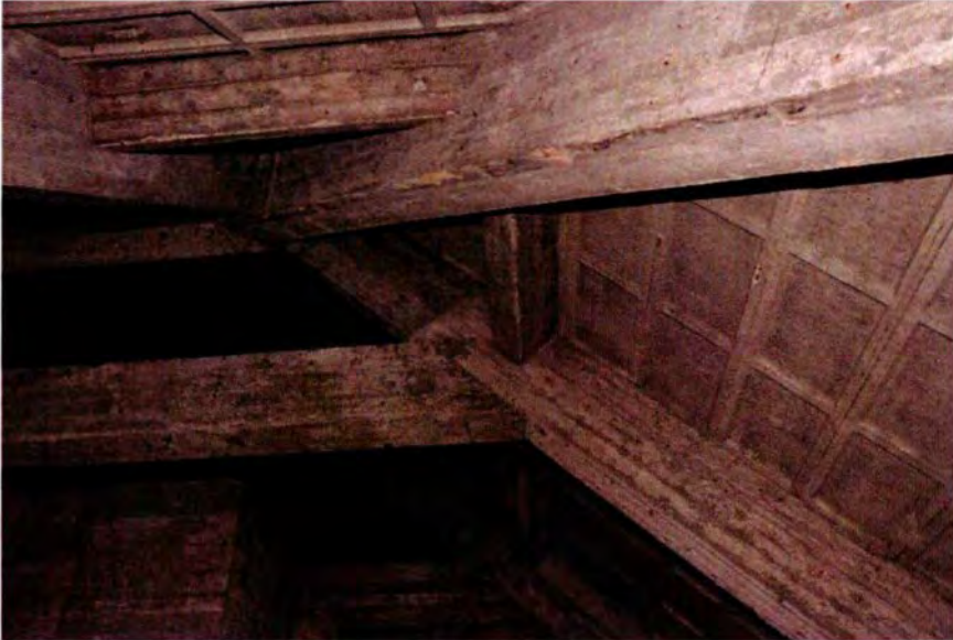
652. Zuidwesthoek van ruimte 202. Detail van de kapconstructie ter plaatse van de hoekkeper. Bij de spantbenen is vlak boven de onderste tussenbalken een stortnaad haaks op het spantbeen zichtbaar. In eerste instantie zal het spant dus tot en met de tussenbalk zijn gestort, en vervolgens is het bovenste deel bekist en gestort.
