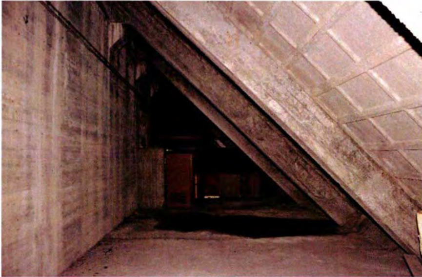
636. Ruimte 162D, gezien naar het westen. Links de betonnen kast met filterinstallatie (99B) uit 1964. Erachter is de achterkant van de kogelvanger van de voormalige schietbaan (ruimte 162C) uit circa 1976 zichtbaar.
