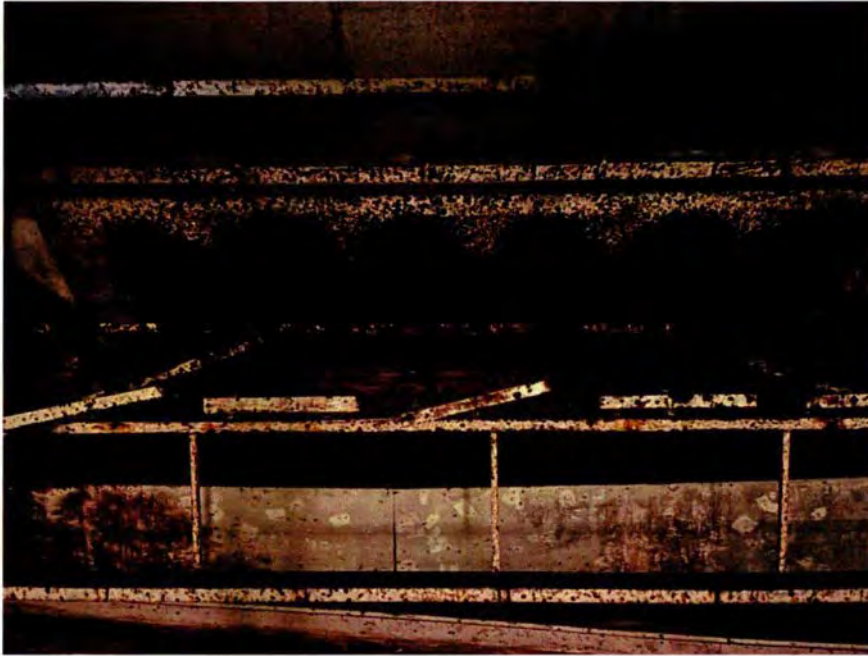
437. Ruimte 093B. Detail van de onderste kogelvanger. De kogels werden hier afgeketst naar een bak met zand. Men achtte het bij het strippen van de schietbaan na de brand niet noodzakelijk om de kogelvangers te demonteren en te verwijderen.
