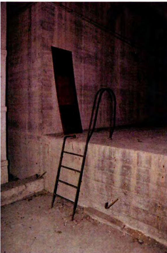
631. Ruimte 162D. Het verhoogde deel van de vloer ter plaatse van de noordelijke toegang, met de uit de bouwtijd daterende vast gemonteerde ijzeren ladder. Langs de bovenzijde van de bunkermuur is een leiding voor de verlichting zichtbaar. De kabels en lampen zijn na WOII (1948) vernieuwd.
