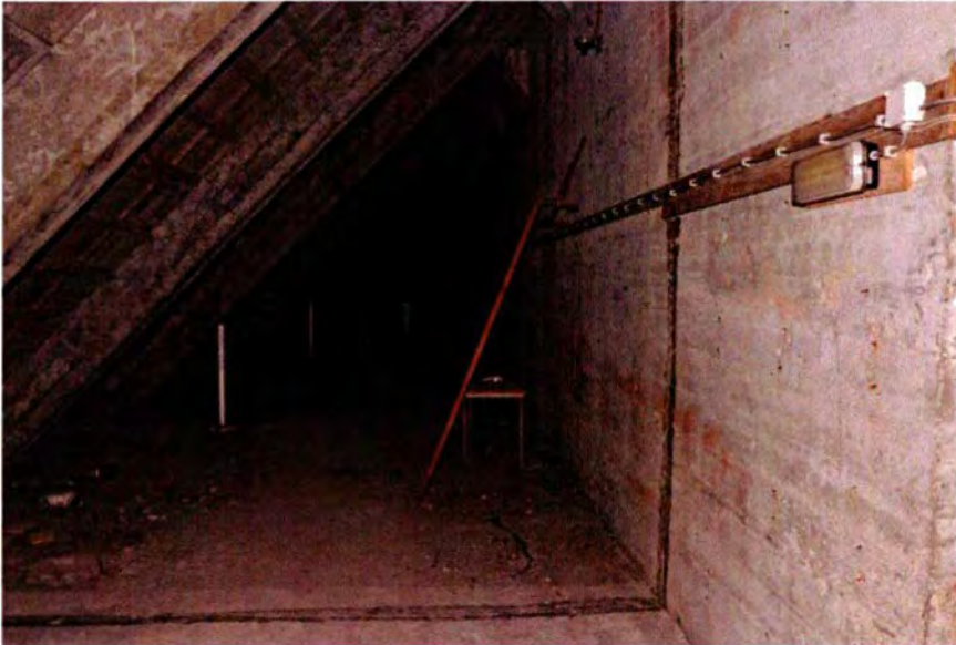
603. Ruimte 162B, gezien naar het westen. Uit de vloer steken ontluichtings- en afvoerpijpen, welke tijdens de KO zijn geplaatst om de munitieopslagruimten in de zuidelijke aanbouw te ventileren. Een aantal ervan is geheel of gedeeltelijk verwijderd. Tegen de noordwand (zuidmuur van de hoofdbunker) is een elektraleiding met meerdere lampen aangebracht. Deze horen waarschijnlijk bij de aanpassingen in 1948.
