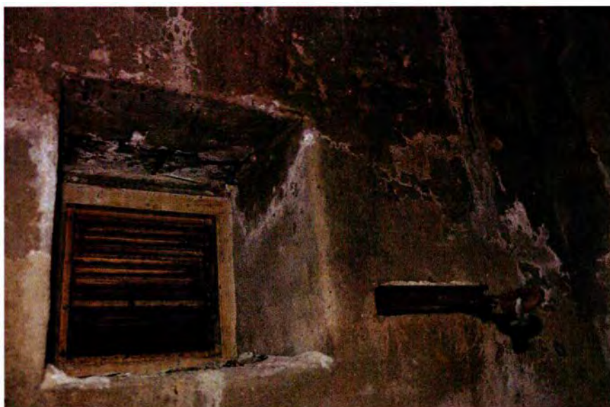
711. Detail van het ventilatierooster dat ruimte 87 van verse lucht moet voorzien. Dit rooster dateert uit de bouwtijd van de bunker. Ook andere in pandige vertrekken in de zolderruimte zijn van dergelijke ventilatieroosters voorzien.
