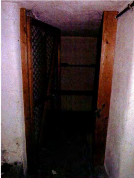
81. Ruimte 001C. De toegang tot de ruimte wordt afgesloten door een eenvoudige gasdeur met houten frame. Het is niet bekend of de deur nog uit de bouwtijd dateert.
