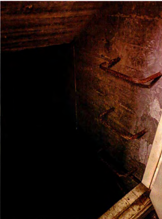
60. In ruimte 030 zit een deur met trap die toegang geeft tot de kelderruimte.
