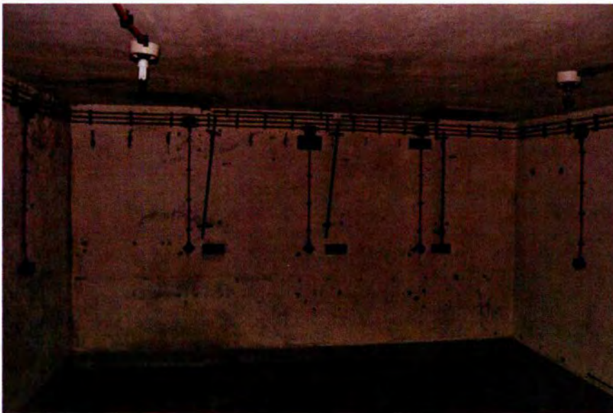
699. Ruimte 91. Overzicht van de oostwand. Net als bij de noord- en de zuidwand zijn ook hier drie stopcontacten op regelmatige afstand geplaatst (1948). In de zoldering - een van stucwerk voorziene betonvloer - zijn twee openingen zichtbaar, die toegang geven tot het grote ventilatiekanaal dat van de bovenliggende ruimte is afgescheiden.
