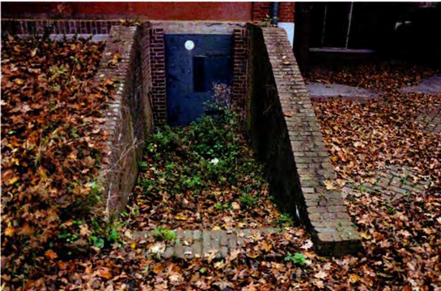
26. De oostelijke toegang tot de technische ruimten onder het grote bunkerdak. De beide keermuren zijn na WOII aangebracht. Oorspronkelijk sloot een loopgraaf aan op deze toegang en was het omringende maaiveld net zo hoog als links op de foto. De deur zal dateren van na WOII.
