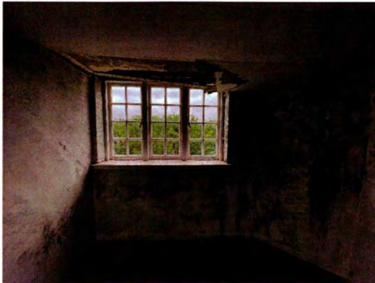
714. Ruimte 401. Overzicht van de zuidwand. Het venster is vervangen in 2019. Tijdens deze renovatiewerkzaamheden zijn ook de muren en de uitkijkpost erboven gerenoveerd, om het wind- en waterdicht te maken. Op de muur zijn nog veel vochtplekken aanwezig, ook het plafond is deels losgeraakt.
