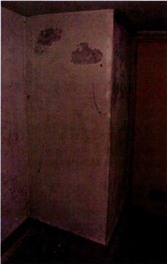
692. Zicht op de noordwesthoek van ruimte 87. Het inspringende metselwerk is het gevolg van de trap die vanaf ruimte 93 naar de bovengelegen etage voert.
