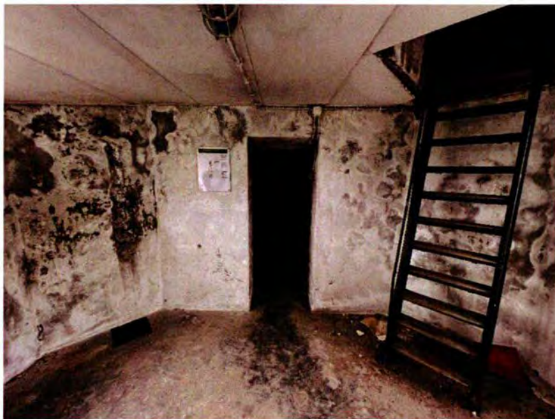
716. Ruimte 401. Zicht op de westwand met de toegang, de deur ontbreekt. Rechts ernaast de ijzeren ladder naar het observatieplatform. De ladder behoort nog tot de oorspronkelijke opzet.
