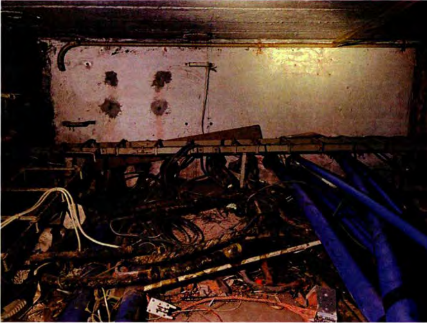
61. De kelderruimte ter hoogte van ruimte 030 in zuidelijke richting. Hier is zichtbaar hoe de verbindingkabels de hoofdbunker verlaten aan de zuidzijde. Deze doorgang is rond 1988/1989 aangelegd. Aan de andere kant van deze bunkermuur komen de kabels ruimte 095 van de voorbunker binnen. Boven de kabels hangt nog een oude kabelgoot daterend van de KO (1963).
