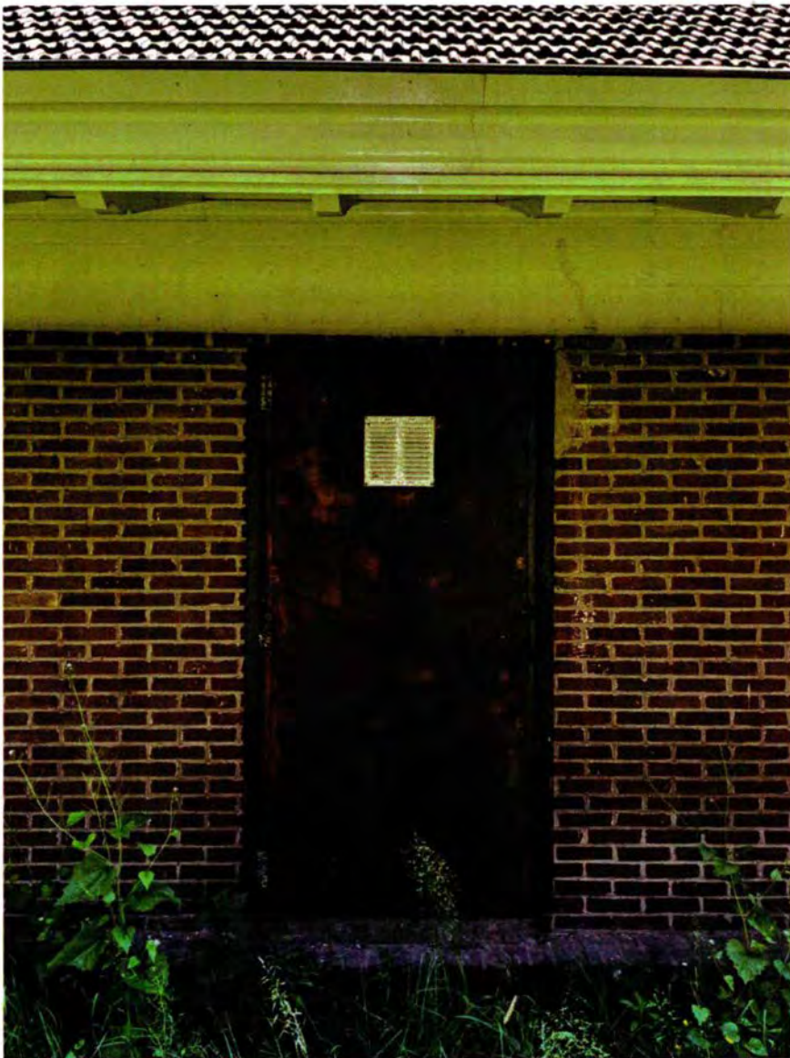
48. Deze deur in het metselwerk tussen de kolommen van de noordgevel was de nooduitgang van de achterliggende schietbaan, ruimte 093B. De deur ontsluit de bovenste galerij van de dubbele schietstand.
