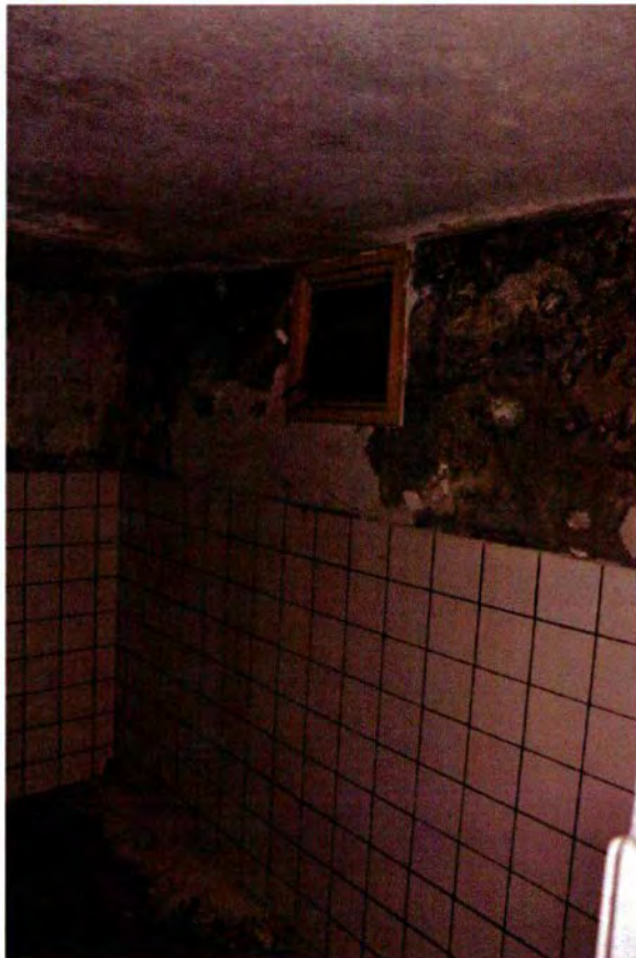
696. Ruimte 88. Overzicht van de zuidwand van het vertrek. De opzet van de wand is nog oorspronkelijk, inclusief het ventilatierooster.
