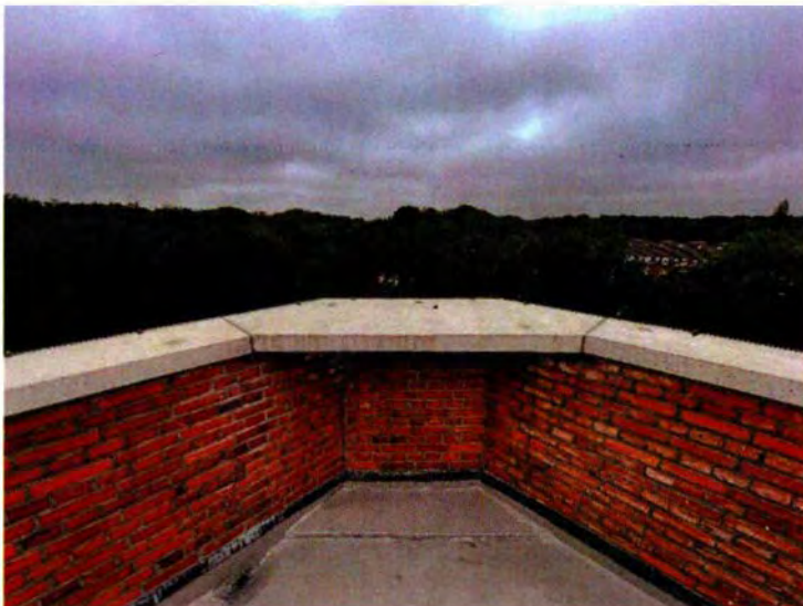
729. Zicht op het zuidoostelijke deel van de borstwering van de oostelijke observatietoren. Op de afgeschuinde hoeken van het achtkantige observatieplatform is de afdekplaat breder uitgevoerd en aan de onderzijde is hier een verhoging aangebracht.
