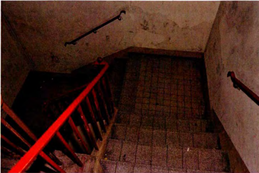
111. Ruimte 005. De trap van bovenaf. De leuningen dateren nog uit de bouwtijd. De tegels op de bordessen en op de traptreden zijn in de KO-periode (vermoedelijk tijdens de aanpassingen van 1948) aangebracht.
