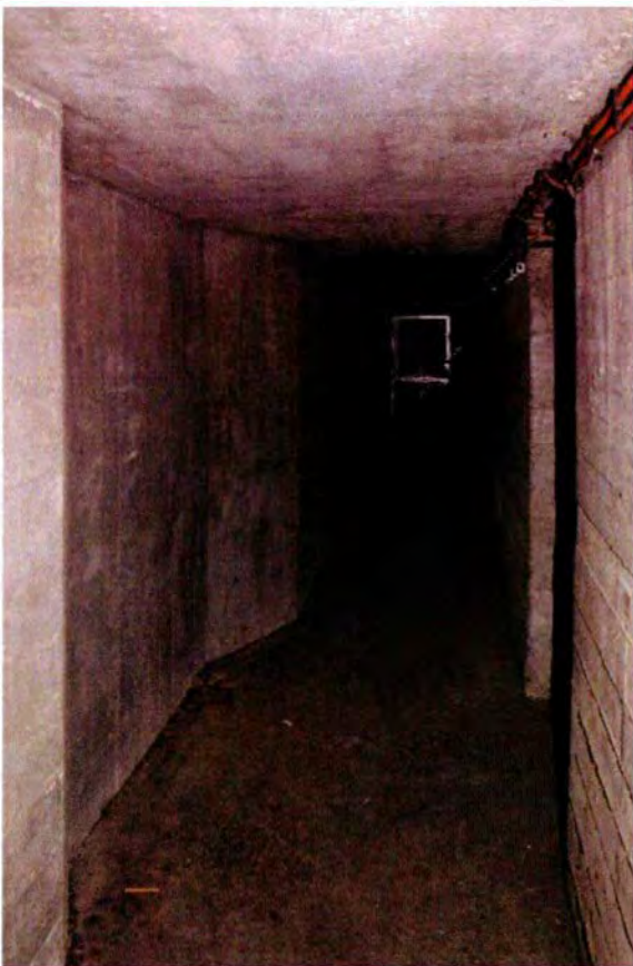
684. Ruimte 204. Zicht in noordelijke richting in de dwarsgang ten westen van de luchtsluis. Links is de verbreding van de gang zichtbaar, die het mogelijk moet maken om met grotere objecten vanuit de luchtsluis de zolder te kunnen bereiken.
