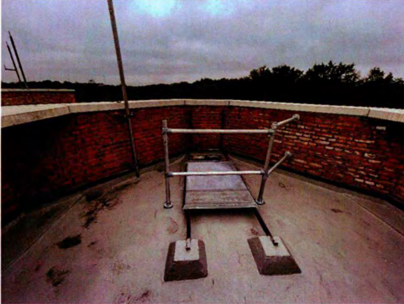
726. Oostelijke observatietoren, richting het noordwesten, met schuifluik om observatietoren af te sluiten. De reling is in 2020 aangebracht t.b.v. de publieksopenstelling. De twee aan de borstwering bevestigde beugels zullen nog wel uit de bouwtijd dateren. De grond is voorzien van een nieuwe laag. De bakstenen rand is tijdens de werkzaamheden van 2019 ook vernieuwd. Het hemelwater wordt door vier gaten (aan zowel oost- als westzijde 2 gaten) in de bodem weggevoerd.
