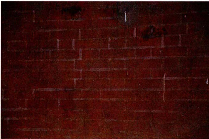
18. Detail van het pleisterwerk, waarop het schijnmetselwerk is aangebracht.
