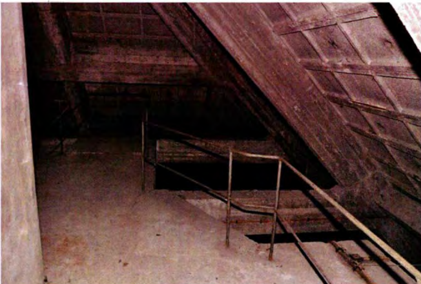
705. Ruimte 93. Het platform in westelijke richting met de ijzeren leuning en één van de twee toegangstrappen. Het platform dient ter ontsluiting van de hogere etages, zoals deze in en naast de observatietorens zijn ondergebracht. De gehele hier zichtbare opzet dateert nog uit de bouwtijd.
