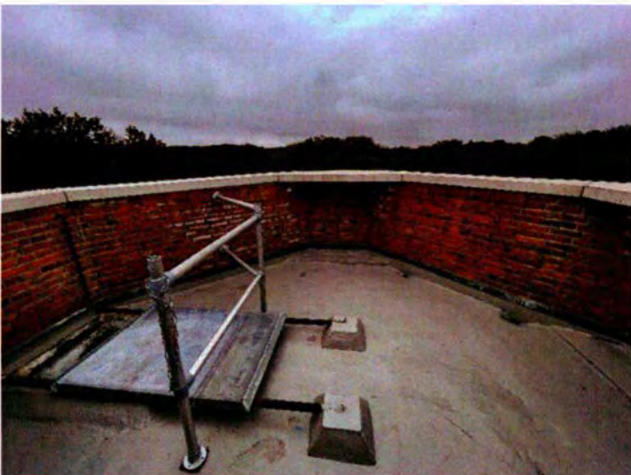
727. Oostelijke observatietoren, richting het noordoosten.
