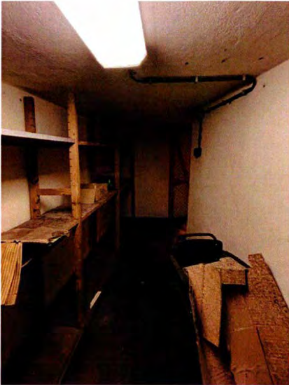
80. Ruimte 001B. Het oostelijke deel van de ruimte met rechts de houten gaasdeur, die de toegang vormt.
