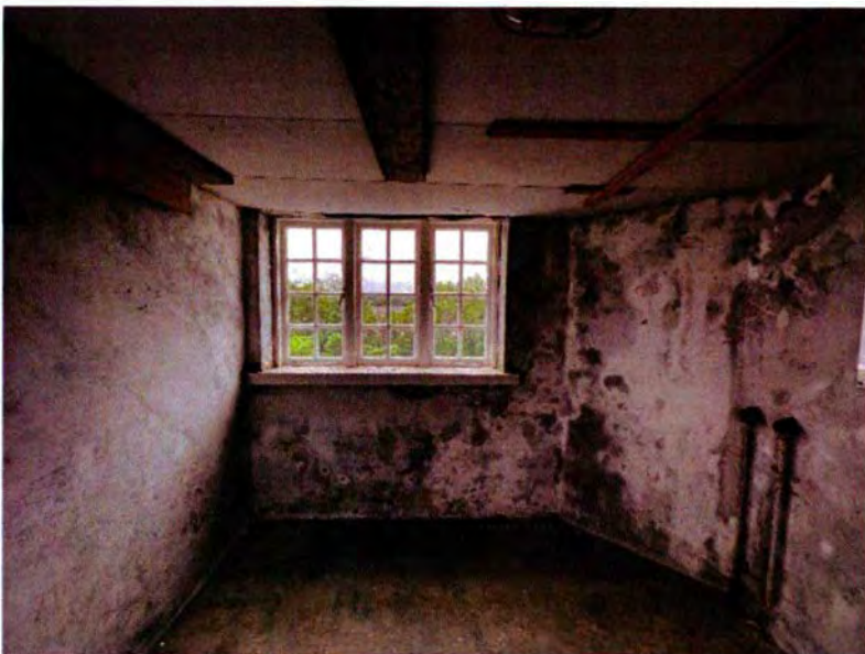
723. Ruimte 402. Overzicht van de zuidwand. Het in de wand opgenomen venster is in 2019 geheel vervangen. Het kozijn is met al zijn details terug te vinden op de opmetingstekeningen die kort na de WOII zijn vervaardigd en thans in het Nationaal Archief berusten.
