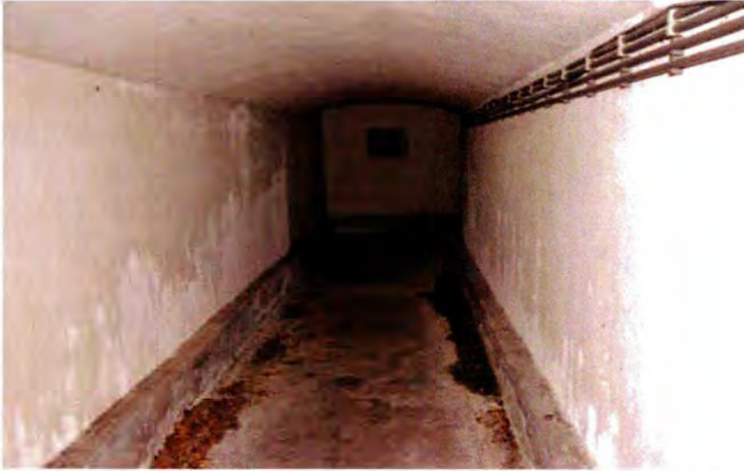
68. Ruimte 001. Overzicht van de hoofdtoegang in noordelijk richting. Aan het eind van de gang zit het schietgat dat de ingang verdedigt.
