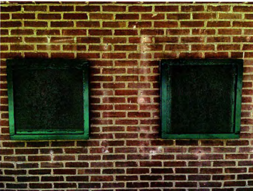
47. Detail van de ventilatieroosters aan de noordzijde van de bunker, welke de achterliggende schietbaan ventileren.
