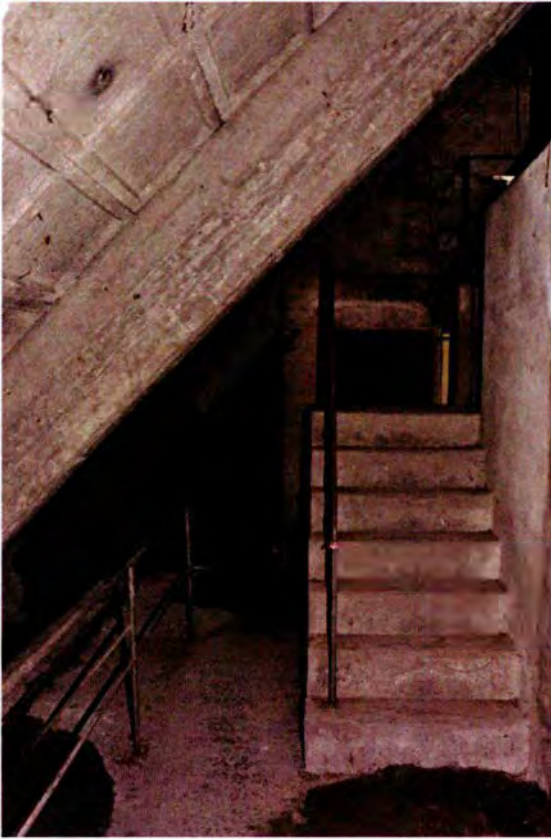
704. Ruimte 93. Overzicht van het noordelijke deel van het platform bij de westelijke observatietoren. De hier zichtbare betonnen trap dient ter ontsluiting van de bovenste etages van deze observatietoren. Die toren bevindt zich aan de rechterzijde van de foto.
