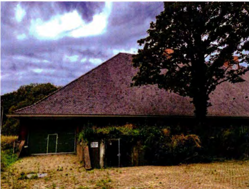
12. Het meest westelijke deel van de zuidgevel. Rechts van het midden is de westelijke toegang aan de zuidzijde te zien, die thans door een modern hekwerk wordt afgesloten. Oorspronkelijk sloot de ingang aan op de rond de bunker aangelegde loopgraaf. Het metselwerk links van de toegang is na WOII tot stand gekomen. De groene deur van de zijruimte (093) zal in het laatste kwart van de 20ste eeuw zijn geplaatst. Bij de bouw van de bunker was deze zijruimte niet afgesloten en minder hoog. Het maaiveld aan deze zijde zal even hoog zijn geweest als thans nog aan de westzijde het geval is. Wel was hier tijdens WOII een weg, die naar de zijruimte voerde. Deze toegangsweg zal de reden zijn geweest waarom de loopgraaf hier ter plekke overdekt was uitgevoerd. Dit deel van de overdekte loopgraaf is na WOII gesloopt om het niveau van de toegangsweg te kunnen verlagen.
