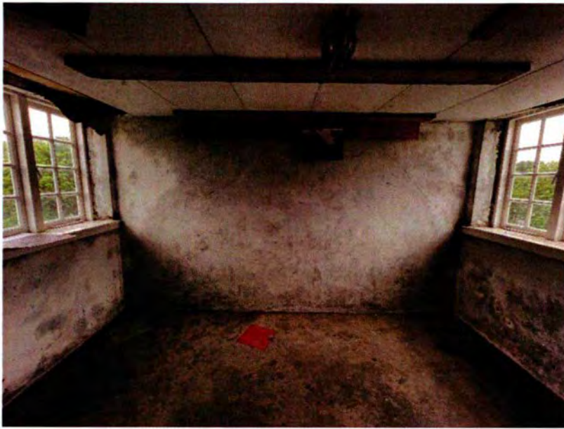
722. Ruimte 402. Overzicht van de oostwand. De wand scheidt een deel van de achthoekige ruimte af. Het deel achter deze wand is onderdeel van het luchtbehandelingssysteem.
