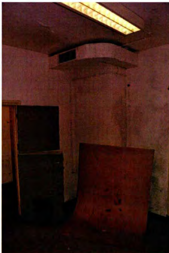
118. Ruimte 007 naar het zuidoosten. Links de deur naar gangruimte 005. De deur is doormidden gezaagd, waardoor de opbouw van de deur is te zien. Zie hiervoor de volgende afbeelding. De wanden en het plafond van het vertrek zijn wit gesausd. Op de vloer ligt linoleum. Bovenaan is een luchtkanaal met rooster zichtbaar, vermoedelijk uit 1964. Het kanaal voedt ook het rooster in ruimte 006.
