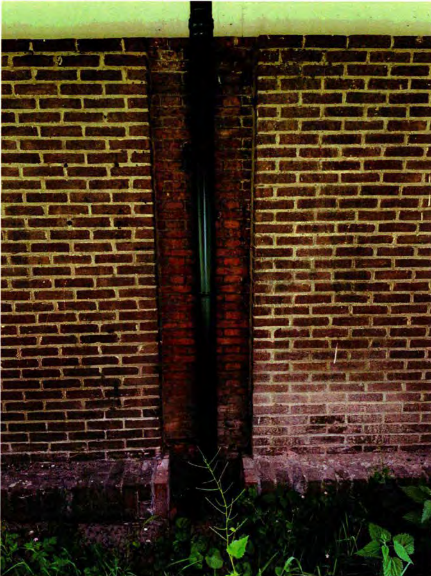
49. Detail van de regenpijp aan de noordzijde van de bunker. Op deze afbeelding is goed het verschil zichtbaar tussen de pilaren, daterend van de bouwperiode, en de bakstenen muur daterend van de werkzaamheden omstreeks 1969 om de galerij aan de noord- en westzijde dicht te maken.
