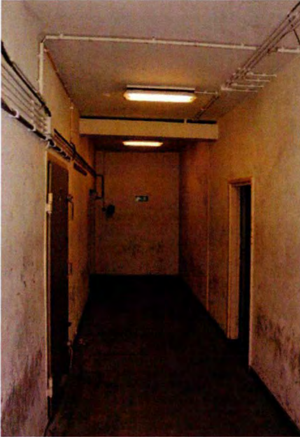
107. Ruimte 005 in zuidelijke richting. Links aan het einde van de gang bevindt zich de toegang naar de gassluis. Het bijbehorende overdrukventiel is zichtbaar. Onder het plafond is een luchtverversingskanaal uit de KO (1964) te zien.
