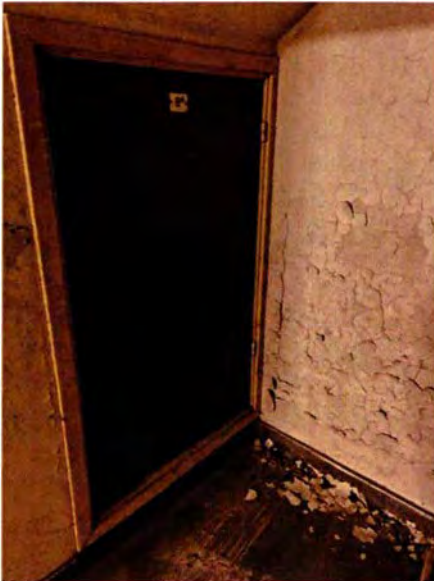
53. In ruimte 008 is de kelderruimte toegankelijk via een deur en klimtrap. In deze deur is een ventilatierooster opgenomen ten behoeve van de afvoer van vieze lucht uit dit deel van de bunker, vanuit gang 013.
