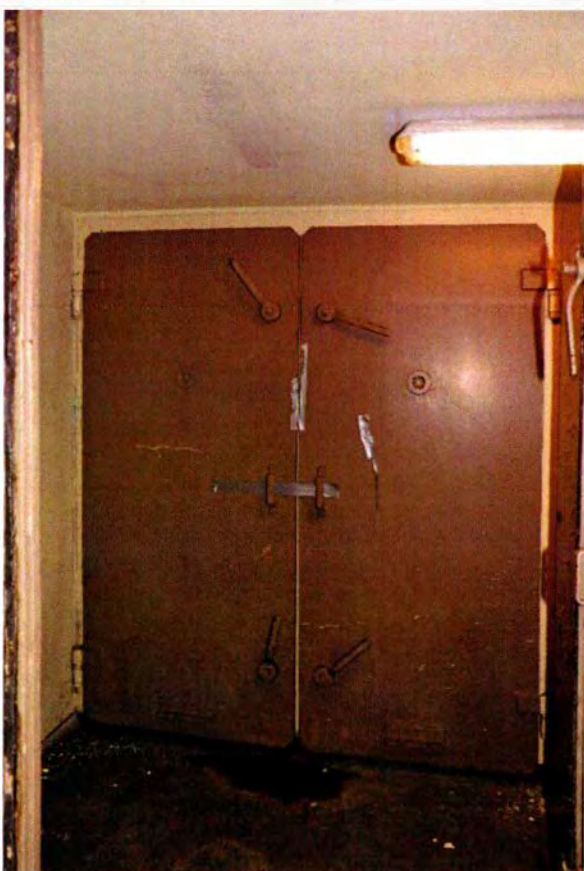
96. Ruimte 002. Het noordelijke deel van de oostwand met de dubbele stalen gasdeur (naar 004) die nog wel een tussenstijl heeft (zie ruimte 004).
