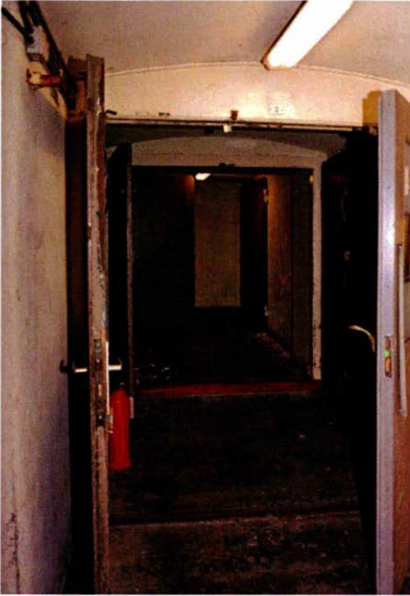
86. Ruimte 002. De gassluis met geopende deuren, kijkend in noordelijke richting. Op de voorgrond de deuren van de KO-periode, vervolgens de uit de bouwtijd daterende gasdeuren aan de buitenzijde van de gassluis en op de achtergrond rechts de gesloten gasdeuren naar ruimte 004, de sluis die in de KO (1964) is aangelegd. Links een van de geopende gasdeuren naar ruimte 005.
