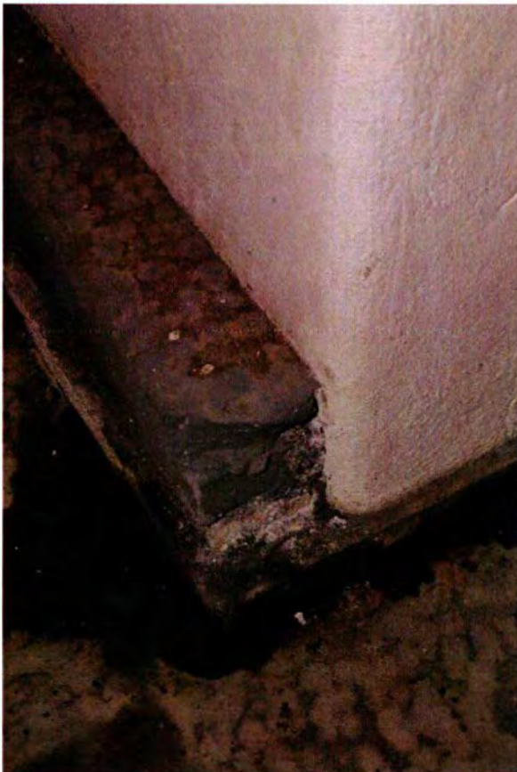
77. Ruimte 001B. Detail van de opstaande rand van de gang ter plaatse van de toegang naar ruimte 001B. De opstaande rand bestaat grotendeels uit gepleisterd en grijs geschilderd metselwerk. Deze opstaande rand is niet aanwezig op de opmetingstekeningen van na WOII.
