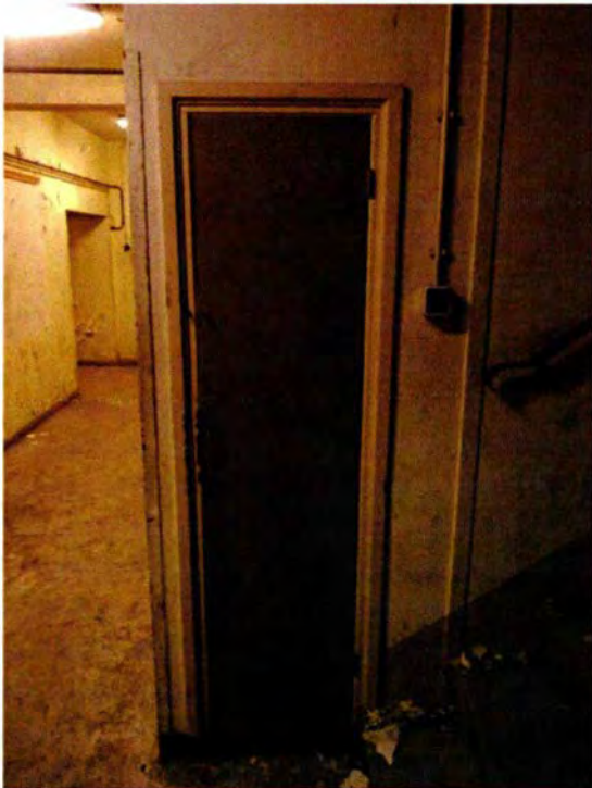
114. Ruimte 005A. Deur in gesloten toestand, met een rooster voor ventilatie.
