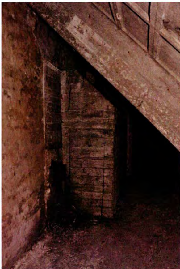
710. Ruimte 93. Overzicht van de zuidwand van de westelijke observatietoren en de daartegen aangebouwde rookkanalen (links), gezien in oostelijke richting. Links is een afvoer voor vuile lucht zichtbaar, behorende tot de oorspronkelijke opzet. Hier is ook duidelijk de overgang zichtbaar van het in gewapend beton uitgevoerde deel en het deel dat in baksteen is opgetrokken en gepleisterd is.
