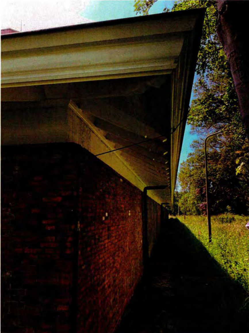
41. Detail van het dakoverstek. De detaillering van de uiteinden van de sporen komt overeen met de ontwerptekeningen. Het dakoverstek is hersteld bij de herstelwerkzaamheden van 2019.
