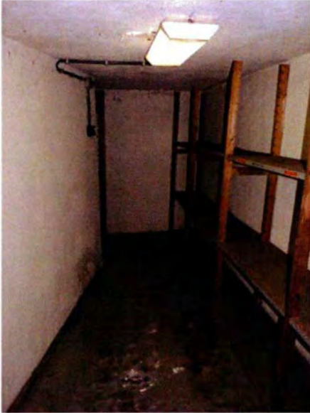
84. Ruimte 001C, Zicht op westzijde van het vertrek, gezien richting de uitgang. Links de houten gasdeur.
