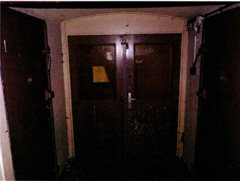
87. Ruimte 002A. De entree van de bunker met gesloten houten deuren, gezien vanaf de noordzijde. Deze deuren zijn gedurende de KO geplaatst (1948).
