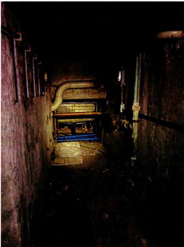
56. De kelderruimte van ruimte 020A in noordelijke richting. Achter de buis en kabels is de kelderruimte toegankelijk. De volgende drie afbeeldingen zijn gemaakt op deze plek.
