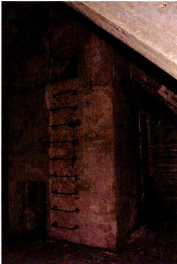
706. Ruimte 93. Overzicht van de westzijde van de westelijke observatietoren en de daartegen gebouwde rookkanalen. Beide openingen geven toegang tot de veegluiken van de rookkanalen. Bij de linker opening staat boven de opening Muni geschilderd. Dit zou kunnen betekenen dat de ruimte tijdens WOII voor de opslag van munitie bestemd is geweest.
