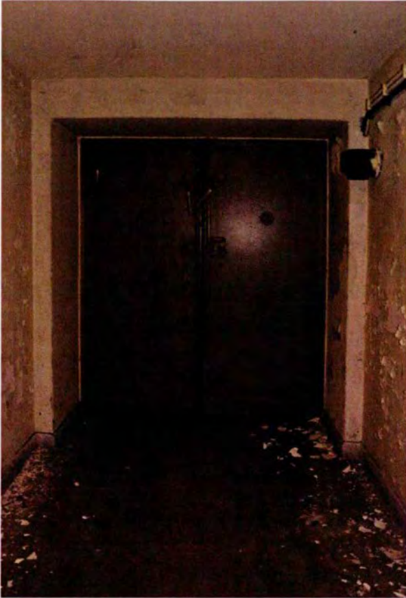
90. Ruimte 002. De buitenste deuren van de gassluis in gesloten toestand, gezien naar het zuiden. Tussen de deuren was oorspronkelijk een stijl geplaatst, waardoor de deuren gasdicht waren. Deze stijl ligt in een andere ruimte in de bunker.
