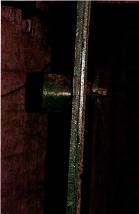
683. Ruimte 204. Detail van de vorige afbeelding, waarop de ijzeren dop aan de buitenzijde en de handel aan de binnenzijde van de deur goed zichtbaar zijn. Tevens is hier goed de dikte van de deur zichtbaar.
