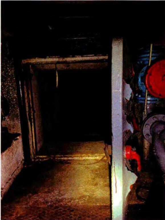
55. In ruimte 020 is de kelderruimte toegankelijk via een gasdeur van het luchtuitlaatkanaal.
