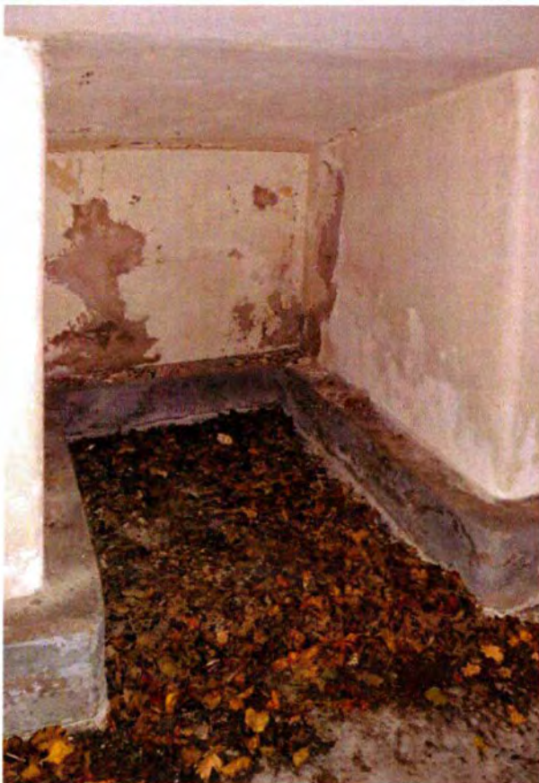
67. Ruimte 001. De nis die het restant vormt van de overwelfde loopgraaf. Het resterende deel van de loopgraaf is na WOII verwijderd. Toen is de nis aan de achterzijde dichtgezet. Dit alles zal verband houden met het verlagen van het maaiveld voor de toegang tot de garage in de zijvleugel van de bunker.
