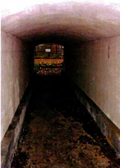
72. Ruimte 001. De oostelijke toegang, gezien naar het zuiden.
