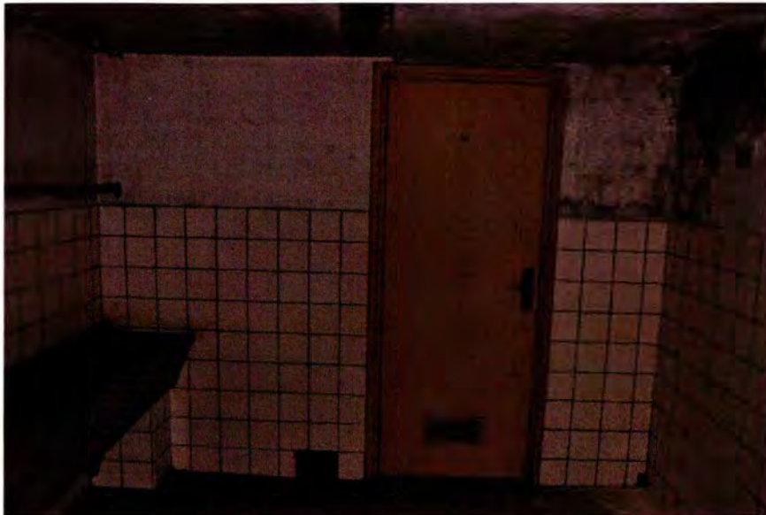
694. De oostwand van het vertrek. Achter deze wand bevinden zich een wc en een urinoir. De opzet van de wand is nog oorspronkelijk, al is het hier ook niet zeker of de deur nog uit de bouwtijd dateert. Links naast de deur is onder de muur een schroputje zichtbaar, dat zowel dient voor deze ruimte als voor de toiletruimte.
