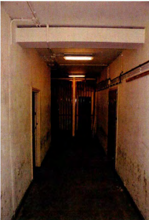
108. Ruimte 005 in noordelijke richting. Rechts zit de deur naar ruimte 004A, die deel uitmaakt van de ontsmettingsruimten. Aan het eind van de gang is na de WOII een bruin hek geplaatst. Deze is later vervangen door een wit hek, welke later weer rood is geschilderd. Dit hek fungeerde als de toegang tot het verbindingscentrum vbdcen GV dat vanaf 1948 tot december 1983 op de begane grond van de bunker was gevestigd.
