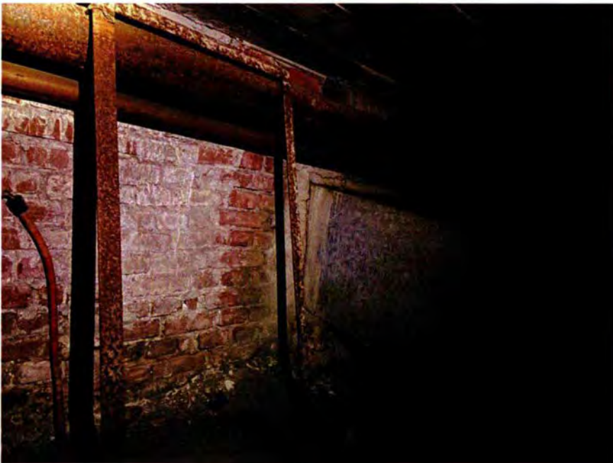
58. De kelderruimte ter hoogte van ruimte 020A, gezien om de hoek richting de zuidzijde van de bunker. Hier gaat het hiervoor getoonde kanaal voor de luchtuitlaat richting ruimte 020A.
