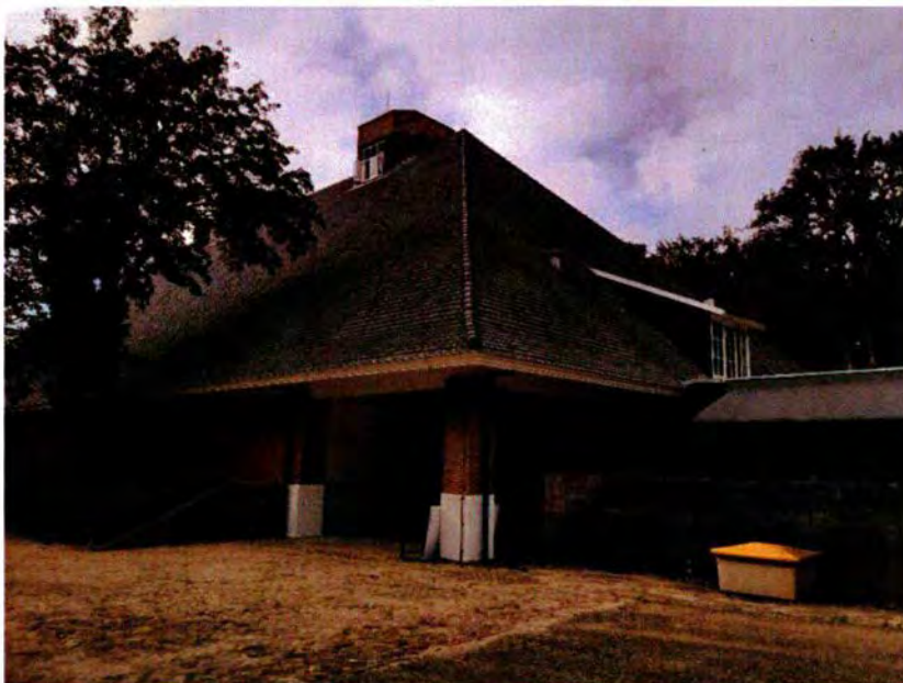
20. Het meest oostelijke deel van de gevel. Links de gepleisterde en van schijnvoegen voorziene zuidgevel van de bunker. De oostelijke toegang tot deze ruimten is thans voorzien van gemetselde flankeringmuren. Deze zijn na WOII tot stand gekomen. Oorspronkelijk sloot een open loopgraaf aan op de toegang. Die loopgraaf is zichtbaar op de ontwerptekeningen en op luchtfoto's uit WOII. De loopgraaf is verloren gegaan op het moment dat hier het maaiveld verlaagd werd. Het oorspronkelijke maaiveld is links van de toegang nog aanwezig.
