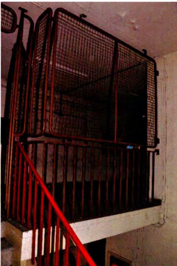
112. Ruimte 005. De bovenzijde van de trap is met een hekwerk afgesloten. Dit hekwerk is tijdens de KO geplaatst op de oorspronkelijke trapleuning, vermoedelijk tijdens de aanpassingen van 1948 of 1964. Het hekwerk sloot de toegang af tot de tweede verdieping waar gedurende de KO de Oorlogsstaf BLS was gevestigd.
