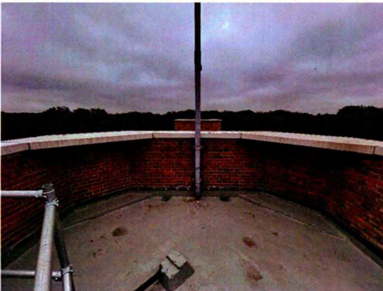
733. Het oostelijke deel van de westelijke observatietoren, met in het midden een stalen mast waar de bliksemafleider langs loopt. De nissen in de hoeken zijn in opzet identiek aan de constructie van de oostelijke toren. Ook hier aan de oost- en westzijde weer vier afwateringsgaten in de bodem.
