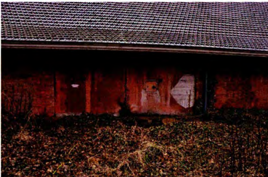
16. Het middelste deel van de zuidgevel. Het meest linkse deel bevindt zich boven de ingangspartij en is in baksteen (Vlaams verband) opgetrokken. Het deel rechts van de verticale naad is in gewapend beton uitgevoerd. Het beton is gepleisterd en beschilderd in een baksteenpatroon (Vlaams verband). Achter de regenpijp is de in baksteen uitgevoerde bekleding (Vlaams verband) van een van de kolommen zichtbaar. Het direct daarop aansluitende gepleisterde beton is voorzien van een in halfsteens verband uitgevoerde imitatiebaksteen. De donkere grens geheel rechts geeft de overgang naar Vlaams verband aan. Vermoedelijk heeft men in het verleden het tussenliggende deel moeten herstellen en gemakshalve het pleisterwerk van imitatiemetselwerk in halfsteens verband uitgevoerd. De in de gevel opgenomen gaten dienen voor het vullen van de olietanks in de ondergelegen ruimte 097.
