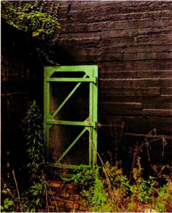
365. Ruimte 114. Dezelfde deur, maar nu vanaf de buitenzijde gezien.
