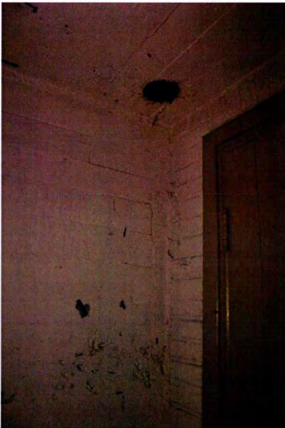
400. Detail van de noordwesthoek van ruimte 006A. Zichtbaar is dat het beton van de westwand tegen het metselwerk van de noordwand is gestort (in de naastgelegen ruimte 007A loopt deze muur nog meer dan een meter verder naar het westen). Te zien is ook dat enkele kleine delen bekistingshout in de hoek met het metselwerk als opvulling zijn gebruikt. De betonwand is dus jonger dan het metselwerk. In het plafond is één van de ventilatiegaten zichtbaar, waarvan in de bovenliggende ruimte nog de pijpen te zien zijn. Bijna alle vertrekken hebben in opzet een dergelijke voorziening.
