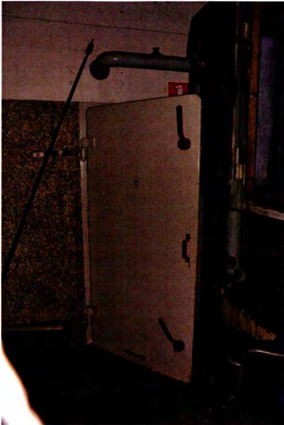
176. Ruimte 020. Detail van de gasdichte deur tussen de ruimten 018 en 020.
