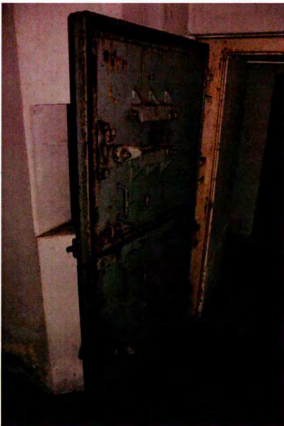
366. Ruimte 114. De in de westwand opgenomen toegang naar de lucht- of gassluis. Net als bij de noordelijke toegang tot de keukenbunker is deze voorzien van een tweeledige pantserdeur van het type 434P01, daterend uit WOII.
