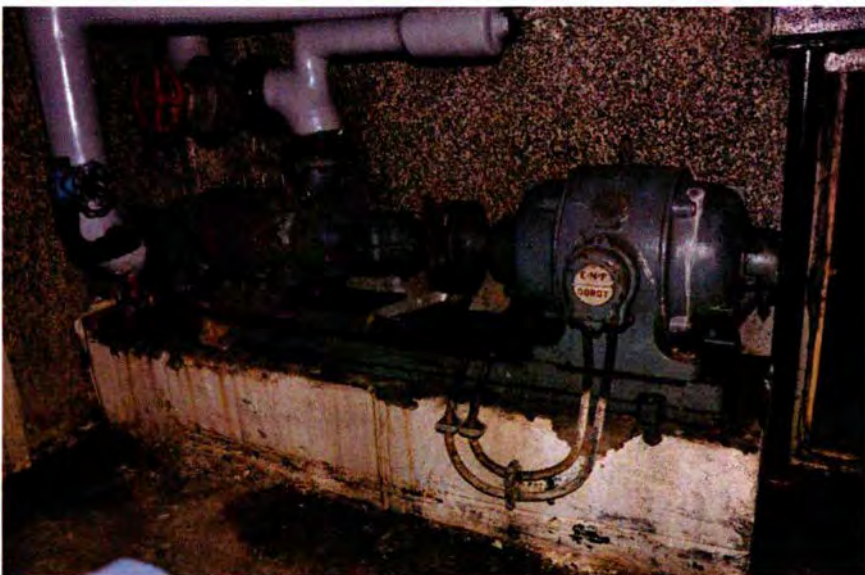
177. Ruimte 020. Ten noorden van de hiervoor getoonde deur staat deze motor opgesteld. Dit is een bronpomp van het merk E.M.F. Dordt. Het jaartal is niet bekend, maar deze motor dateert vermoedelijk van de aanpassingen in 1957.
