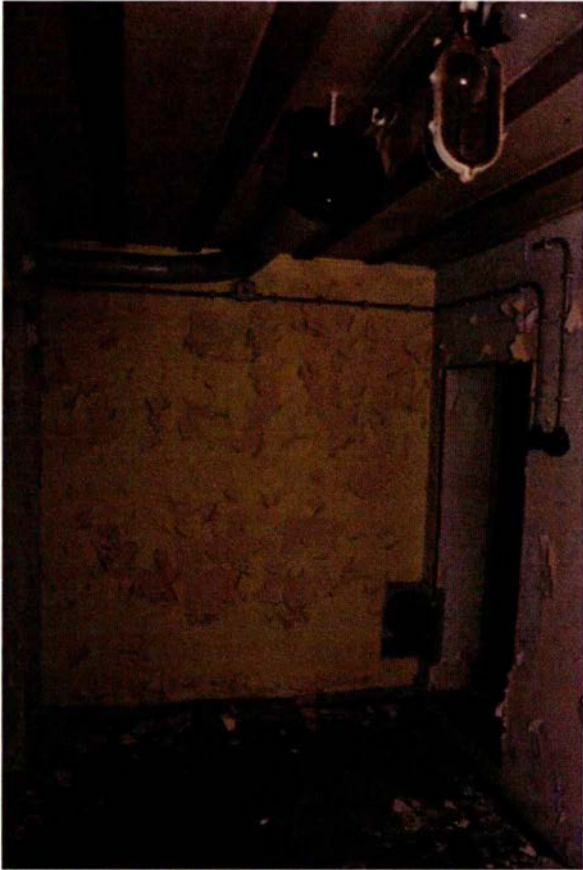
317. Ruimte 105. De zuidwand met rechts de gasdeur naar ruimte 104. Rechtsonder is een van de naoorlogse overdrukventielen zichtbaar.
