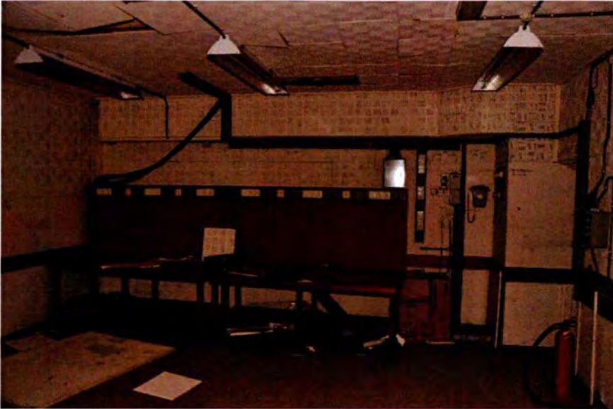
208. Ruimte 022. De westwand met het langs de bovenzijde aangebrachte kanaal van de luchtbehandeling (1964). Voor de wand staan twee houten werktafels met elektravoorzieningen uit de tijd dat het verbindingscentrum vbdcen GV deze ruimte gebruikte.
