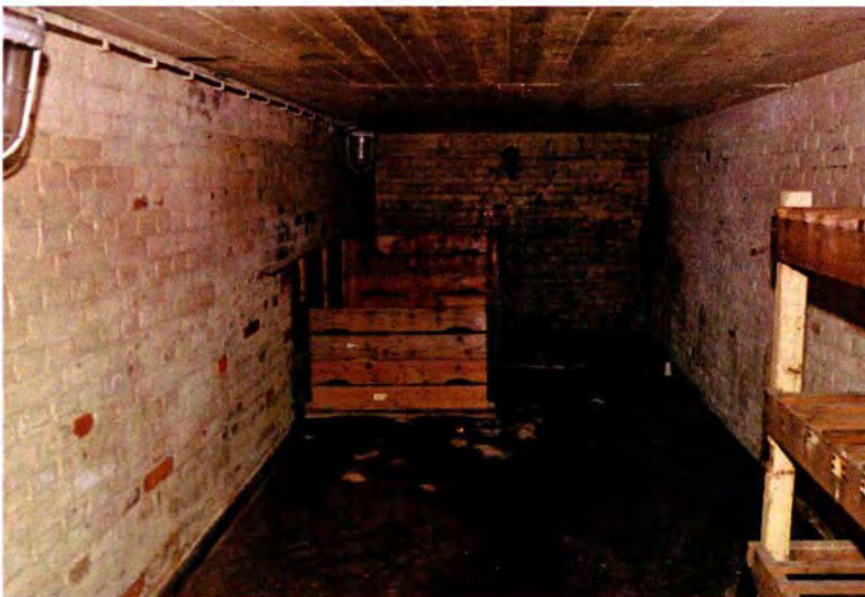
370. Ruimte 115 in westelijke richting. De kratten en de stellingkast getuigen van het gebruik als opslagruimte en dat is waarschijnlijk ook het oorspronkelijke gebruik van het gebouw.
