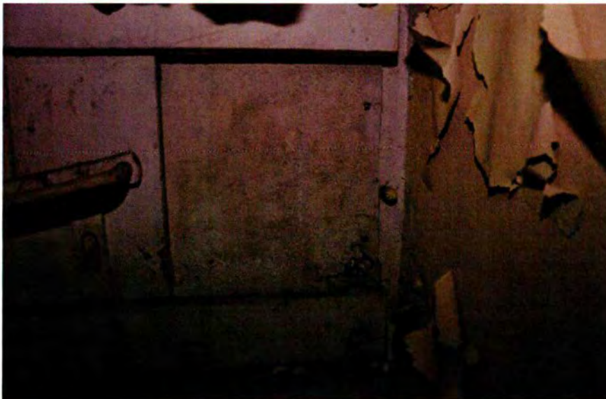
320. Ruimte 105. Detail van het schietgat. Links de stalen schuif die het schietgat afsluit. Rechts ervan is een 5 mm dikke rubberen mat te zien, die tussen de schuif en de plaat is geplaatst. Ter plaatse van het schietgat is een opening in de mat uitgespaard. De mat dient voor de gasdichting van het schietgat.
