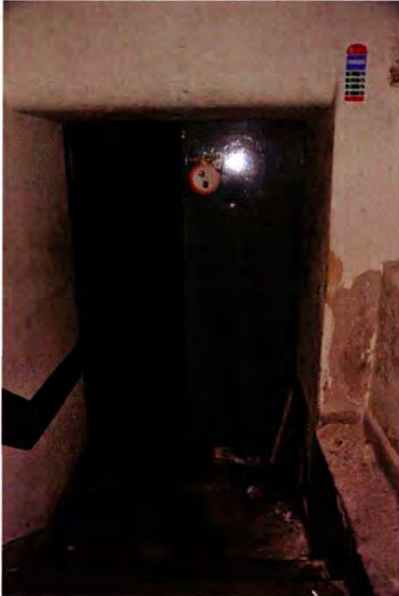
184. Ruimte 020A, gezien vanuit de entree in zuidelijke richting met zicht op de deur van de machinekamer. De deur zal in de KO-periode (1948) zijn geplaatst.
