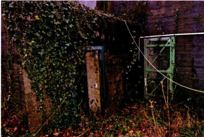
368. De oostgevel van de bergplaats (links) ten zuiden van de keukenbunker. Rechts is de zuidelijke toegang tot de keukenbunker te zien.
