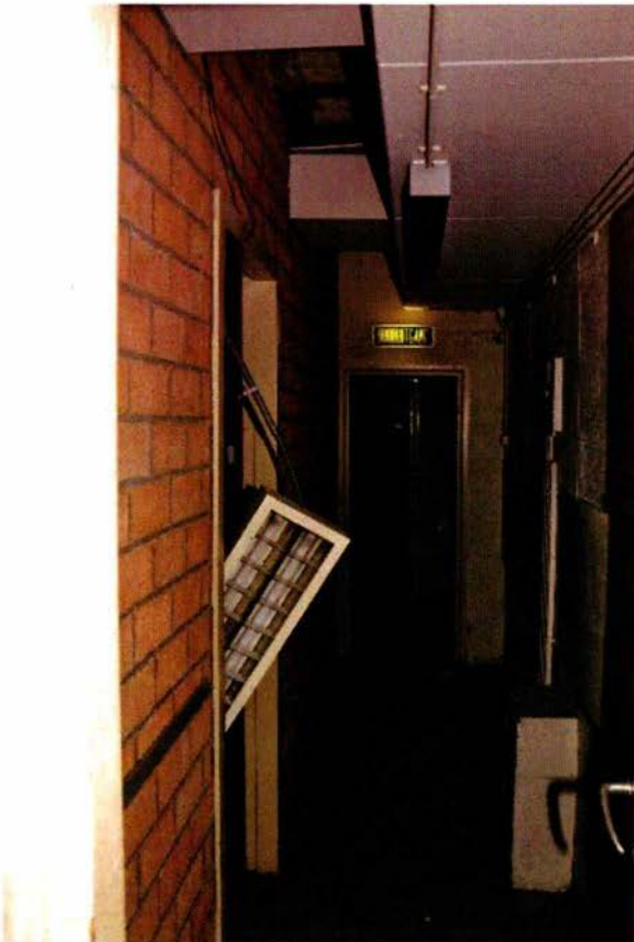
256. Ruimte 031. De west-oostgang gezien naar het oosten. Aan de bovenzijde is het kanaal voor de luchtverversing te zien, met twee aftakkingen naar het noorden (ruimte 029) van verse lucht te voorzien. Tussen beide kanalen is een deel van het zachtboardplafond verwijderd. Dit is de plaats waar de volgende foto is genomen.
