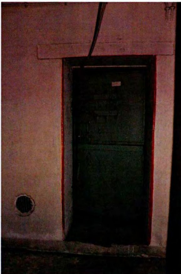
313. Ruimte 104. De zuidwand van het vertrek. De doorgang naar de keuken (ruimte 107) wordt afgeschermd door een pantserdeur van het type 434P01. Links van de deur de uitlaat van het overdrukventiel in ruimte 105.
