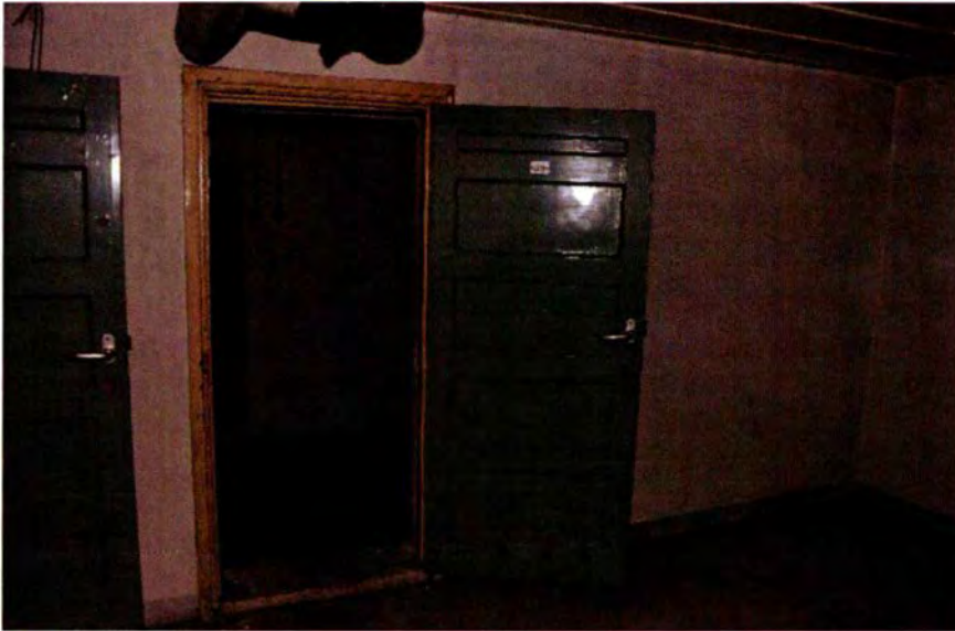
324. Ruimte 106. De westwand met de houten paneeldeur naar ruimte 105. De vier gaten aan de onderzijde van de deur behoren tot de oorspronkelijke opzet. De gaten dienen voor de afvoer van de vuile lucht. Links in beeld een deel van de houten paneeldeur naar ruimte 107.
