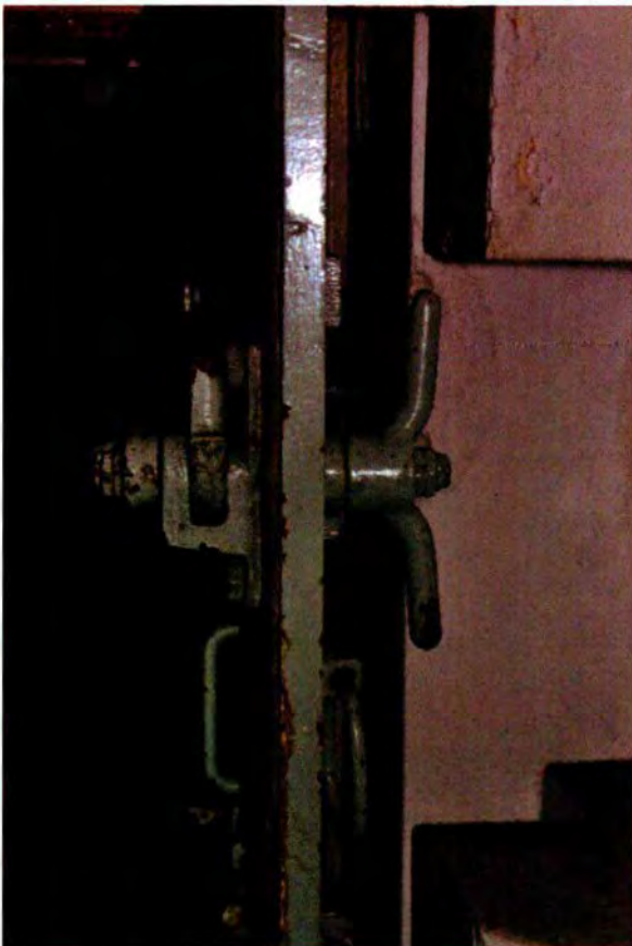
308. Ruimte 103. Detail van de sluiting van de pantserdeur. Tevens is hier goed de dikte van de deur zichtbaar.
