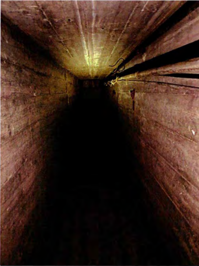
196. Ruimte 020A, zicht naar boven in de luchtuitlaatschacht. Deze schacht gaat naar de zolderruimte, waar die uitkomt in ruimte 201.
