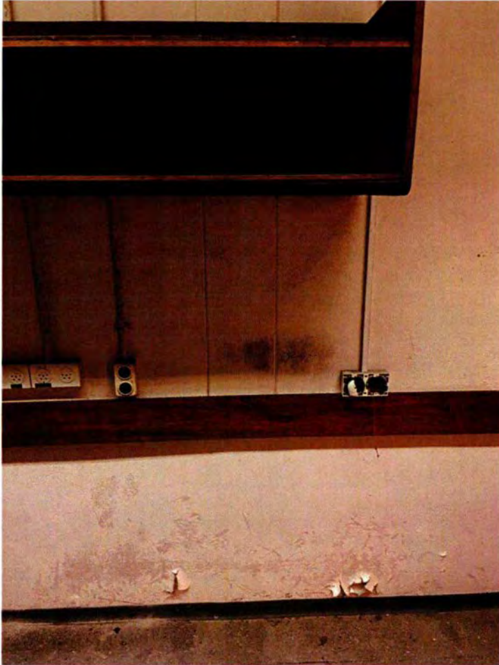
146. Ruimte 014 in zuidelijke richting. Op de wand en de vloer tekent zich nog de oorspronkelijk tussenmuur af die bij wijzigingen in 1948 is verwijderd om één grote ruimte te creëren.
