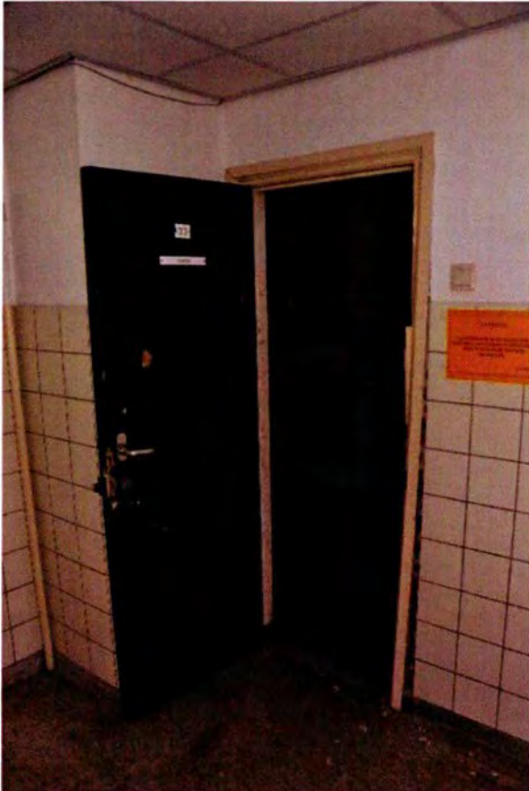
274. De toegangsdeur in de westwand. Het kozijn dateert uit de bouwtijd, de deur is in de KO-periode (1948) aangebracht.
