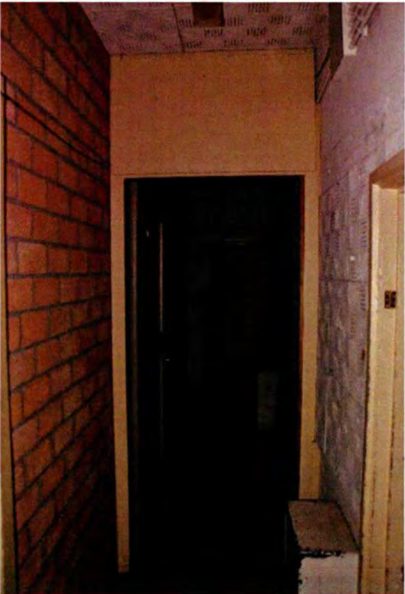
271. De gang 031E, gezien in oostelijke richting. Rechts is de met zachtboard beklede betonnen scheidingmuur zichtbaar. De andere hier zichtbare deuren en muren zijn in de KO-fase tot stand gekomen.
