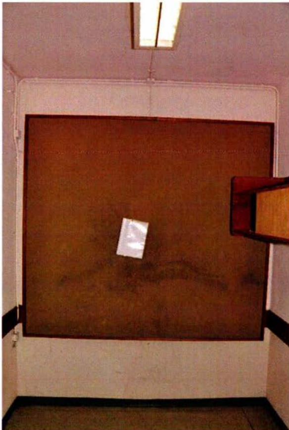
148. Westwand ruimte 015 met prikboard.
