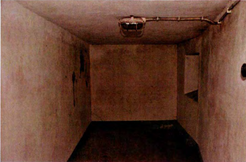
293. Ruimte 034A, gezien in westelijke richting. Rechts bevindt zich het schietgat voor de ingangsverdediging. De wanden en de zoldering zijn gepleisterd en wit gesausd, met een grijs geschilderde plint. De vloer van het vertrek is voorzien van een cementdekvloer. Vermoedelijk dateert de verlichting, inclusief het schakelmateriaal, uit de KO-periode, al kan een datering in de WOII niet worden uitgesloten.
