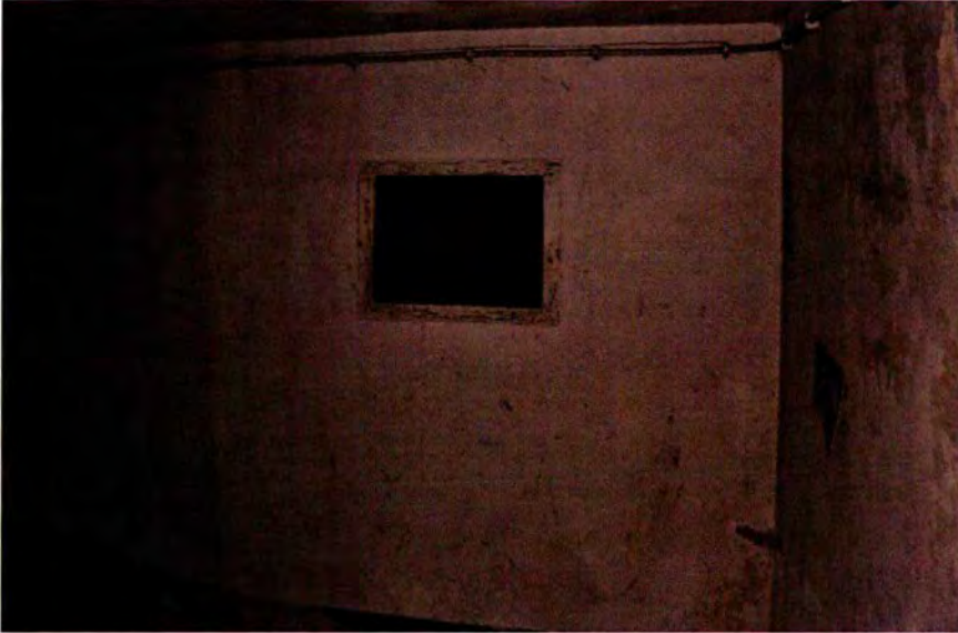
283. Ruimte 034. De zuidwand van de gang ter plaatse van het schietgat van de ingangsverdediging vanuit ruimte 034A. De dagkanten zijn voorzien van hout als verloren bekisting. Het hout moet voorkomen dat inkomende kogels via de dagkanten door het schietgat naar binnen ketsen.
