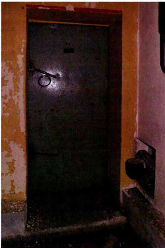
356. Ruimte 112. Tussen de ruimte van de ingangsverdediging en de lucht- of gassluis is een gasdeur met een klein kijkglasje aangebracht (type 19P7). Rechts naast de deur is na WOII (vermoedelijk 1948) een overdrukventiel gemonteerd op de plaats waar bij de bouw ook al een dergelijk ventiel zat.
