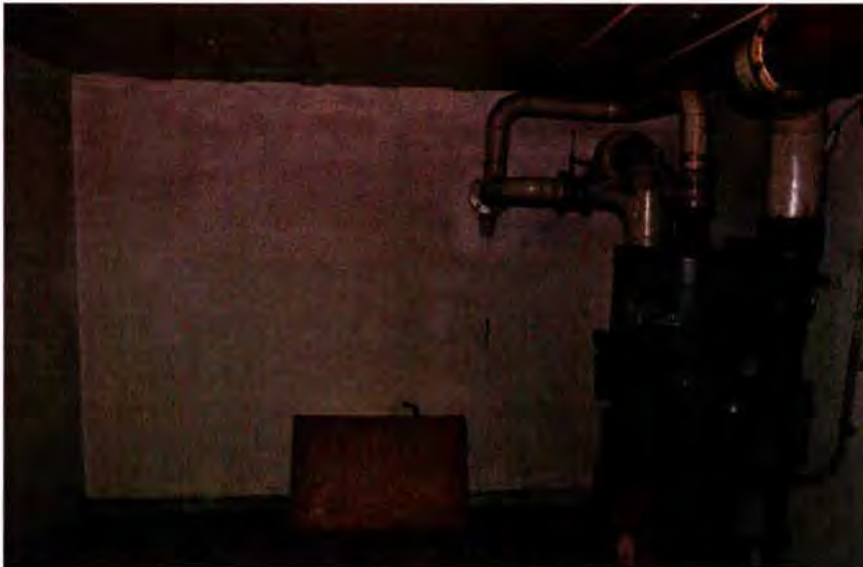
321. Ruimte 106. Overzicht van de noordwand.
