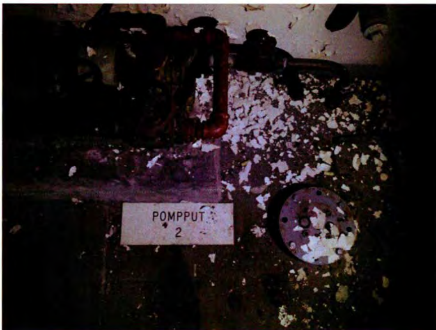
338. Ruimte 108. Waterput met bordje POMPPUT 2. Dit is de waterbron van de keukenbunker.
