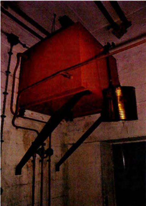
162. Ruimte 018. Een tweede watervat op steunen, dat tegen de noordwand van het vertrek is gemonteerd.
