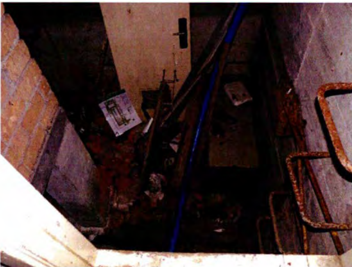
248. Ruimte 030. De doorgang die toegang geeft tot de lage kelderruimte. Rechts een klimtrap.
