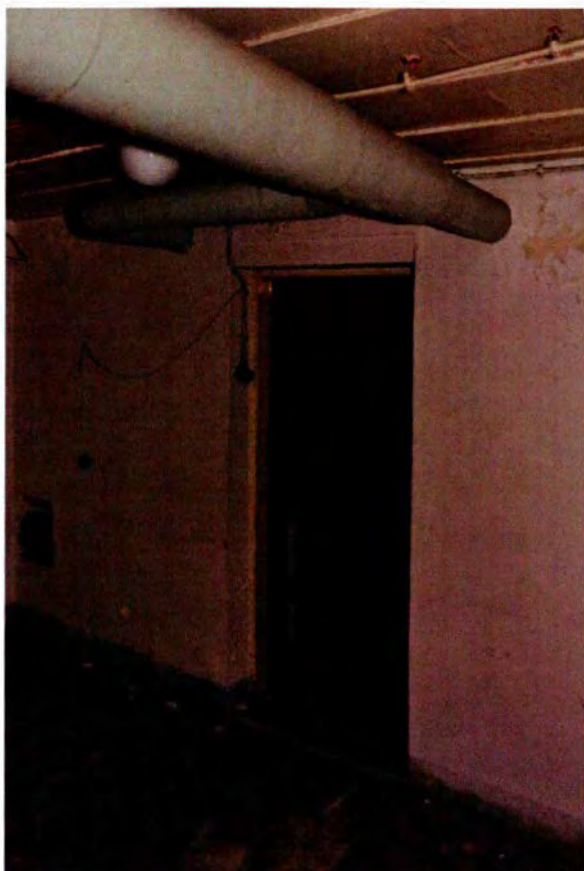
341. Ruimte 109. De oostwand met de deur naar de bijkeuken (ruimte 110).
