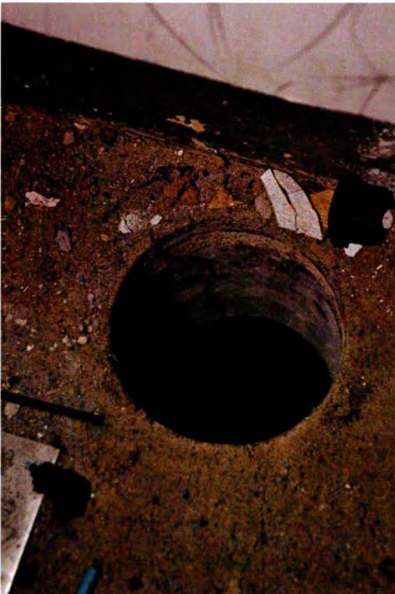
232. Ruimte 028. Detail van de vloer op een plaats waar een gat ten behoeve van kabels is geboord. De vloer bestaat uit gewapend beton met daarop een magnesienvloer. Dat is een vloer met gemalen magnesiet (magnesiumchloride) als bindmiddel en zand, zaagsel, houtvezels of marmersmeel als vulmiddel en eventueel toegevoegde kleurstof. Zoals al is vastgesteld (zie afbeelding 224) dateert de vloer niet uit de bouwtijd van de bunker, maar uit de KO-periode.
