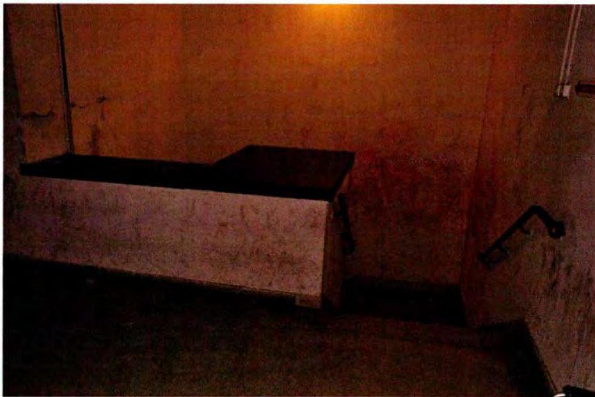
267. Ruimte 031. Overzicht van het bovenste deel van de trap, met de hardstenen dekplaten op de bovenzijde van de muur langs de trap. Rechts is de bovenste van de drie trapvluchten zichtbaar. De rode vlekken op de muur zijn resten van paintballballetjes tijdens een politieoefening, uit de periode van leegstand na 2013.
