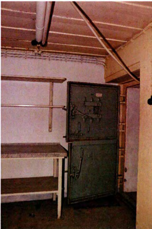
327. Ruimte 107. De noordwesthoek van het vertrek met de tweeledige pantserdeur naar ruimte 104 (de lucht- of gassluis). Opvallend is dat het schietgat aan beide zijden van een schuif is voorzien (zie ook de volgende afbeelding).
