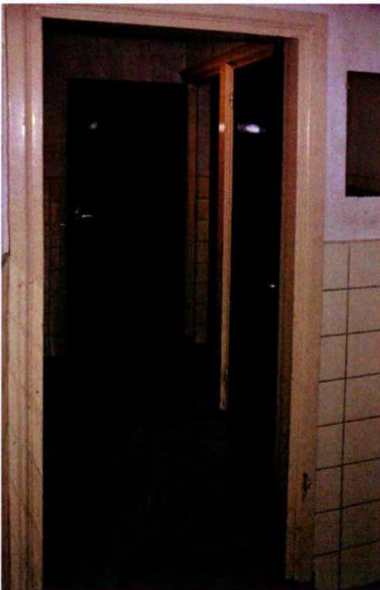
127. Ruimte 009. Zicht vanuit de wasruimte naar de toiletten. De kozijnen en de lijsten dateren uit de bouwtijd. De deuren dateren uit de KO (1948). Bij de toiletten is de lijst boven de deuren doorgetrokken. Die lijst is breder en hoger dan het overige lijstwerk. Oorspronkelijk beëindigde de lijst de wand en was de ruimte erboven open. Na de WOII is de ruimte tussen de wand en het plafond met stijl en regelwerk dichtgezet.
