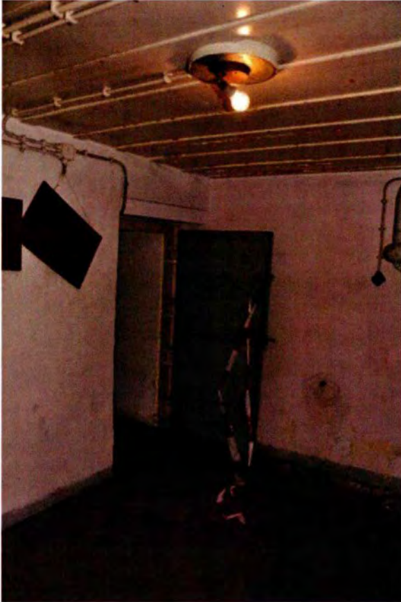
349. Ruimte 111. De zuidoosthoek van de ruimte met de pantserdeur naar de gassluis (ruimte 113) bij de zuidelijke toegang tot de keukenbunker. De deur heeft - net als de pantserdeur tussen de ruimten 104 en 107 - aan beide zijden schuiven voor het schietgat.
