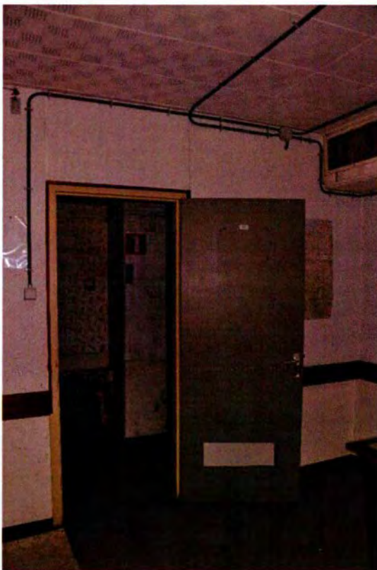
219. Ruimte 025. De zuidwand met de toegang tot het vertrek. Deur en wand zijn na 1983 aangebracht. In tegenstelling tot de vertrekken ten westen van 025 is hier geen luchtbehandelingskanaal aangebracht op de plaats waar zich oorspronkelijk de middengang bevond. In plaats daarvan is langs de west- en noordwand een kanaal aangebracht. Rechtsboven is een klein deel van het kanaal langs de westwand zichtbaar.
