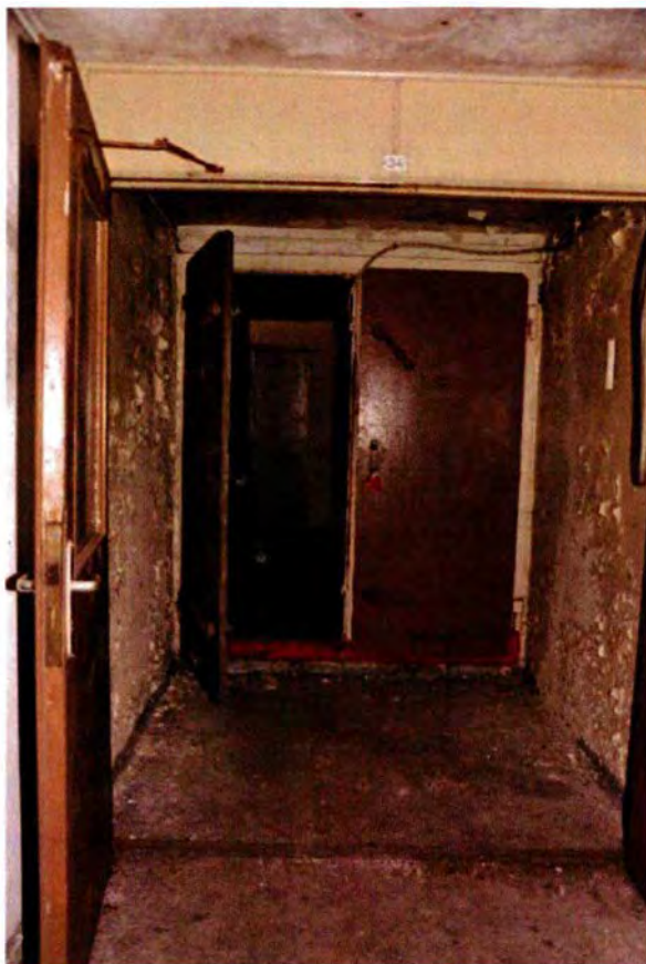
287. Ruimte 034, gezien richting ruimte 033. Op de voorgrond het voorportaal bij de gassluis en toegang tot de hoofdbunker. Op de achtergrond zijn de stalen gasdeuren zichtbaar, die bij ruimte 033 zijn beschreven. Op de voorgrond bevinden zich twee houten deuren, die gedurende de KO (1948) zijn geplaatst en overeenkomen met de houten toegangsdeuren bij de zuidelijke toegang van de bunker.
