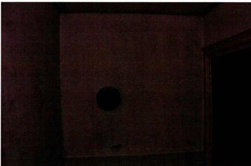
133. Ruimte 011. De noordwand naast het toilet, met daarin opgenomen een overdrukklep uit WOII. Dit ventiel dateert, net als dat in het damestoilet, uit de bouwtijd. Het is niet bekend waarom hier geen zwart overdrukventiel op is geschroefd, zoals bij de andere overdrukkleppen.'
