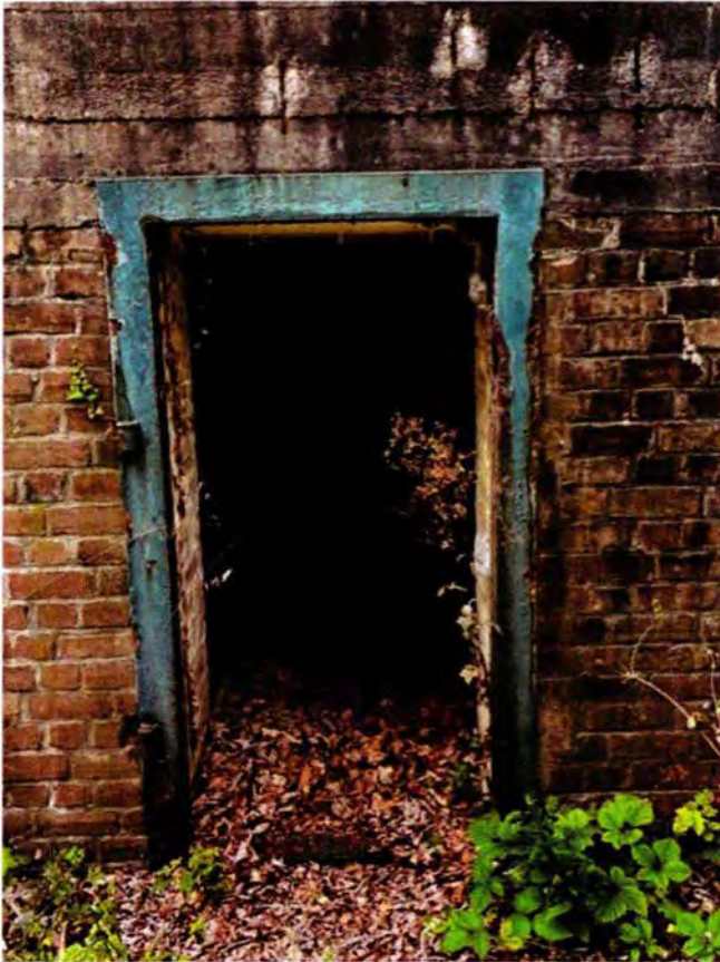
369. De toegang tot de vrijstaande bunker (ruimte 115), gezien vanuit het oosten.
