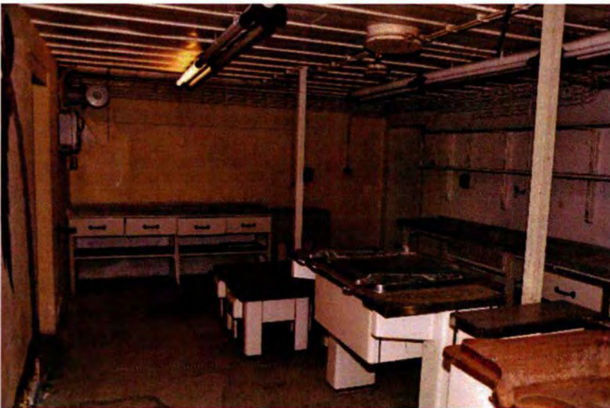
331. Ruimte 107. Zicht op de oostwand van de keukenruimte. Rechts de doorgang naar ruimte 110. Geheel links is een van de luchtinlaten te zien. De werkbanken dateren vermoedelijk van WOII, terwijl de rest van het interieur in de KO is geplaatst.
