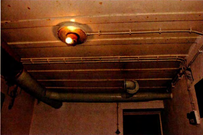
353. Ruimte 111. De zoldering van het vertrek in noordelijke richting. Onder het plafond zijn buizen van de luchtverversingsinstallatie opgehangen. Dit deel zal nog uit de bouwtijd dateren.
