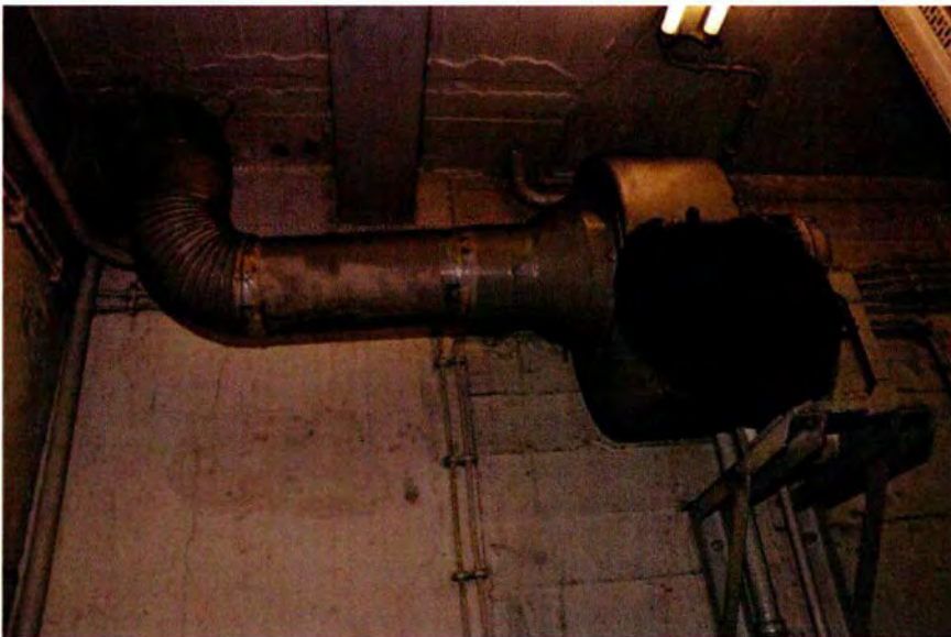
156. Ruimte 017. Deze tegen de oostwand aangebrachte voorziening (derde kwart 20ste eeuw) moest de verse lucht voor de verwarmingsinstallatie verzorgen. De herstelling in de zoldering geeft aan dat in het verleden aanpassingen hebben plaatsgevonden. Hier zaten mogelijk de afvoeren van de oorspronkelijke verwarmingsinstallatie. Het vlakke wanddeel links is waarschijnlijk gepleisterd metselwerk ter plaatse van de onderbouw van de schoorsteen. Rechts is de aftekening van de bekisting op het beton zichtbaar.
