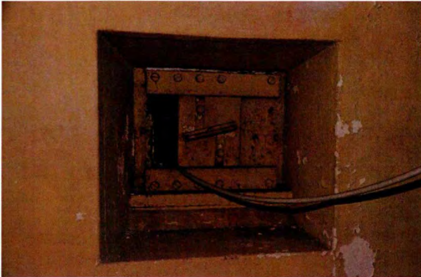
355. Ruimte 112. Detail van het schietgat, dat nog volledig intact is, inclusief een klein deel van de rubber gasdichting. Hier is een schietgat van het type 483P2 toegepast.
