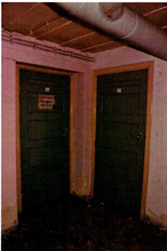
342. Ruimte 109. De zuidwesthoek van het vertrek met twee houten paneeldeuren uit de bouwtijd. De deur rechts geeft toegang tot de ruimte waar zich de waterpomp bevindt (108). Links de deur naar het vertrek, waar de luchtverversingsinstallatie is geplaatst (111).
