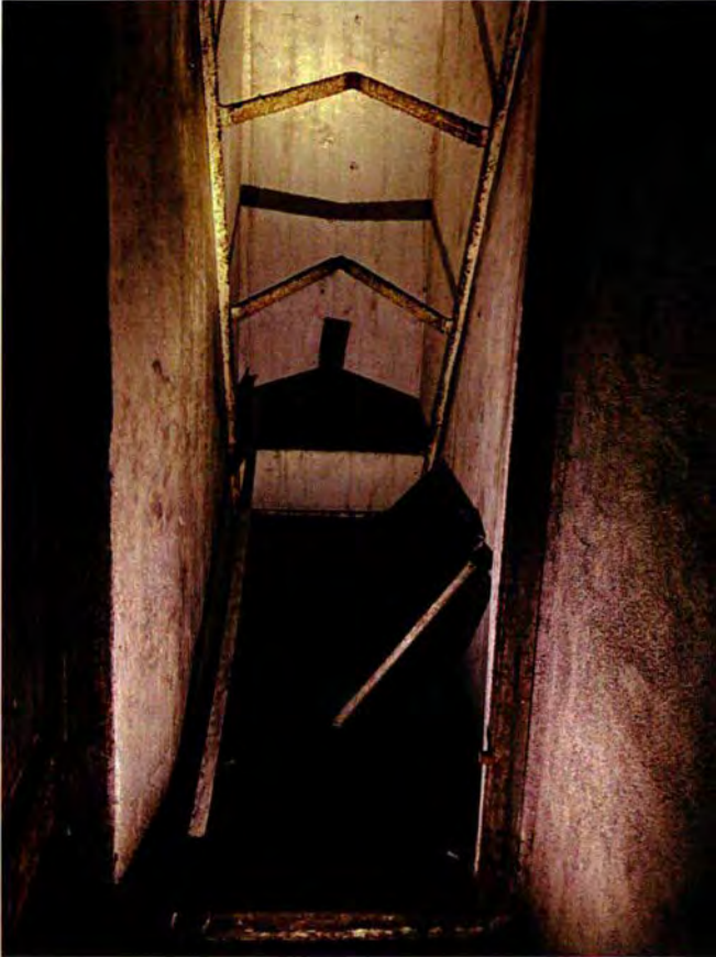
197. Ruimte 020A, zicht in noordelijke richting op de luchtinlaatschacht. Dit is de rechter schacht van de twee. Ook deze schacht gaat naar de zolderruimte, waar die uitkomt in ruimte 204. In de schacht zijn panelen zichtbaar voor filters. Links op de afbeelding de gasdeur voor het afsluiten van deze schacht. In een oorlogssituatie kon deze gasdicht worden afgesloten om eventueel besmette lucht vanuit de zolderruimte tegen te houden.
