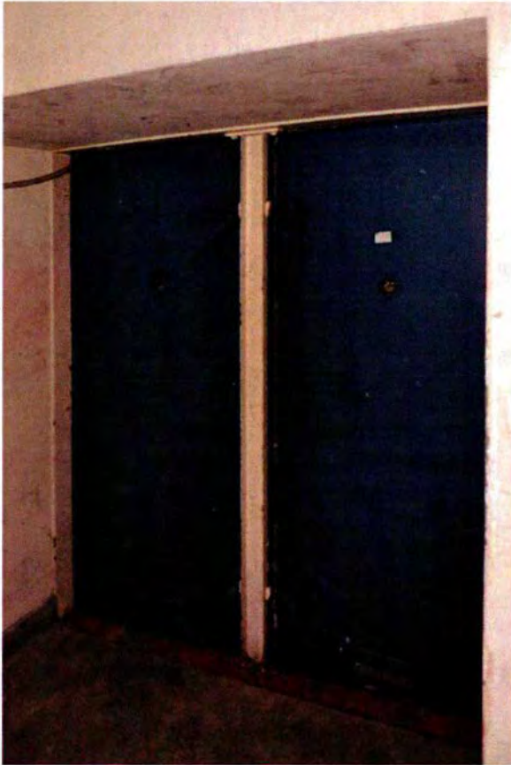
278. Ruimte 033. De binnenste dubbele deur van de gasluis, gezien vanuit de bunker (de foto is genomen in ruimte 031). De tussenstijl is nog aanwezig.
