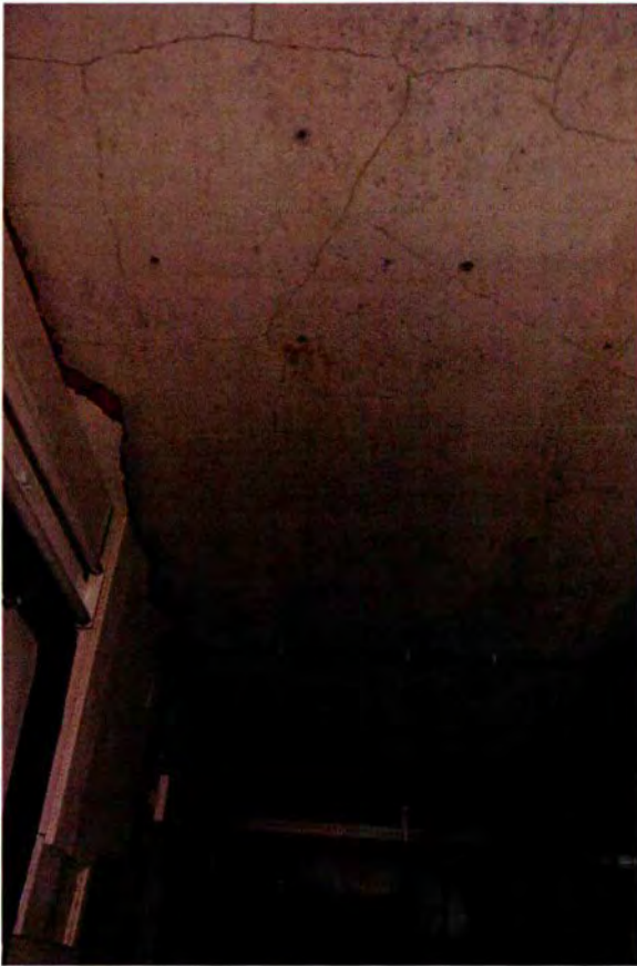
229. Ruimte 028. Detail van de zoldering. De betonnen vloer is voorzien van een gestucte en wit gesausde afwerking. Na WOII is hiertegen een plafond van zachtboardplaten aangebracht. De kooi van Faraday rechts op de foto belemmert de mogelijkheid om de sporen van de verdwenen onderverdeling nader te onderzoeken.
