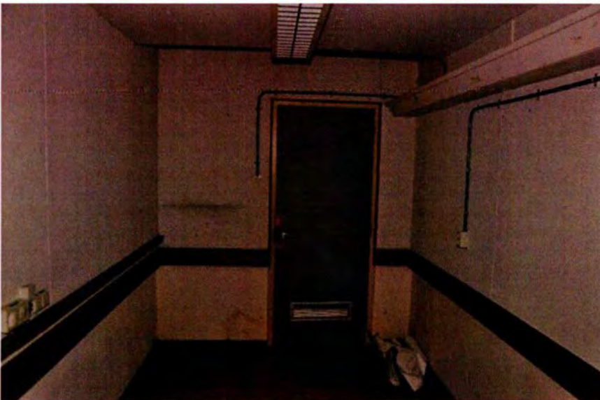
216. Ruimte 024A in zuidelijke richting met de toegangsdeur. De planken langs de wanden dienen om beschadiging van het zachtboard door stoelen te voorkomen.
