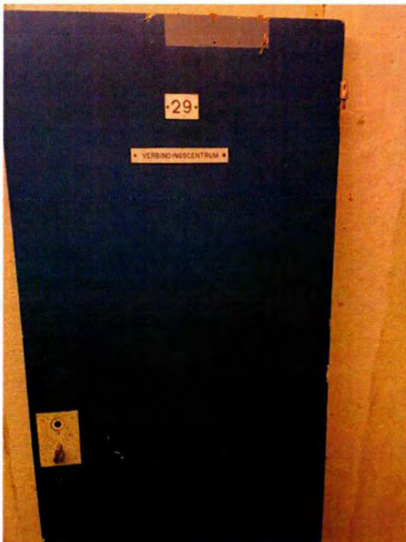
254. Ruimte 030B. In deze ruimte staat een toegangsdeur van het verbindingscentrum. Dit was waarschijnlijk de tussendeur in de gang van ruimte 031 richting 031E. Deze deur heeft aan de binnenkant een drukbar, aangezien de deur ook de doorgang is naar de nooduitgang. Aan de buitenzijde ontbreekt de deurklink. In het verbindingscentrum werden geheime berichten ontvangen. Toen deze deur in gebruik was, was dit blijkbaar geen ingang naar het verbindingscentrum.
