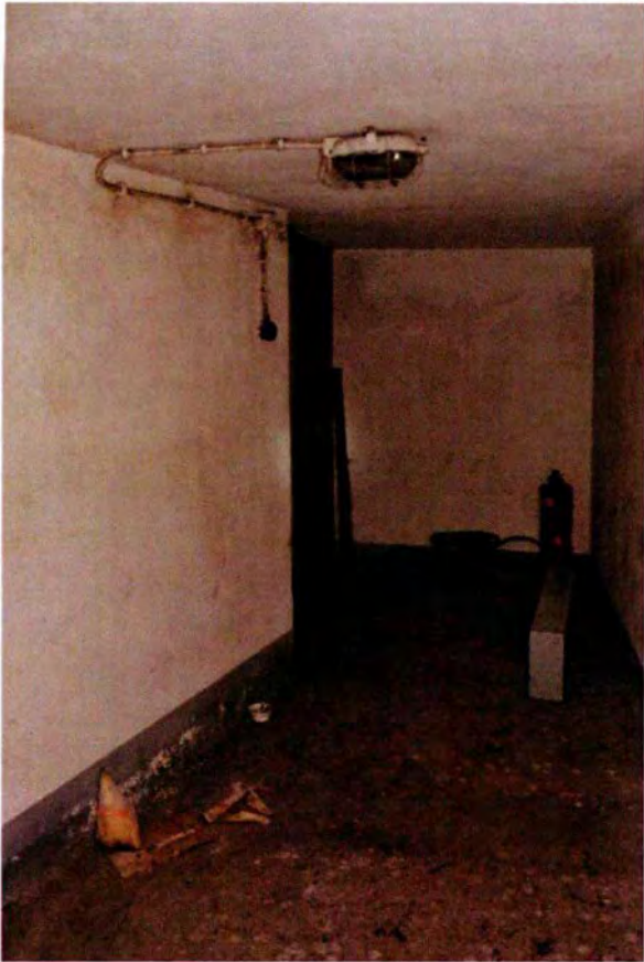
295. Ruimte 034A, gezien naar het oosten.
