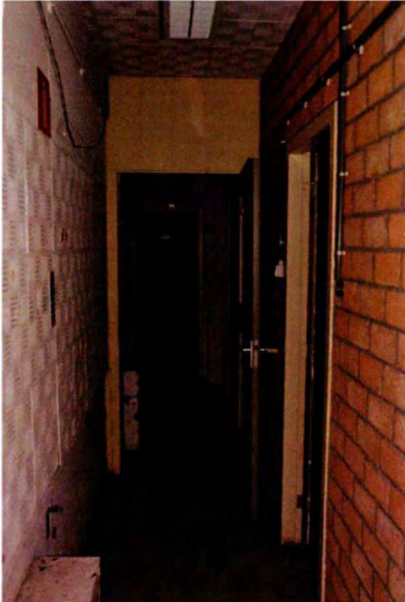
268. Ruimte 031E. Overzicht van de gang, in westelijke richting. Rechts het schoon metselwerk van porisosteent van de noordwand van de gang. Links is de met zachtboard beklede betonnen scheidingsmuur in het midden van de bunker zichtbaar. De deuren, zoldering en vloerafwerking dateren alle uit de KO (1948).
