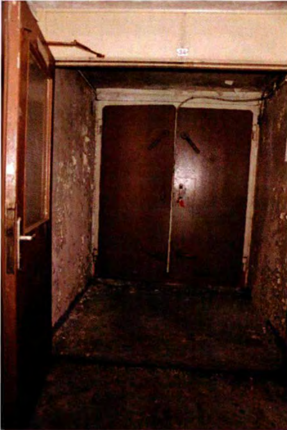
276. Ruimte 033. Dezelfde doorgang, gezien vanaf de buitenzijde, met beide deuren in gesloten toestand. Wat de kleurstelling van deze en andere deuren is geweest, zal in het kleurenonderzoek worden behandeld. Links naast de deuren is de uitlaat van het overdrukventiel zichtbaar. Geheel links in beeld een van de houten deuren van het voorportaal uit de KO (1948).
