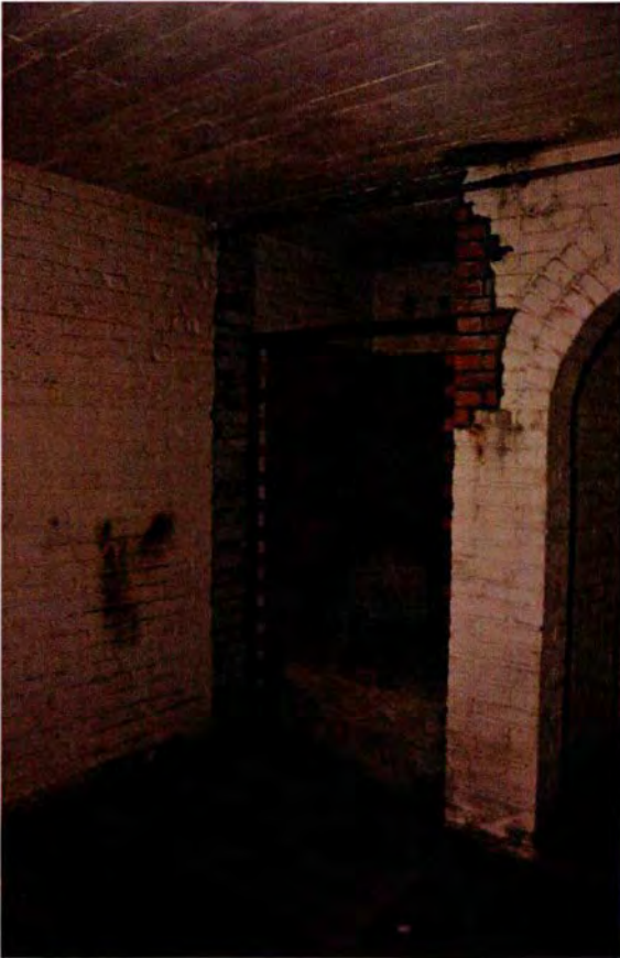
391. Ruimte 003. De nooit voltooide oven in de noordelijke nis. Het aanbrengen van de oven zal een wijziging zijn ten opzichte van het oorspronkelijke plan, aangezien voor de bouw ervan de getoogde bovenzijde van de nis is verwijderd. Tevens is achter het metselwerk van de oven te zien dat het metselwerk is witgesausd. Het gesausde metselwerk zet zich door tot aan de onderzijde.
