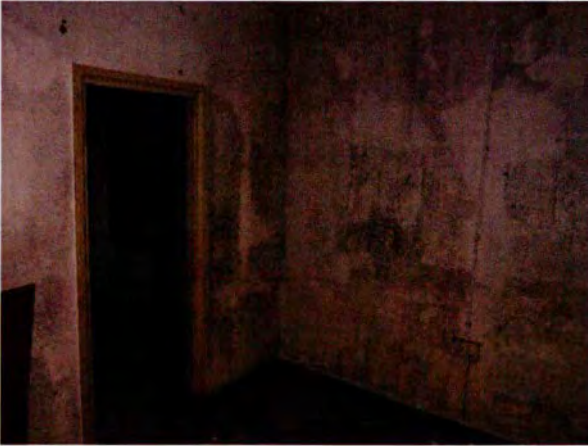
121. Ruimte 007 naar het zuidwesten, met een inkijk in ruimte 006.
