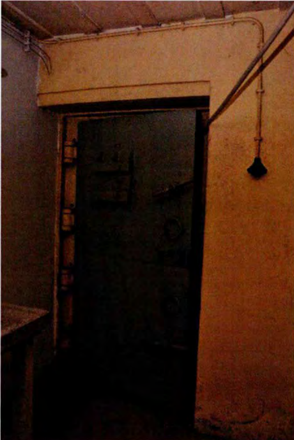
328. Ruimte 107. De pantserdeur in gesloten toestand. Net als aan de andere zijde van de deur is hier een schuif om het schietgat af te sluiten. De deur is tweeledig. Als er rommel/afval voor de deur komt te liggen, kan men via de bovenzijde er nog uit.
