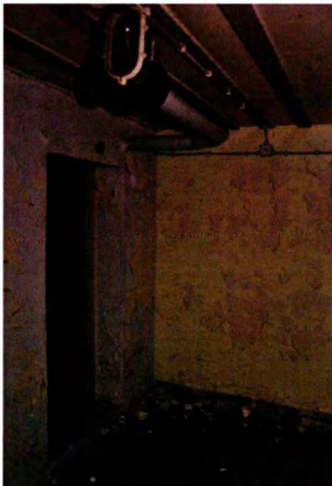
316. Ruimte 105. Het zuidelijke deel van oostwand (links) met de doorgang naar ruimte 106. Deze doorgang heeft een houten deur uit de bouwtijd (zie beschrijving ruimte 106).
