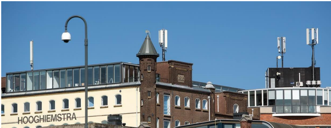
Figuur 21. Antenne-opstelpunten in Utrecht (bron: antennebureau.nl )
