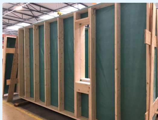
figuur 5: HSB-gevelement voorzien van dampremmende folie
