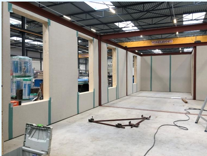
figuur 6: unitbouw: HSB-gevelementen in stalen frames
