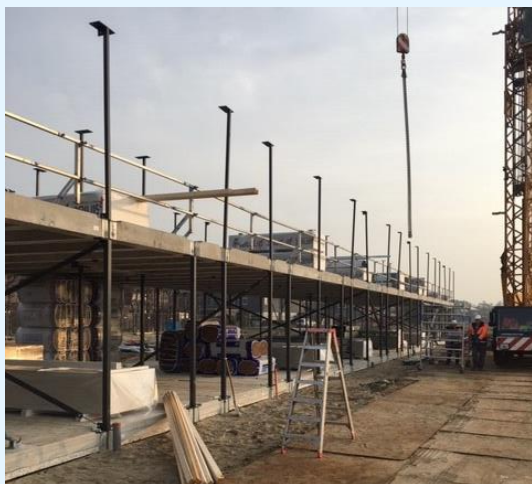
figuur 2: voorbeeld draagconstructie elementenbouw
