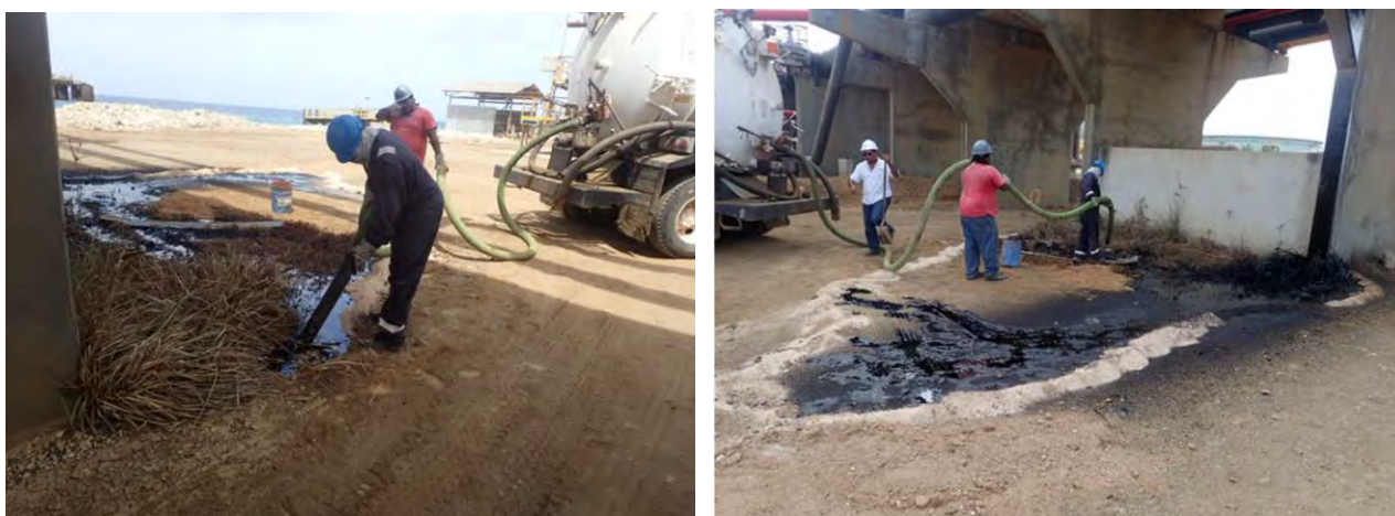
Figuur 3-9: Lekkage van de 36" Jetty productleiding op 30 May 2019
