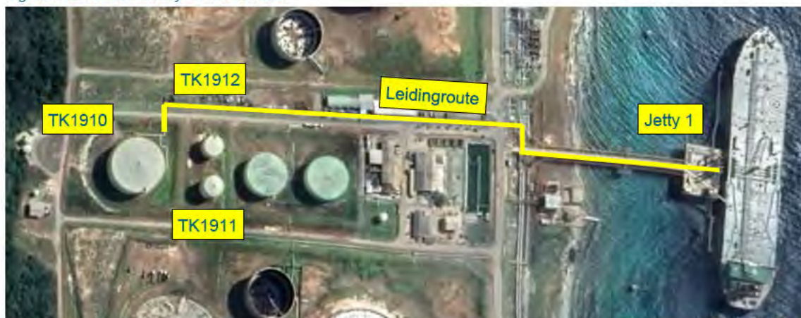
Figuur 3-2: Overzicht Jetty 1 en IFO tanks
