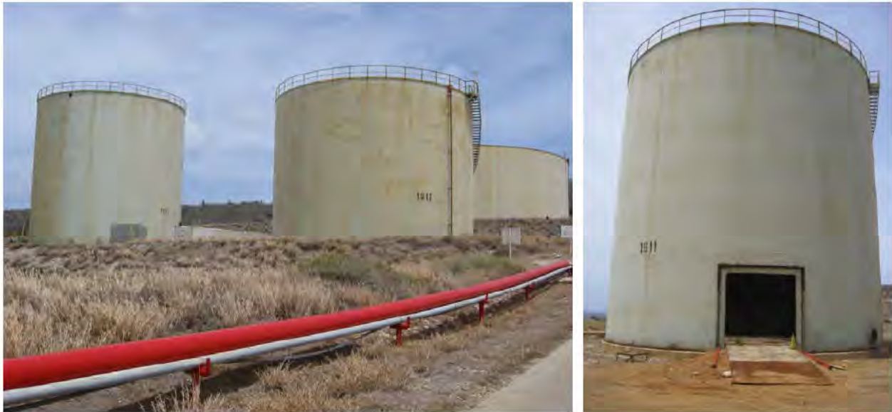
Figuur 3-11: Tanks TK1912 en TK1911 met TK1910 op de achtergrond/ Tank TK1911 geopend voor onderhoud
