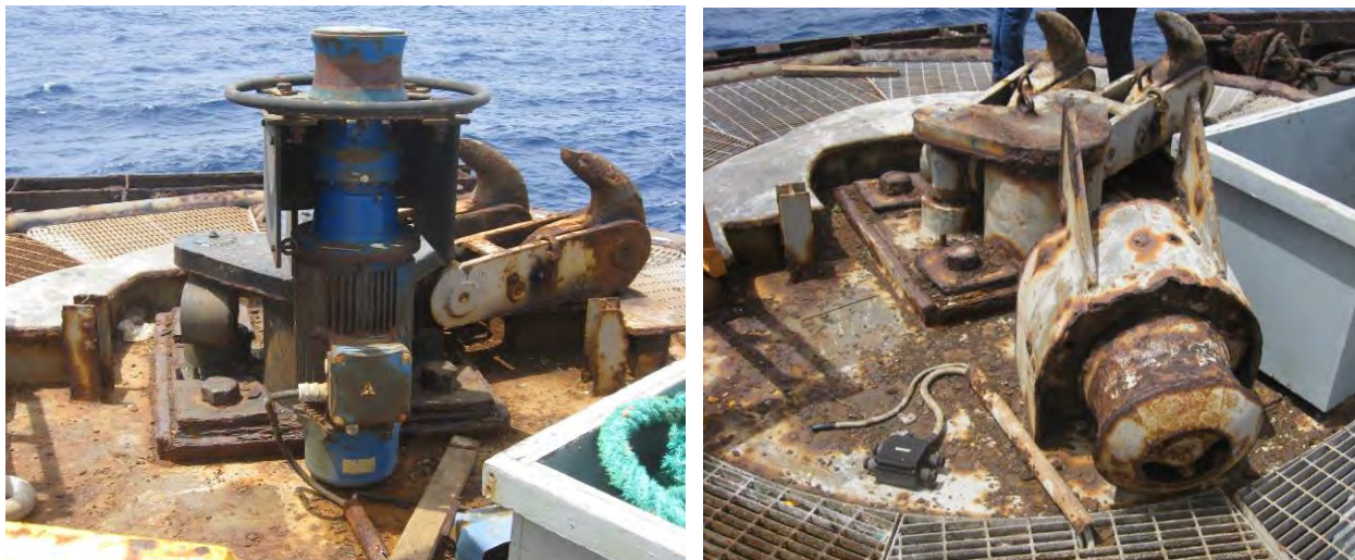
Figuur 3-6: Overzicht conditie afmeerhaken
