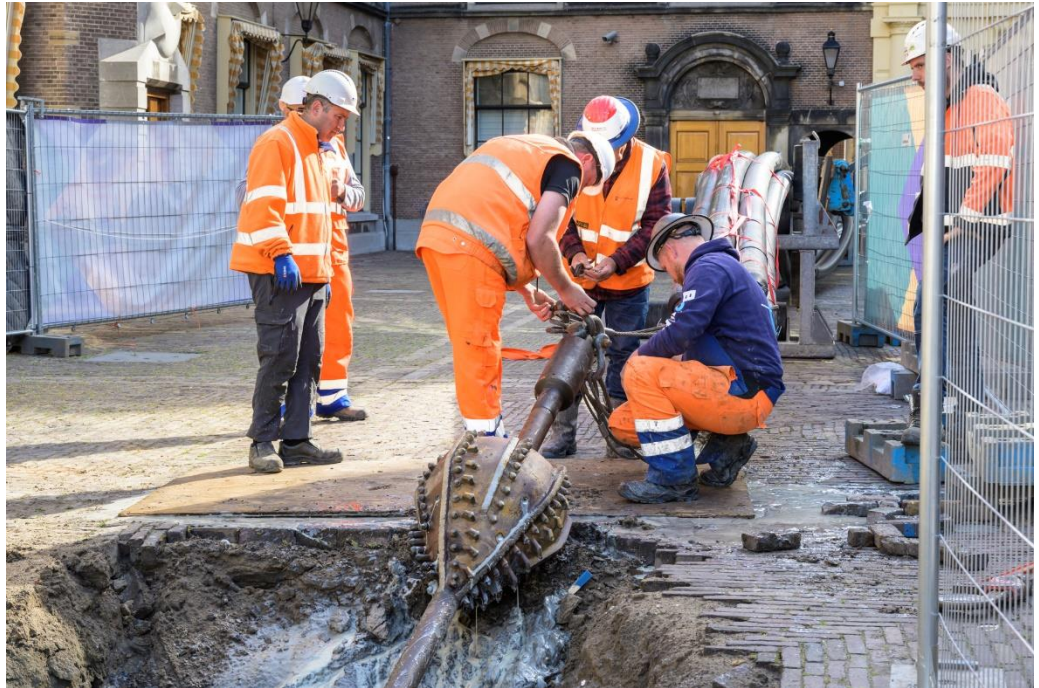
Werkzaamheden kabels en leiding, Tineke Dijkstra
