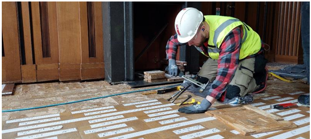
Werkzaamheden vloer Raadzaal, Michiel Hartkamp
